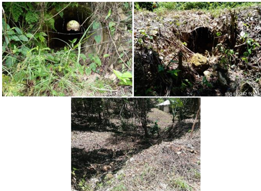
Figura 36. Condiciones generales de la obra de drenaje ubicada en el km 19+880.190.
