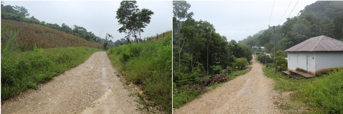
Figura 5. Condiciones del camino actual
