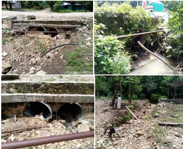
Figura 45. Condiciones generales de la obra de drenaje ubicada en el km 22+304.730.
