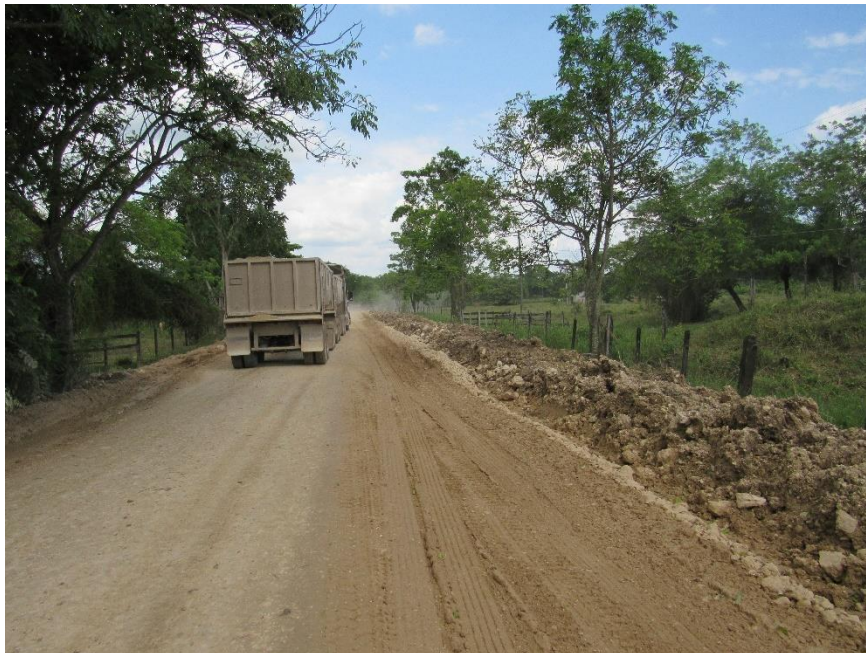
Figura 132. Aspecto general del Km 32+000, domina el pastizal en las colindancias, polígonos de afectación Pol Afec 69 PC, por ser un camino que utiliza los de la obra del Tren Maya, lo acondicionaron los de la constructora.
