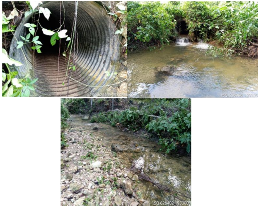
Figura 30. Condiciones generales de la obra de drenaje ubicada en el km 18+809.60.
