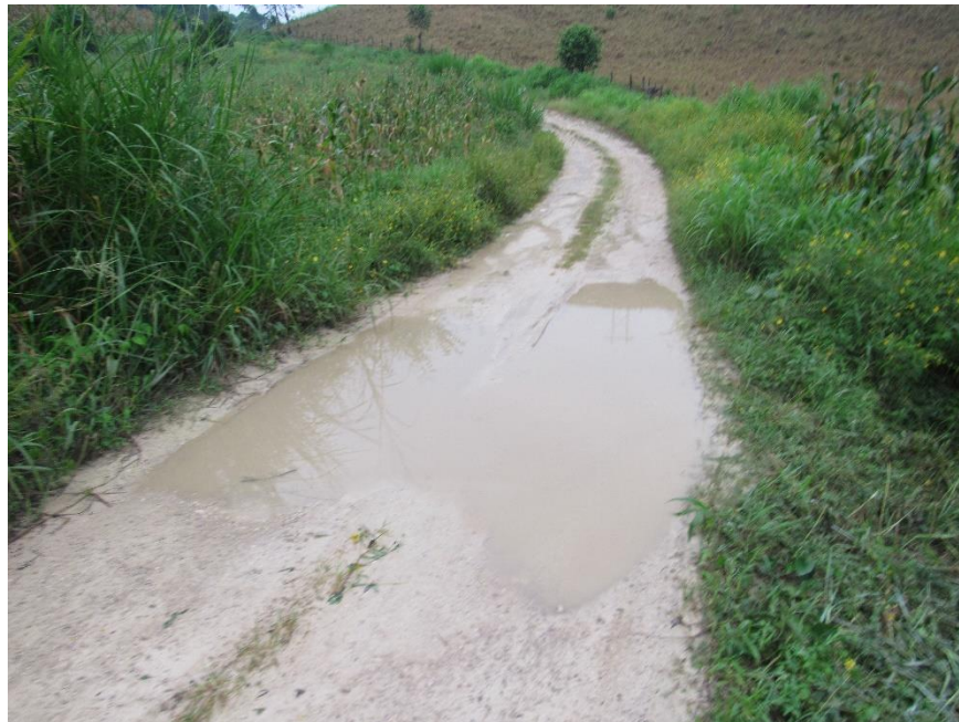
Figura 121. Aspecto general del Km 20+360, domina el pastizal en las colindancias, polígonos de afectación Pol Afec 32 PC y Pol Afec 33 PC, dominan los pastos en las colindancias
