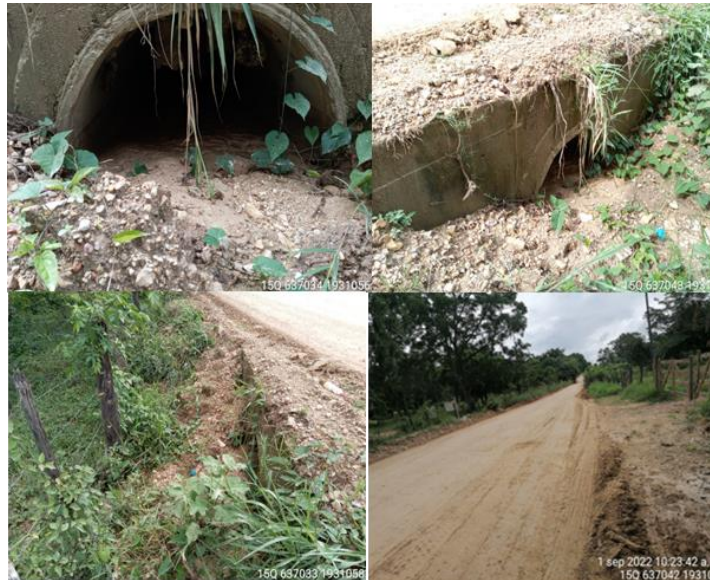
Figura 72. Condiciones generales de la obra de drenaje ubicada en el km 31+196.310.
