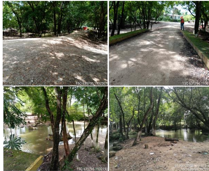
Figura 66. Condiciones generales de la obra de drenaje ubicada en el km 29+358.930.
