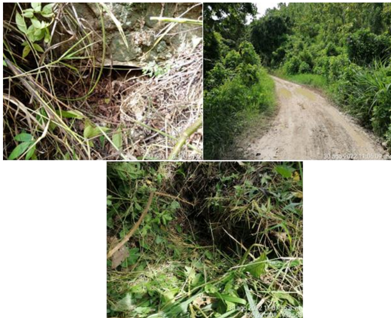
Figura 51. Condiciones generales de la obra de drenaje ubicada en el km 24+354.580.
