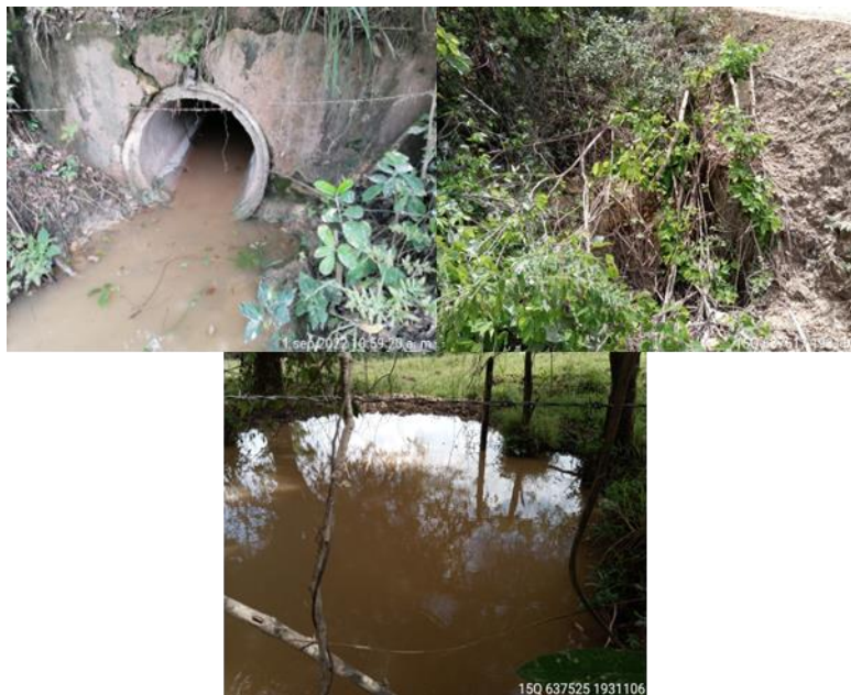
Figura 75. Condiciones generales de la obra de drenaje ubicada en el km 31+686.180.
