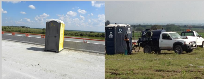
Figura 2. Colocación y limpieza de baños portátiles
