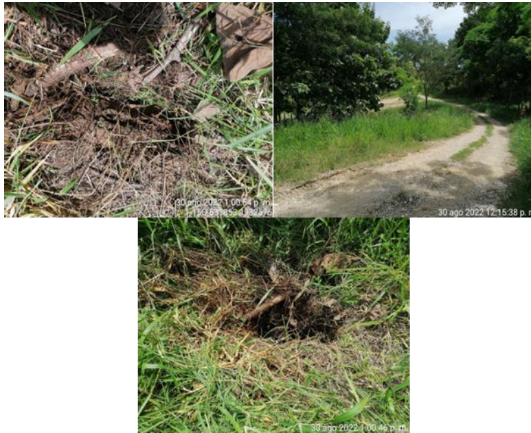
Figura 54. Condiciones generales de la obra de drenaje ubicada en el km 25+035.350.
