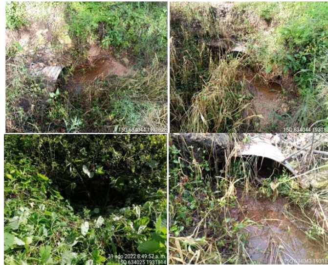
Figura 60. Condiciones generales de la obra de drenaje ubicada en el km 27+388.410.
