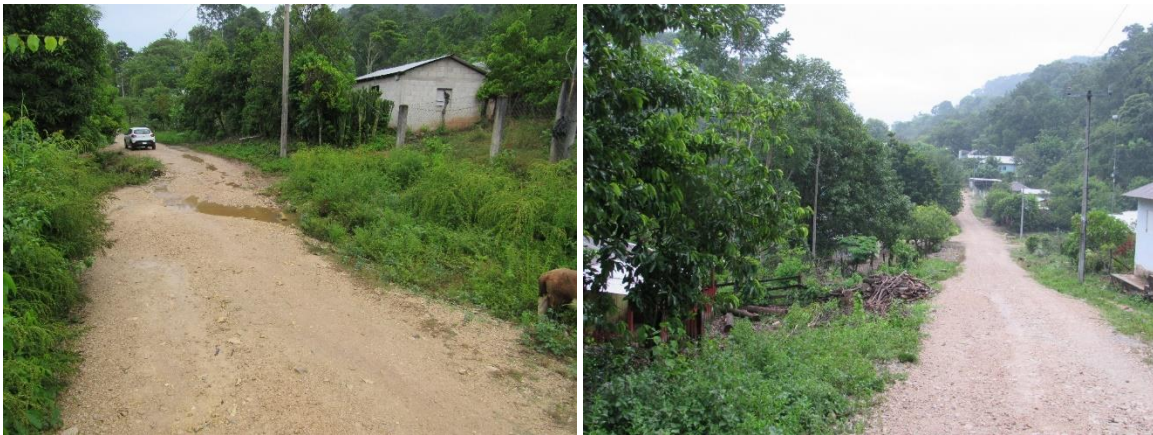
Figura 123. Aspecto general del Km 22+020, domina el pastizal en las colindancias, polígonos de afectación Pol Afec 40 AH y Pol Afec 41 AH
