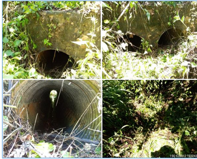
Figura 33. Condiciones generales de la obra de drenaje ubicada en el km 19+597.013.
