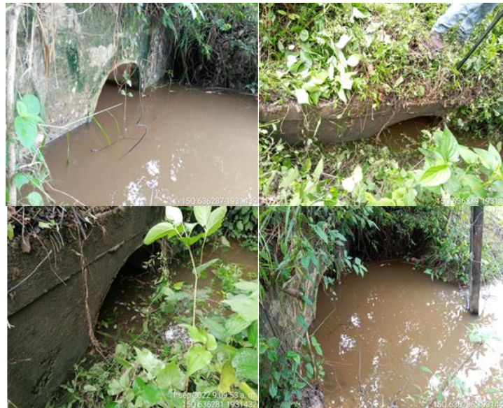
Figura 69. Condiciones generales de la obra de drenaje ubicada en el km 30+334.200.
