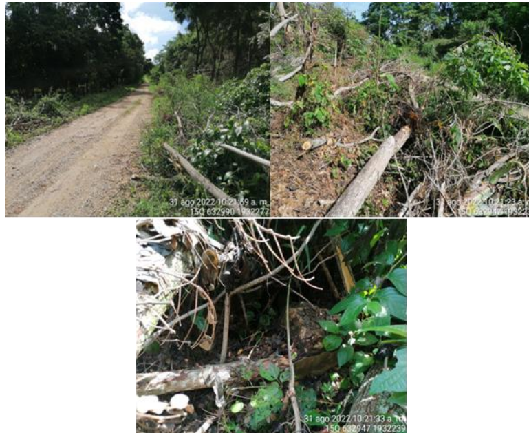
Figura 57. Condiciones generales de la obra de drenaje ubicada en el km 26+221.330.
