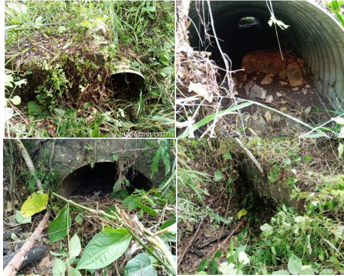
Figura 48. Condiciones generales de la obra de drenaje ubicada en el km 23+295.246.
