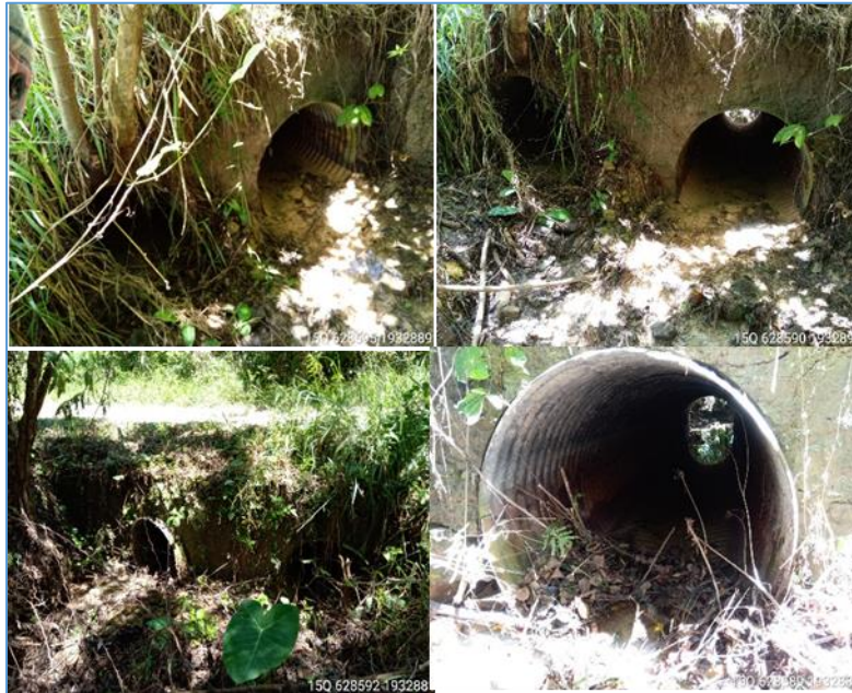
Figura 42. Condiciones generales de la obra de drenaje ubicada en el km 21+617.210.
