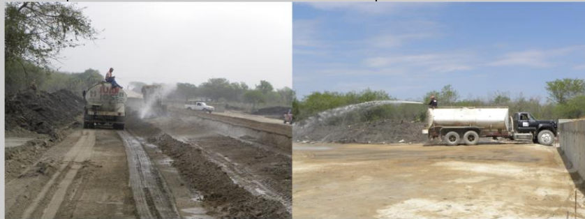
Figura 5. Ejemplo de riego de la capa superficial
