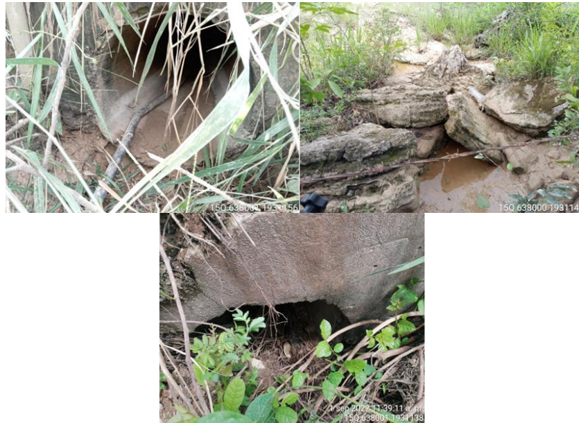
Figura 78. Condiciones generales de la obra de drenaje ubicada en el km 32+168.300.
