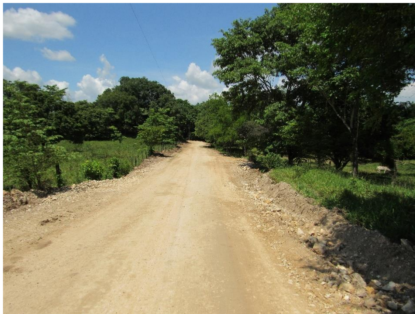
Figura 130. Aspecto general del Km 29+800, domina el pastizal en las colindancias, polígonos de afectación Pol Afec 63 PC y Pol Afec 64 , dominan los pastos en las colindancias
