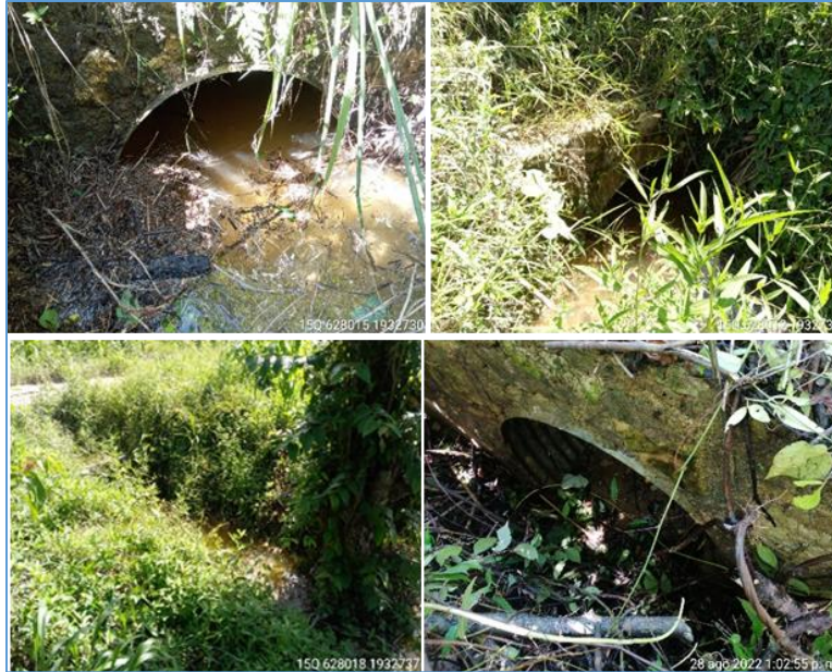
Figura 39. Condiciones generales de la obra de drenaje ubicada en el km 20+861.240.
