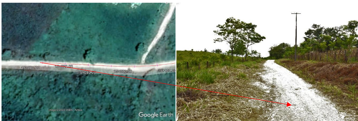
Figura 8. Vista del inicio del proyecto en el km 15+000, las condiciones de tránsito son muy desfavorables sobre todo en temporadas de lluvias como se observa en la imagen. Aquí el camino cuenta con un ancho de 3.80 m.
