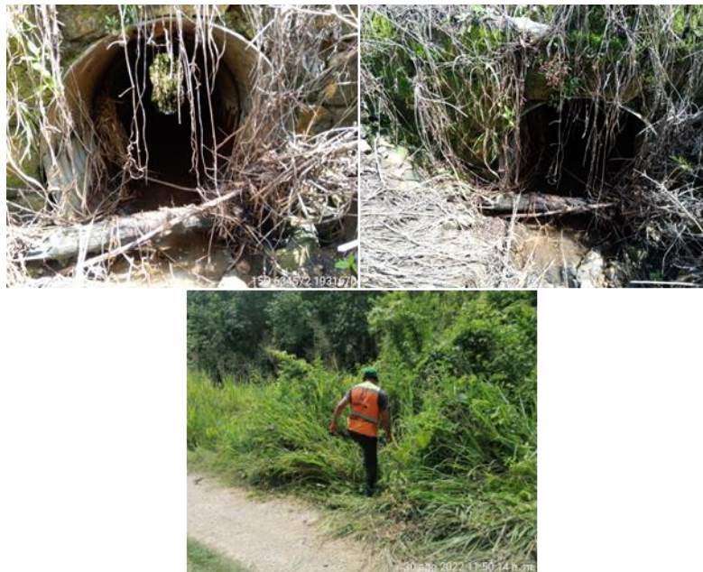
Figura 63. Condiciones generales de la obra de drenaje ubicada en el km 27+955.600.
