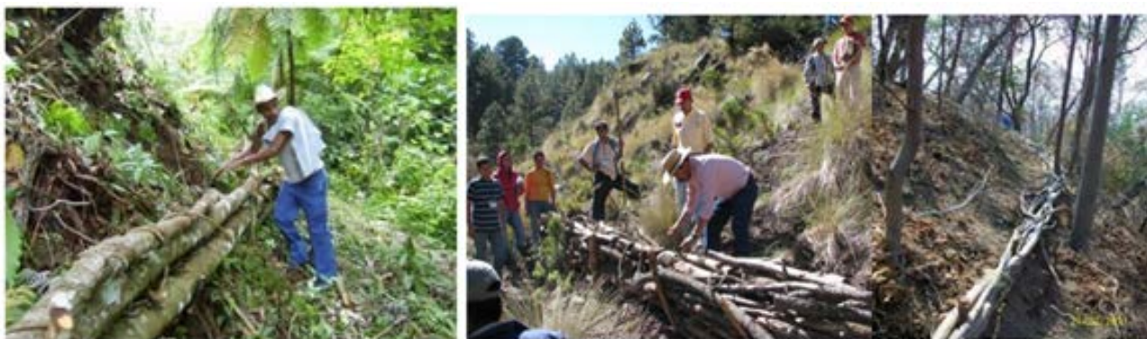
Imagen 5. Ejemplo de acomodo de material vegetal muerto en curvas de nivel.
