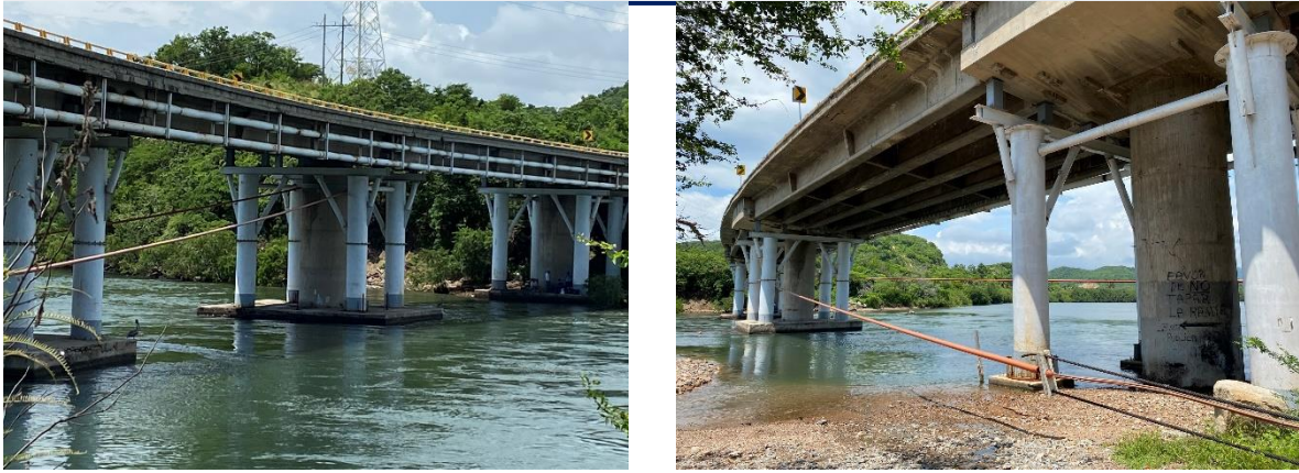
Figura II.3. Puente Tepalcates II con Obras de reforzamiento.
