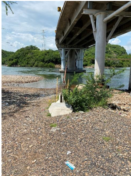
Fotografía IV.7. Zona de afectación por obra donde se realizará el nuevo puente Tepalcates II.
