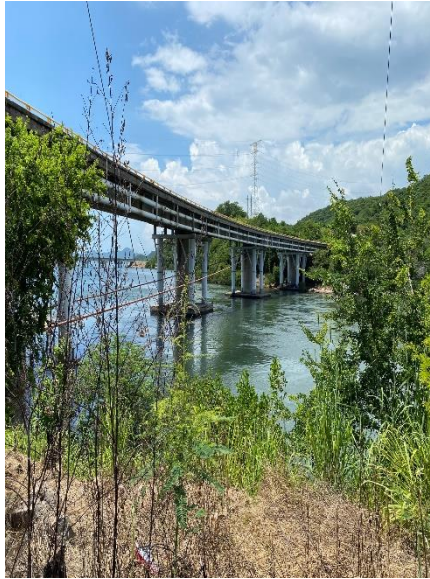
Fotografía IV.6. Zona de afectación por obra donde se realizará el nuevo puente Tepalcates II.
