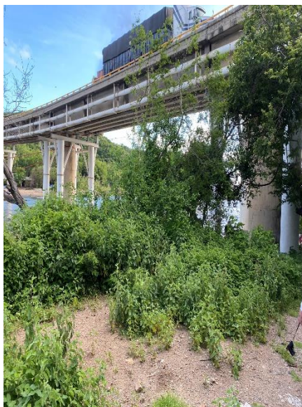
Fotografía IV.8. Zona de afectación por obra donde se realizará el nuevo puente Tepalcates II.
