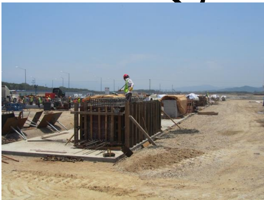
Foto II. 31 Ejemplo de suministro tendido y vibrado de concreto.
