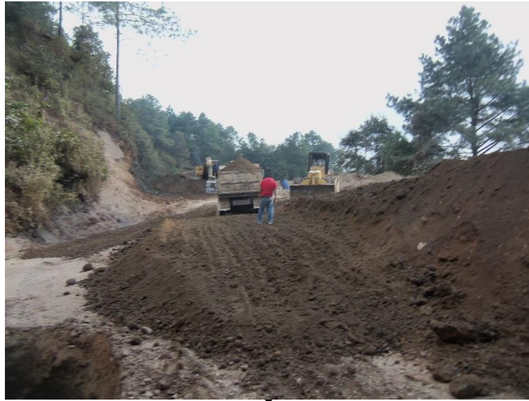
Foto II. 6 Ejemplo de retiro de materia vegetal. FUENTE: PROPIA.
