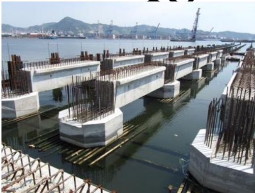
Foto II. 36 Ejemplo de montaje de traveses prefabricados.
