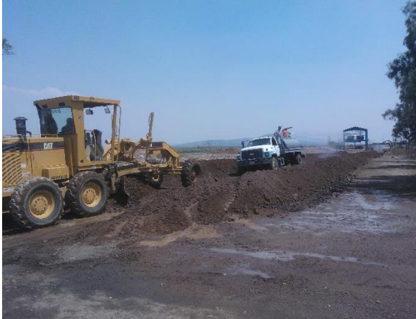
Foto II. 8 Ejemplo de conformación de capa de Subrasante. FUENTE: PROPIA.
