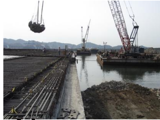
Foto II. 34 35 Ejemplo de colocación de dique de retención y escollera.
