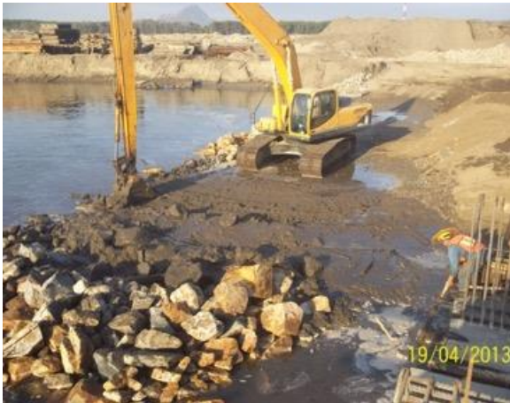
Foto II. 46 Ejemplo de pedraplén y coraza en muelle.
