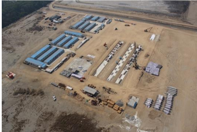
Foto II. 48 Ejemplo limpieza y retiro de material sobrante de la obra. FUENTE: CONTECON MANZANILLO, S.A. DE C.V.
