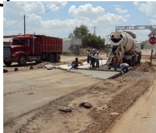
Foto II. 17 Ejemplo suministro y tendido de concreto.
