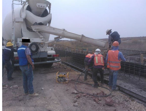
Foto II. 24 Ejemplo de colado de concreto premezclado. FUENTE: PROPIA.
