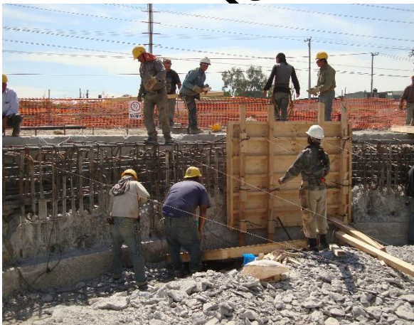
Foto II. 25 Ejemplo de habilitado de cimbra para muro. FUENTE: PROPIA.
