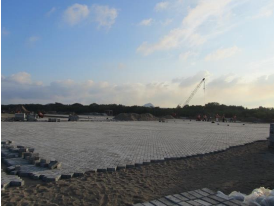
Foto II. 12 Ejemplo de instalación de pavimento de adocreto.
