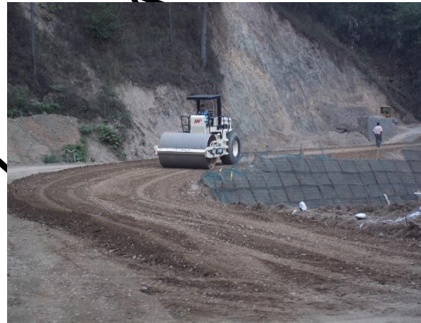
Foto II. 11 Ejemplo de compactación de capa de Base Cementada. FUENTE: PROPIA.
