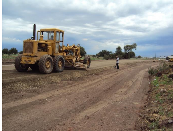
Foto II. 9 Ejemplo de conformación de capa de Subbase. FUENTE: PROPIA.
