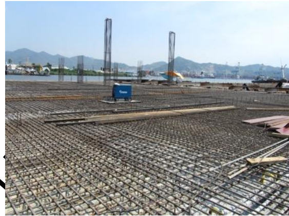
Foto II. 39 Ejemplo de habilitado de acero de refuerzo y cimbra.
