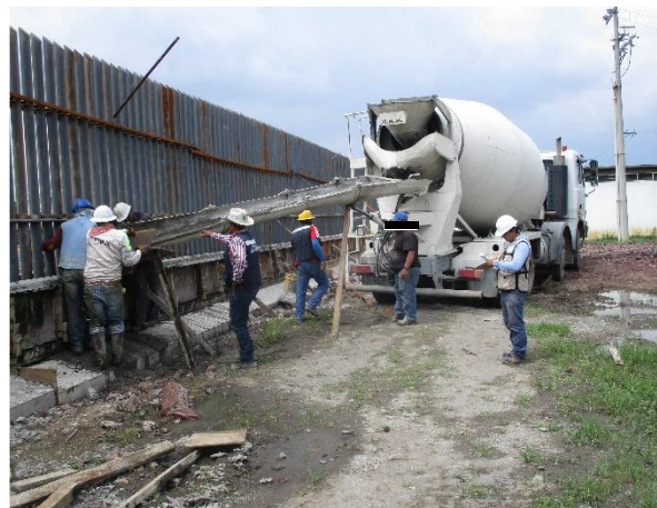
Foto II. 26 Ejemplo de colado de concreto premezclado en muros. FUENTE: PROPIA.
