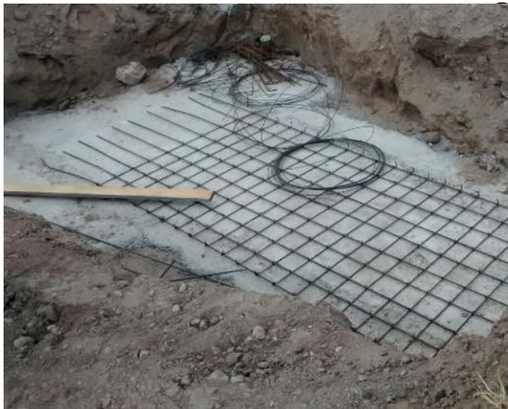
Foto II. 16 Ejemplo de habilitado de acero de refuerzo en losa de cimentación.
