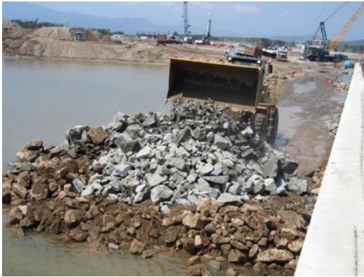
Foto II. 33 Ejemplo de colocación de dique de retención y escollera.
