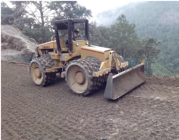
Foto II. 10 Ejemplo de conformación de capa de Subbase. FUENTE: PROPIA.
