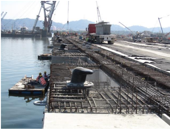
Foto II. 29 Ejemplo de habilitado de acero de refuerzo y cimbra.
