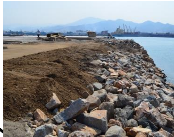
Foto II. 47 Ejemplo de pedraplén y coraza en muelle.
