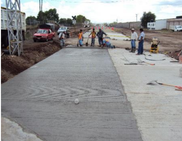
Foto II. 18 Ejemplo suministro, tendido y vibrado del concreto.
