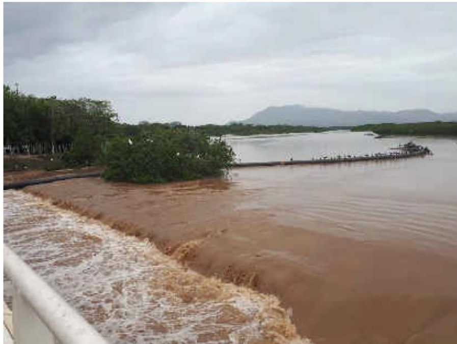
Figura IV. 43. Barrera artificial entre Laguna de Las Garzas y San Pedro. Vista de gaviones (arriba) y efecto de escorrentía en época de lluvias (abajo).
