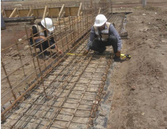
Foto II. 23 Ejemplo de habilitado de acero para cimentación. FUENTE: PROPIA.
