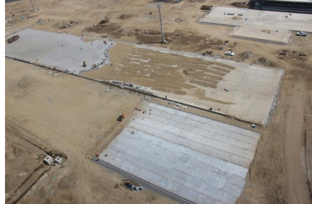
Foto II. 13 Ejemplo de instalación de pavimento de adocreto.
