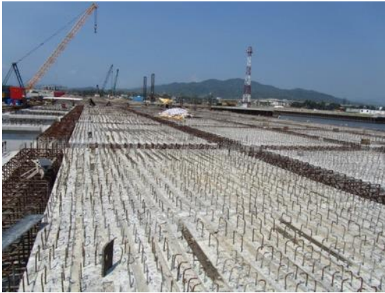
Foto II. 38 Ejemplo de colocación de prelosas prefabricadas en muelle.
