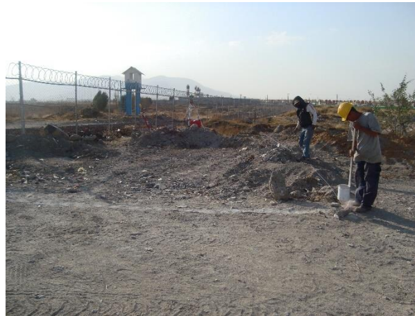
Foto II. 5 Ejemplo de trazo y marcación de poligonal con cal.
