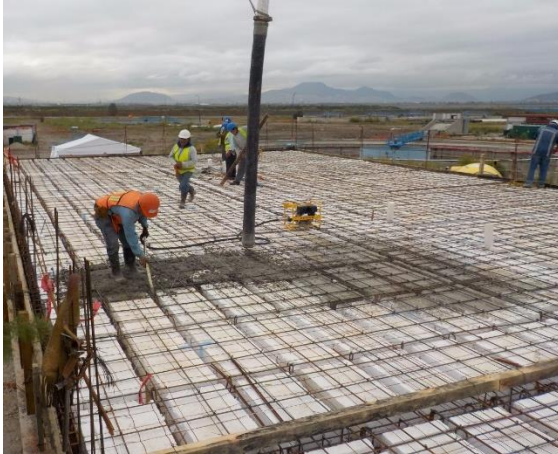
Foto II. 40 Ejemplo de suministro tendido y vibrado de concreto. FUENTE: PROPIA.
