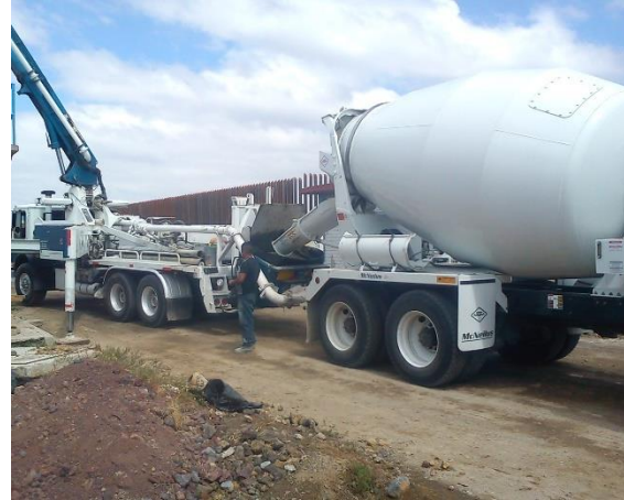
Foto II. 41 Ejemplo de suministro y bombeo de concreto. FUENTE: PROPIA.
