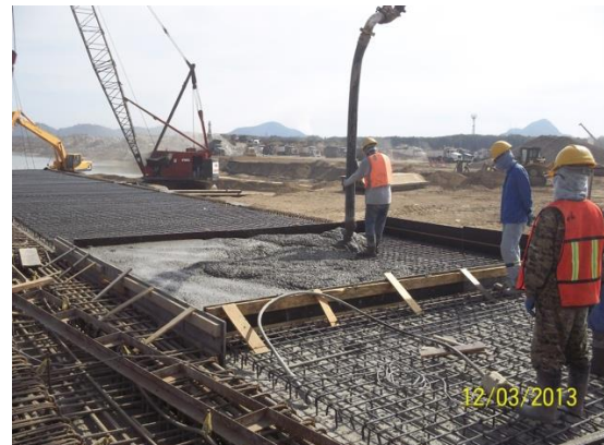
Foto II. 32 Ejemplo de suministro tendido y vibrado de concreto.
