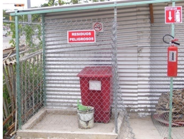
Figura VI. 7. Ejemplo de un Almacén de acopio temporal de residuos peligrosos, en donde se indica el tipo de material resguardado en el área y extintor señalado adecuadamente.
