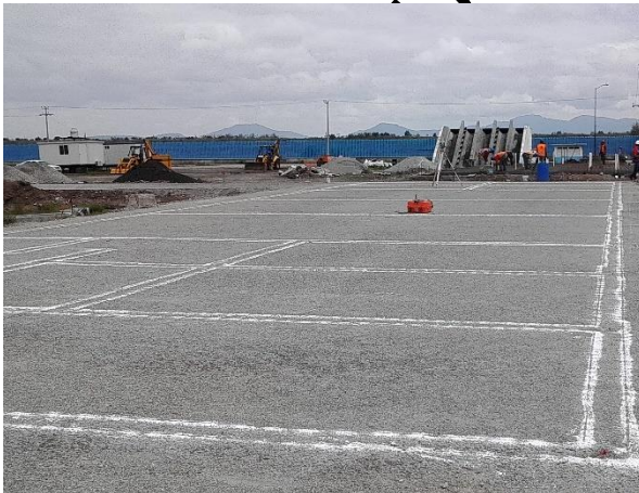
Foto II. 4 Ejemplo de trazo y marcación de poligonal con cal.
