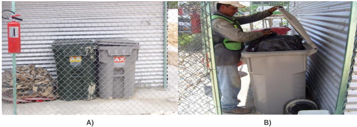
Figura VI. 5 Ejemplo de la buena disposición de los residuos sólidos. A) Contenedores adecuados para el confinamiento temporal de los residuos sólidos urbanos generados; B) Buenas prácticas por parte de los trabajadores de la obra.
