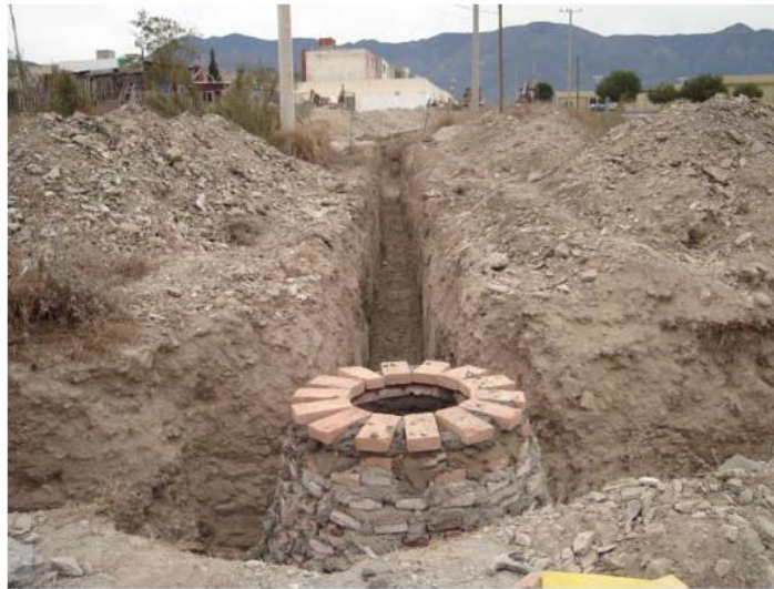
FIGURA II-11 EJEMPLO DE UN POZO DE VISITA.
