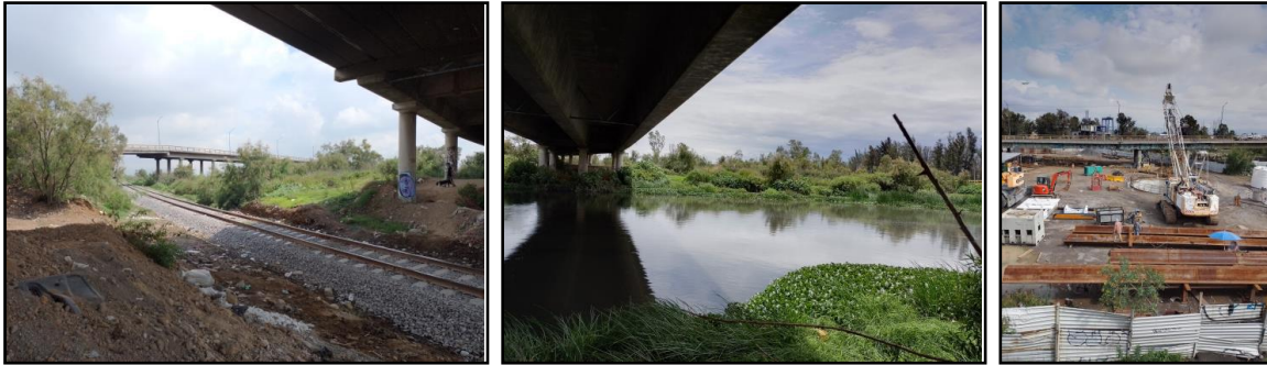
Figura II-14. Características actuales de puente vehicular.
