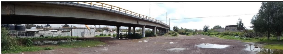
Figura II-13. Puente vehicular actualmente.
