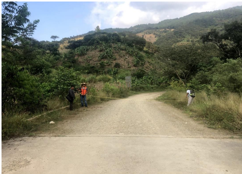
Medición del ancho del camino a modernizar
