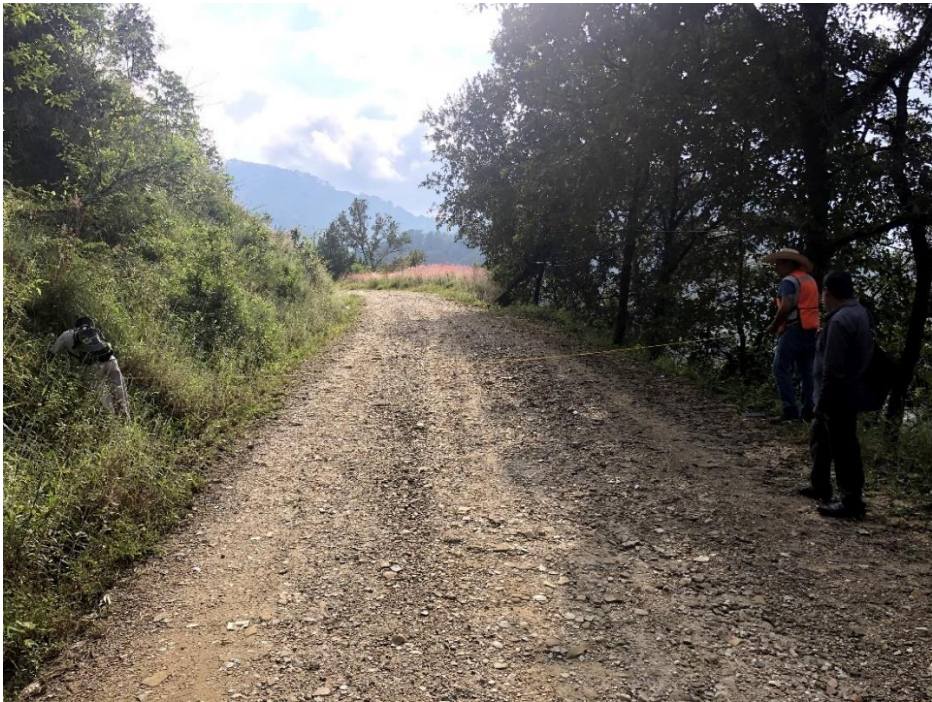
Toma de datos del ancho del camino a modernizar
