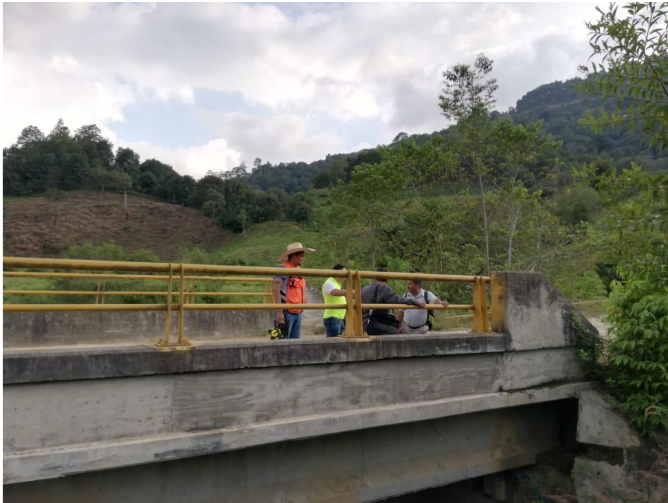
Puente existente y en funcionamiento dentro del camino a modernizar
