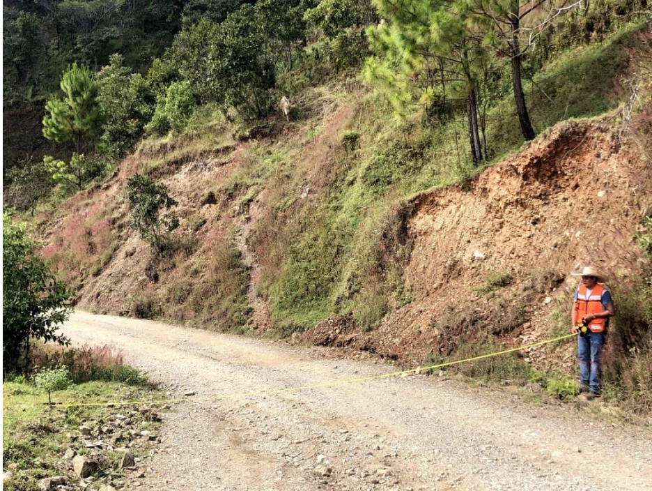
Medición de los anchos del camino a modernizar
