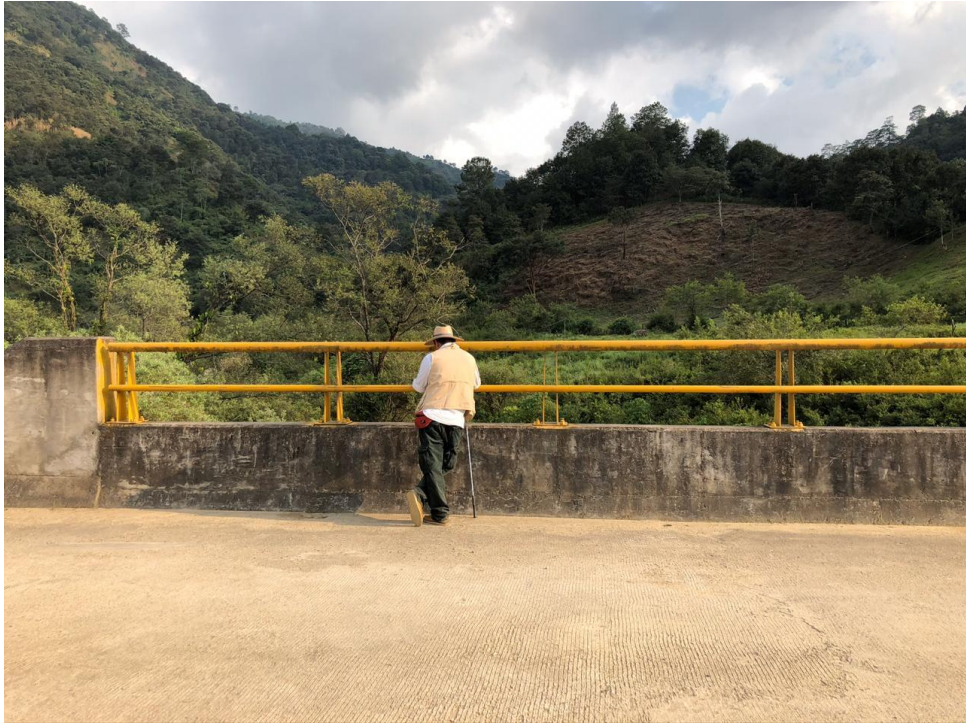
Puente existente dentro del tramo a modernizarse
