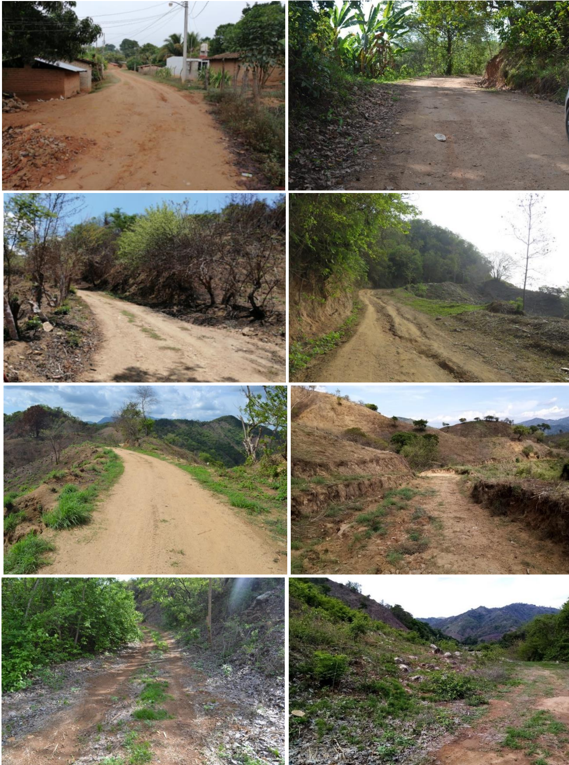
Figura II.1. Vista general del camino actual a modernizar
