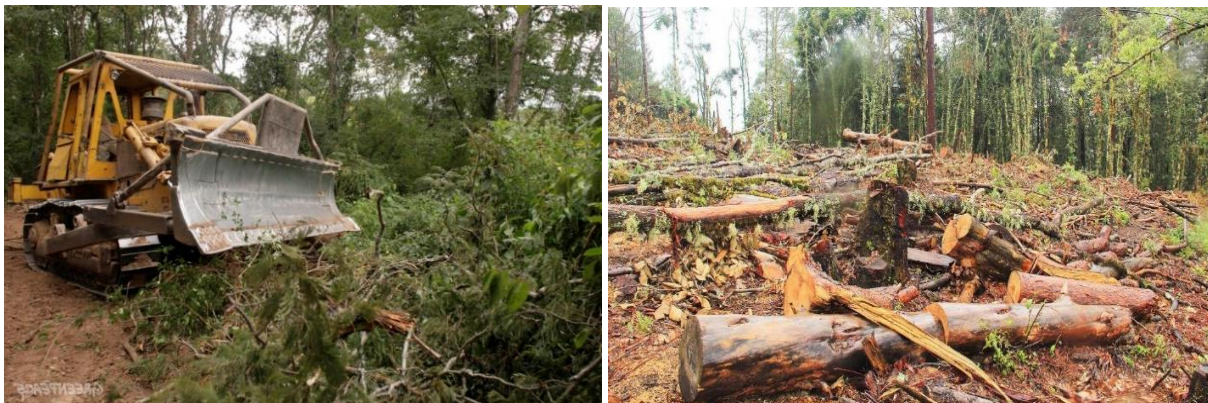
Figura 11.10. Desmante con maquinaria pesada en el área de ceros.
