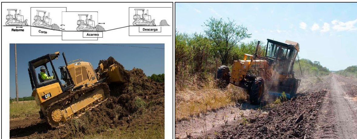
Figura II.12. Despalme de suelo con maquinaria pesada.
