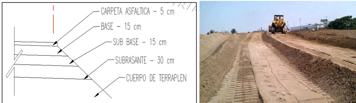
Figura 0-10. Ejemplo de construcción de terracerías
