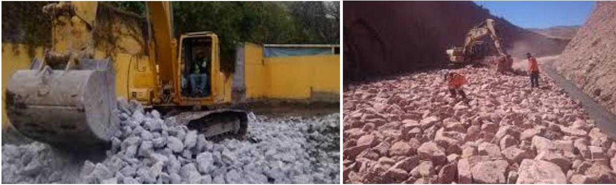
Figura 0-11. Ejemplo de construcción de pedraplén en el trazo del Proyecto.
