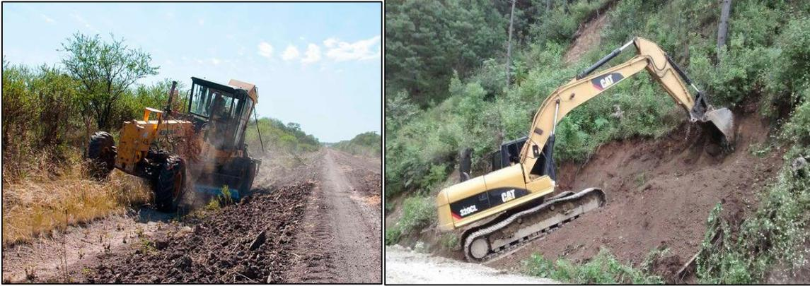
Figura 0-8. Despalme de suelo con maquinaria pesada.
