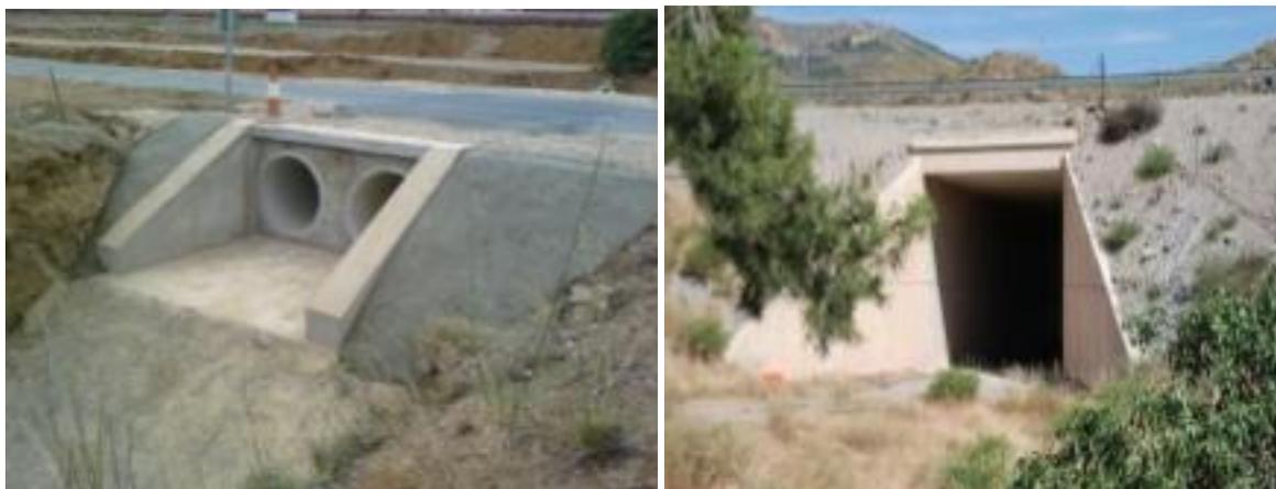
Figura 0-12. Diseño de obras de losas y tubos de concreto a instalar en el proyecto.
