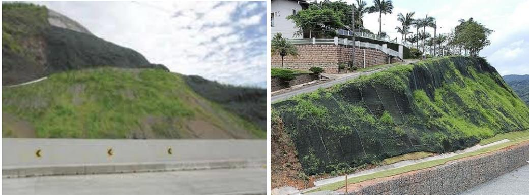
Figura 0-14. Ejemplo de cobertura vegetal o artificial para estabilización y reducir problemas de erosión.
