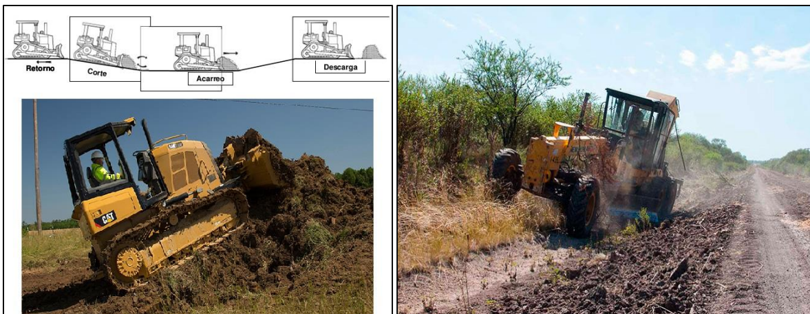
Figura 0-13. Despalme de suelo con maquinaria pesada.
