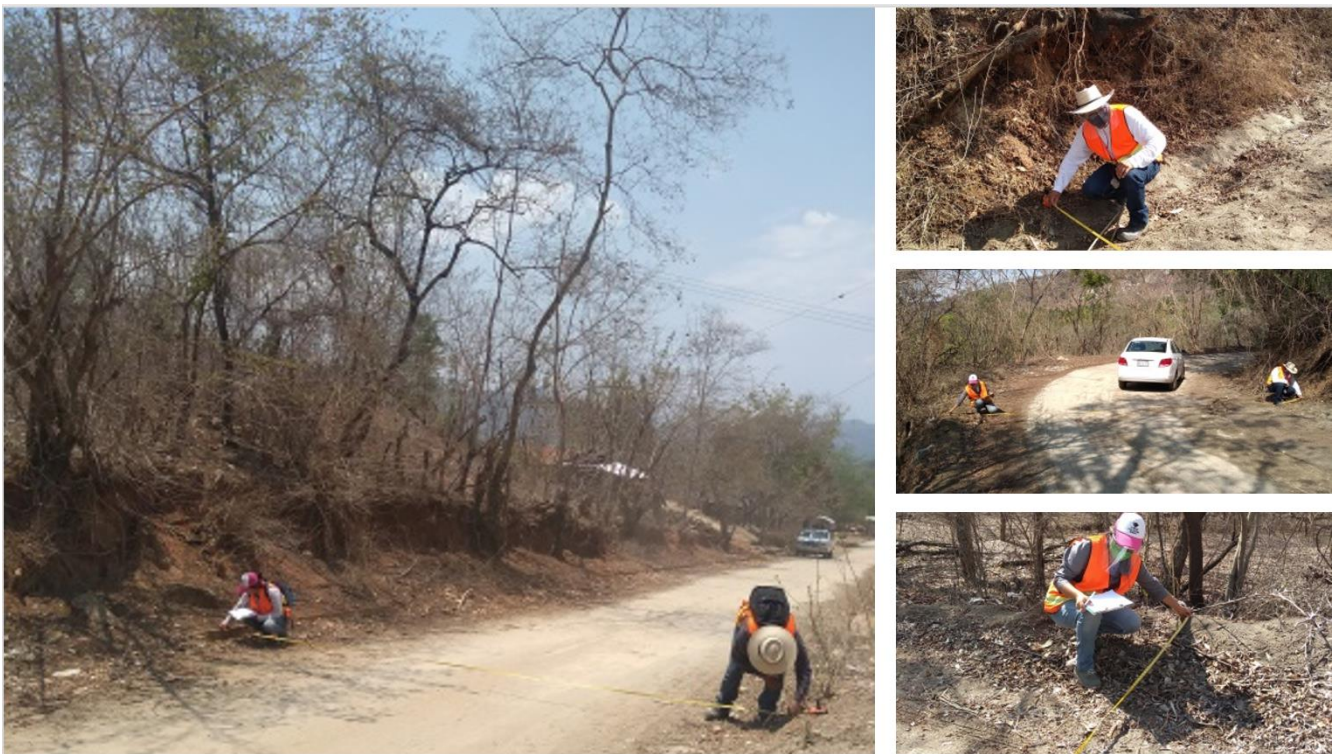
Figura IV- 29. Medición del ancho del camino.
