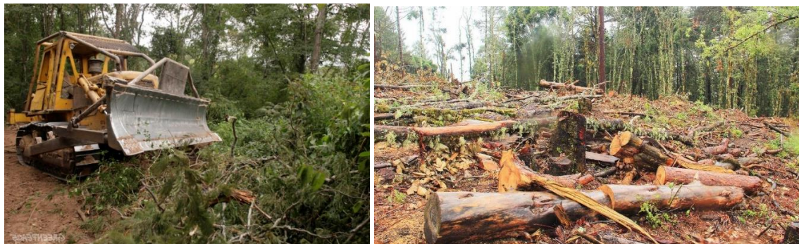
Figura 0-11. Desmante con maquinaria pesada en el área de ceros.
