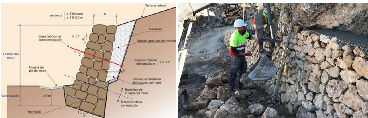
Figura 0-26. Construcción de muros de mampostería en talud
