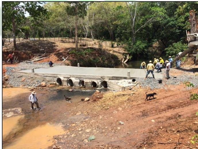
Ilustración 10. Ejemplo de la construcción de vado con concreto ciclópeo
