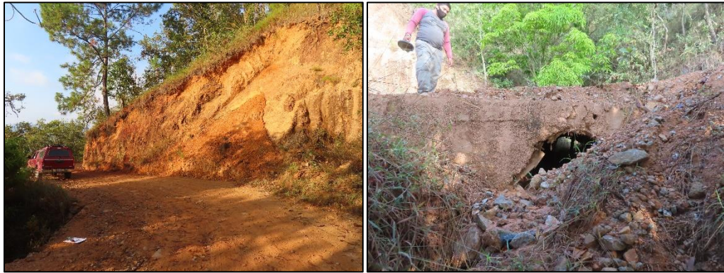
Obra de drenaje 6.
