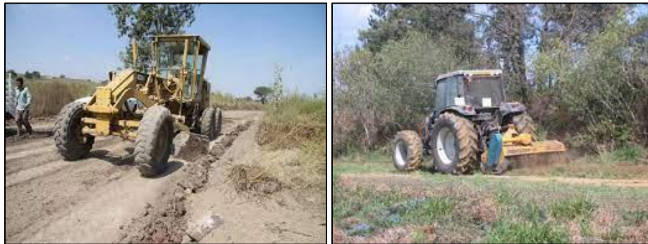
Figura V.1 Ejemplos de la desmonte y despalme del sitio del proyecto.
