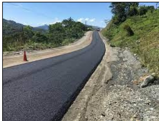
Figura V.15 Pavimentación del camino.
