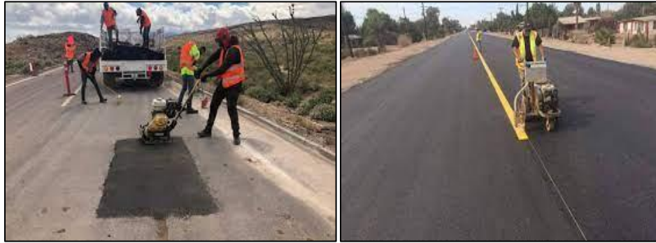
Figura V.3 Actividades de mantenimiento correctivo.
