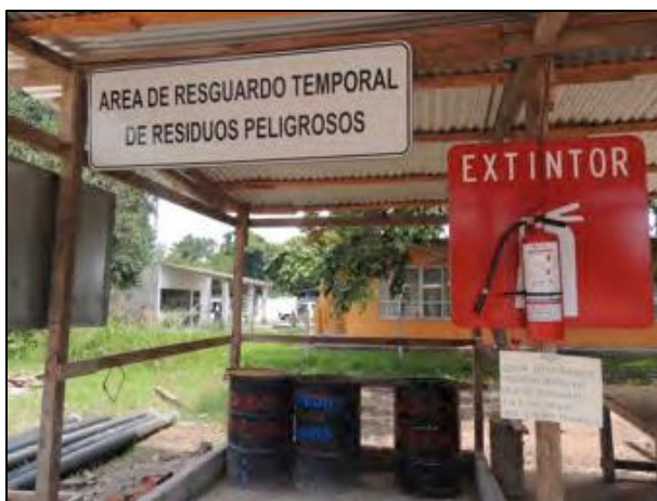
Figura VI.31 Ejemplo de un sitio de resguardo de material peligroso en obras similares.
