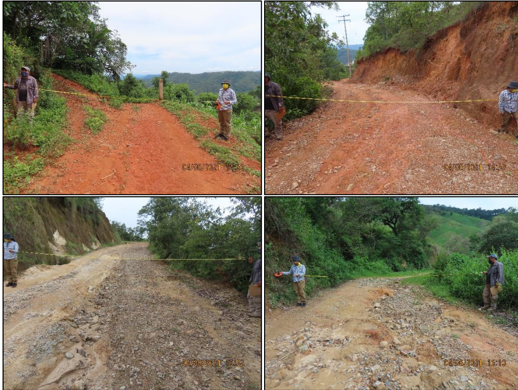
Figura VII.5 Vista de las condiciones del camino que pretende ser modernizado.
