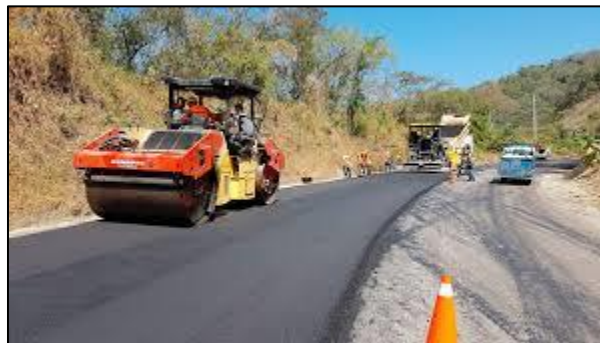
Figura V.10 Ejemplo de una carretera tipo D con la calzada pavimentada.
