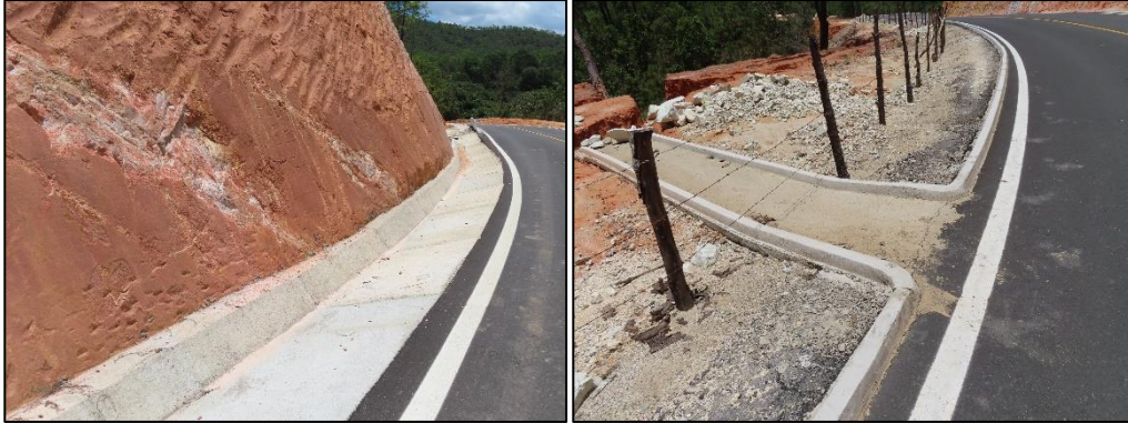
Figura V.9 Ejemplo de construcción de obras de drenaje menor (cunetas y lavaderos).
