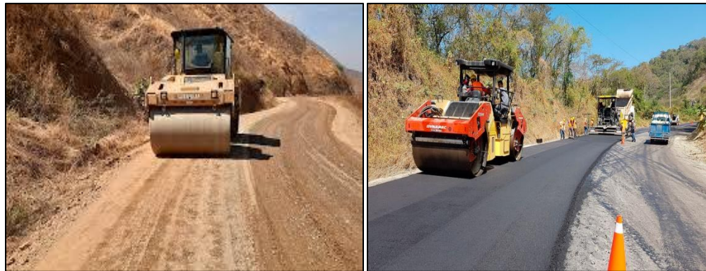
Figura II.44 Ejemplo de la construcción de un camino tipo D.
