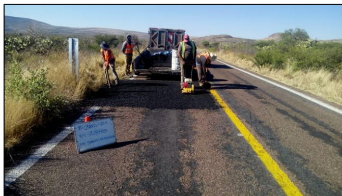
Figura II.45 Actividades de mantenimiento de una carretera similar.
