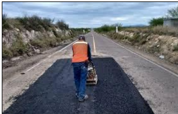
Figura V.16 Mantenimiento preventivo y correctivo del cuerpo carretero.
