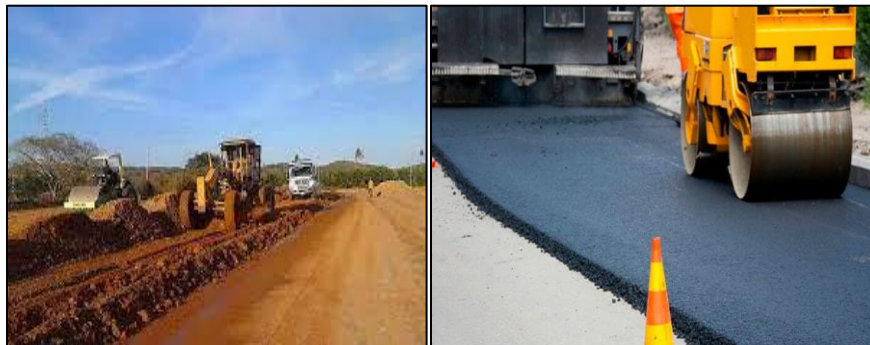
Figura V.2 Terminado de terracerías y pavimentación de un camino similar.
