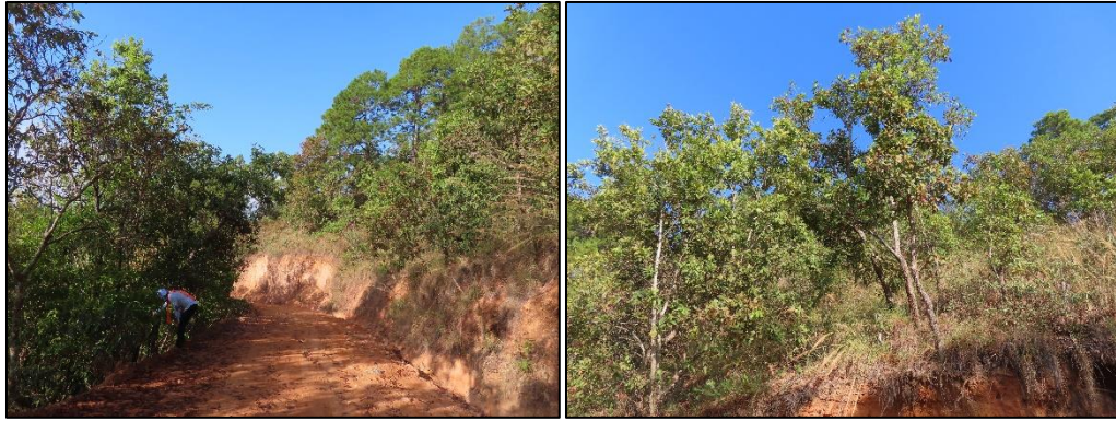
Obra de drenaje 5.
