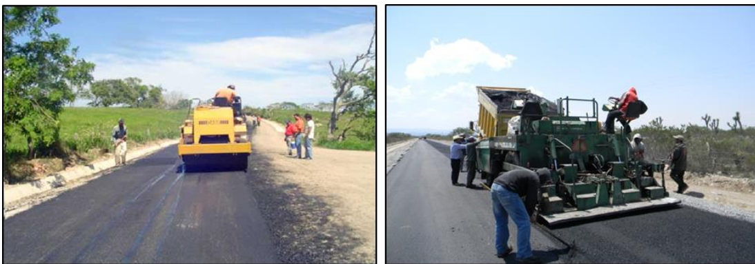
Figura II.36 Ejemplo del encarpado asfáltico de un proyecto similar.
