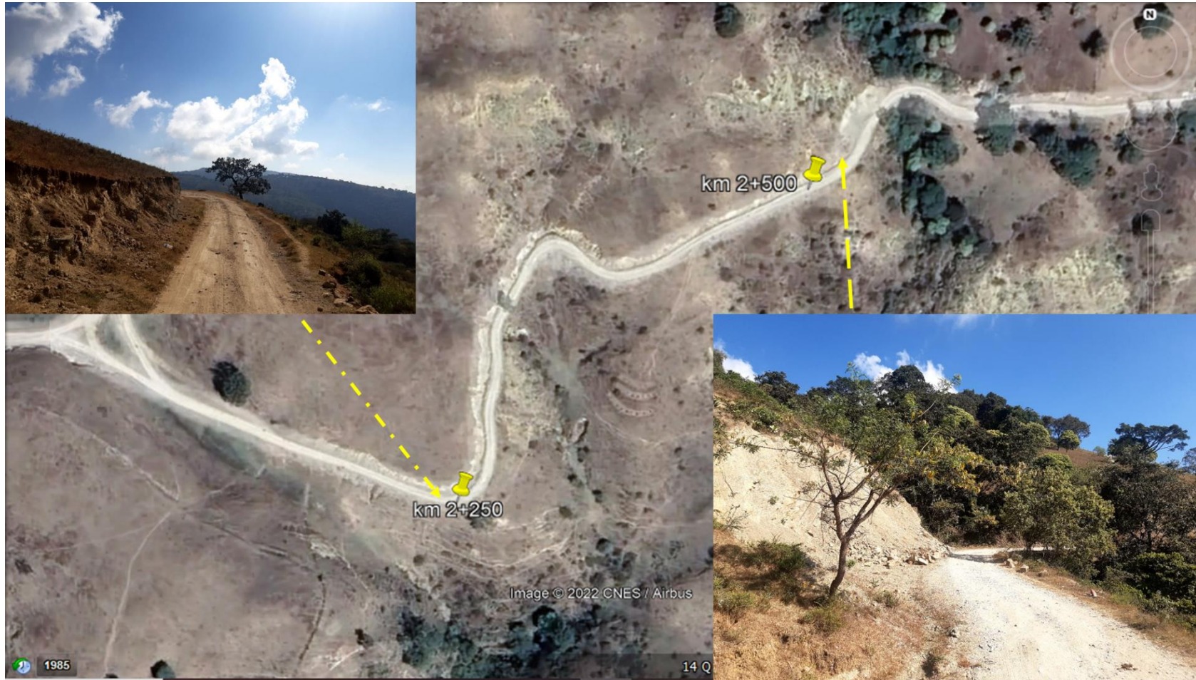
Ilustración 80.-- Imagen satelital del tramo km 2+250 al km 2+500, donde el uso de suelo es agricultura de temporal anual con un ancho camino de 5.9 a 6.7 metros con especies aisladas de vegetación secundaria de bosque de encino y selva baja caducifolia en los costados del camino.
