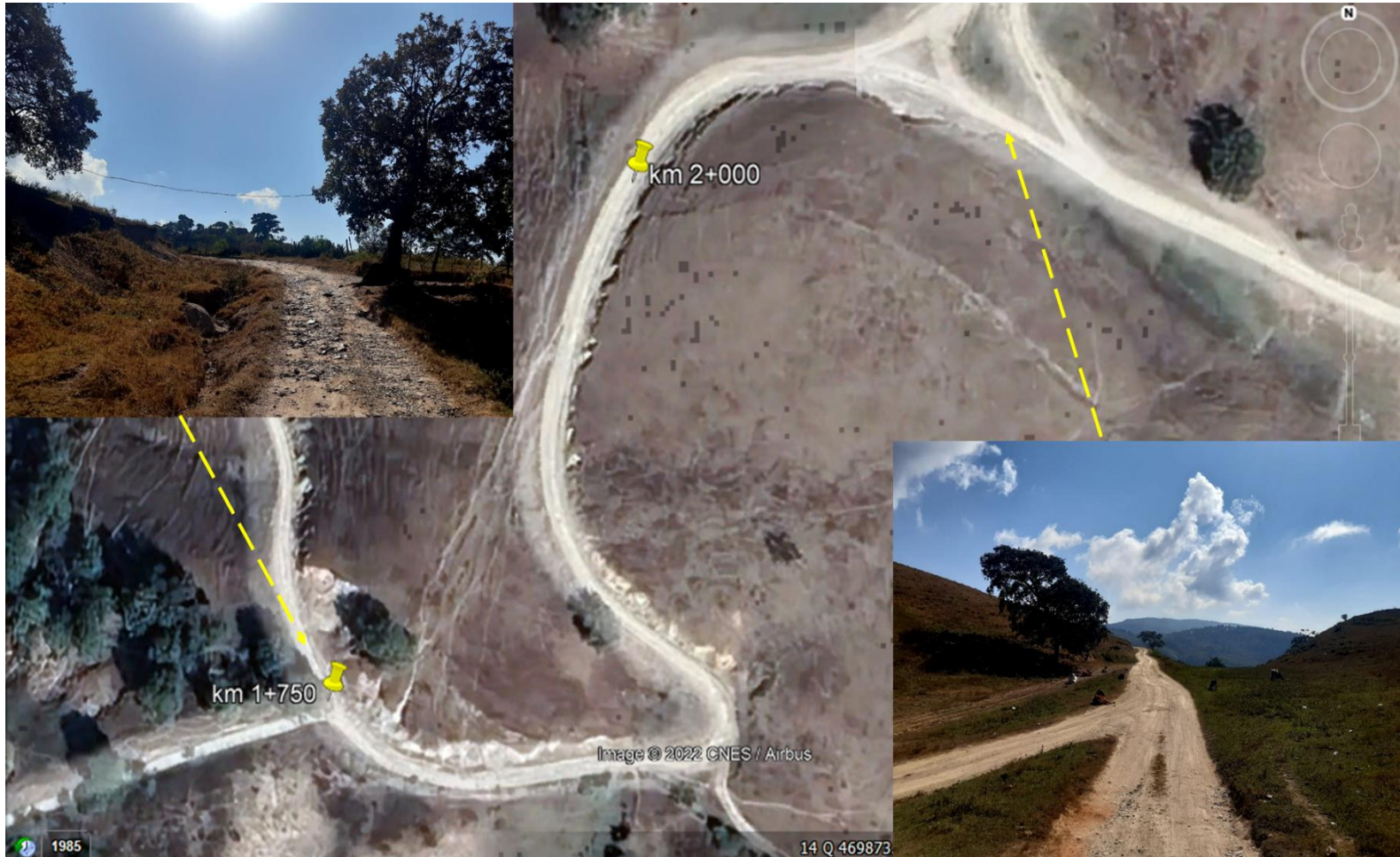
Ilustración 79.- Imagen satelital del tramo km 1+750 al km 2+000, donde el uso de suelo es agricultura de temporal anual con un ancho camino de 6.5 a 7.2 metros con especies secundarias en los costados del camino.
