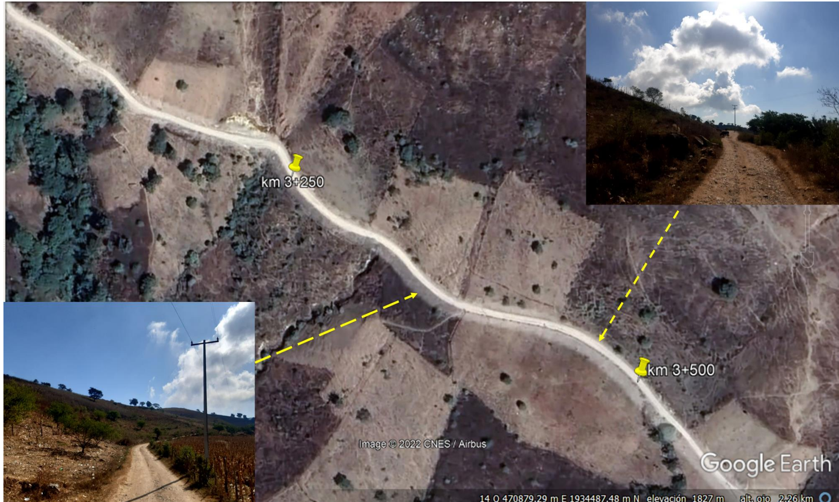
Ilustración 82.- Imagen satelital del tramo km 3+250 al km 3+500, donde el uso de suelo es agricultura de temporal anual con un ancho camino de 5.0 a 6.6 metros con especies de bosque de encino y selva baja caducifolia en los costados del camino.
