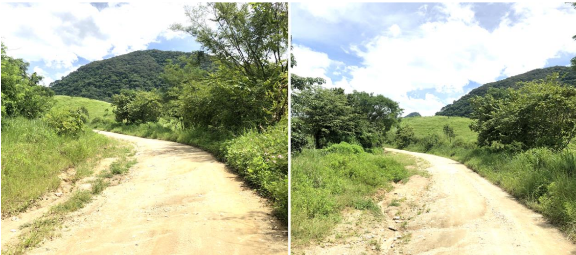
Ilustración 53. Inicio del tramo a modernizar (Km. 34+000) camino Tépán - El Balcón
