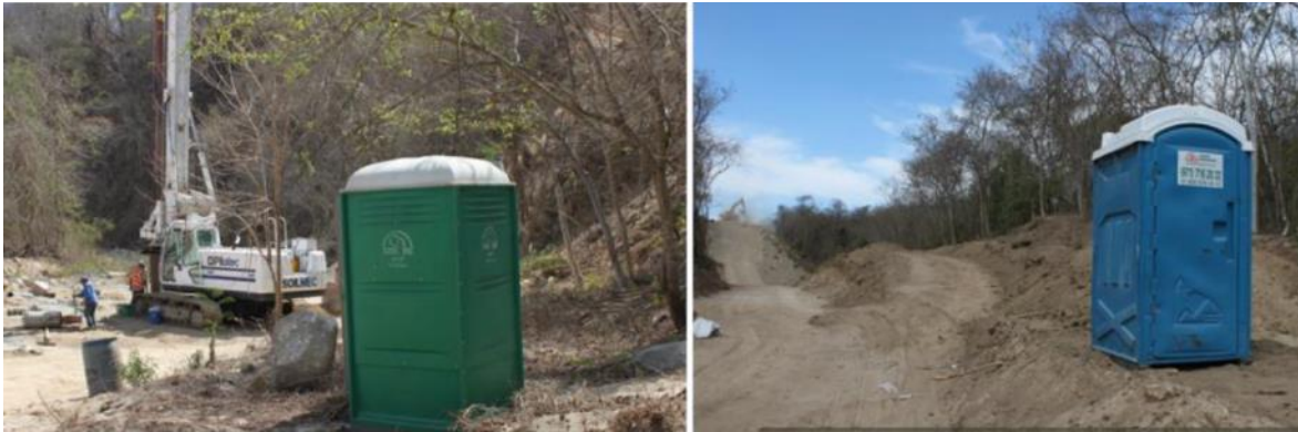
Figura 5. Ejemplo de la utilización de sanitarios portátiles en la construcción de proyectos similares
