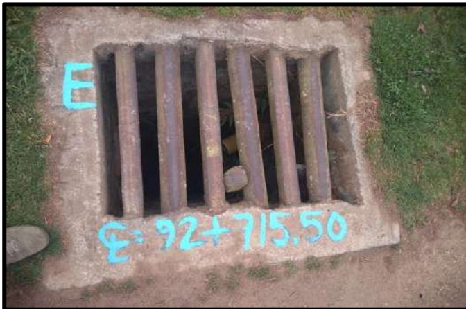
Figura IV.63 Afluente entrada (Km 92+715).
