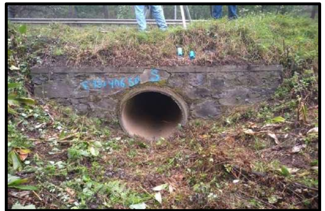
Figura IV.70 Afluente salida (Km 93+406.50).
