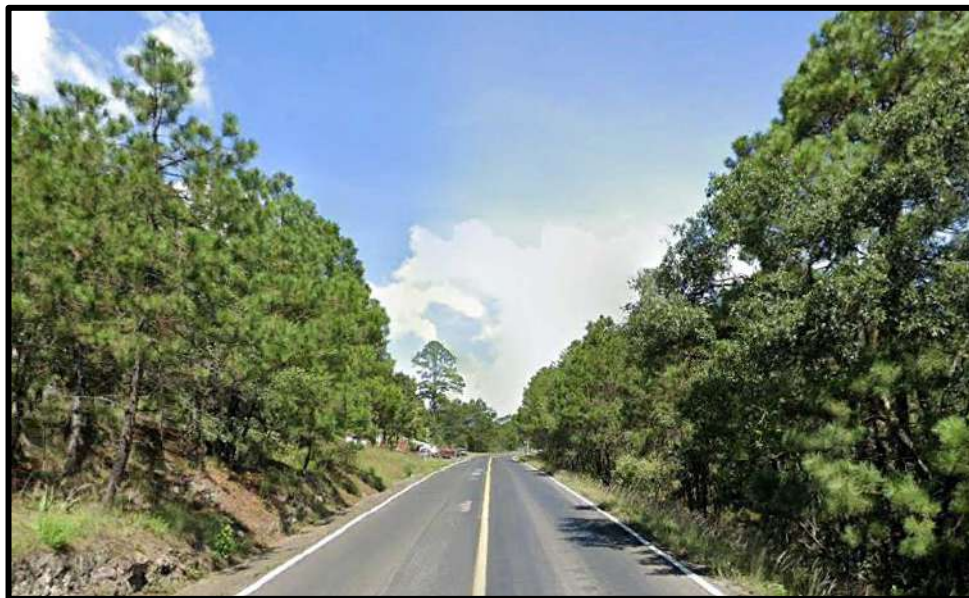
Figura IV.41 Aspecto general de los subtramos donde no se observa algún talud que pueda originar derrumbes o deslizamiento de rocas (Km 80+650)
