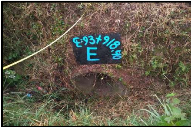
Figura IV.73 Afluente entrada (Km 93+918.40).
