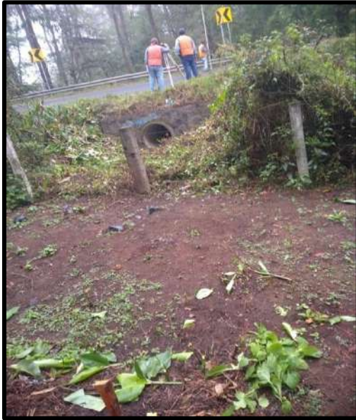
Figura IV.71 Afluente entrada (Km 93+406.50).
