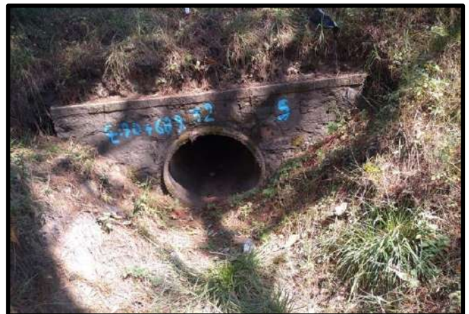
Figura IV.56 Afluente salida (Km 90+689.32).
