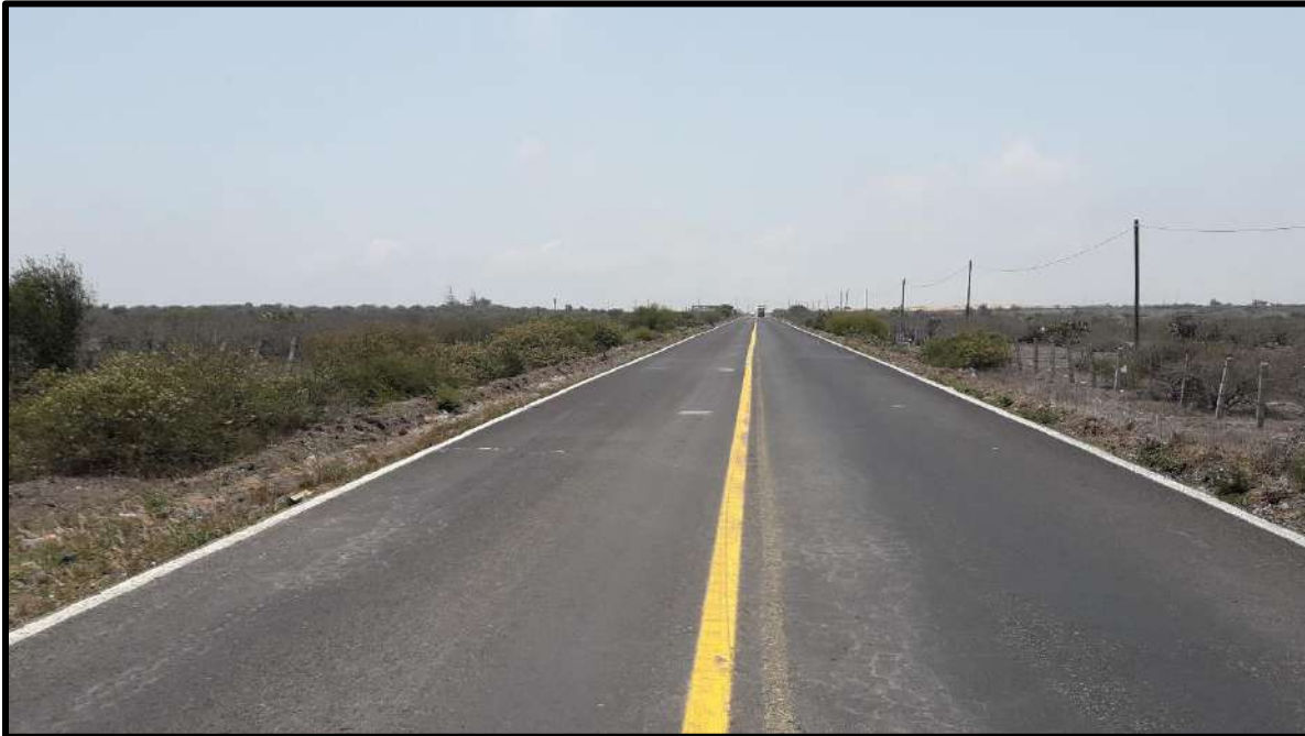
Figura IV.140 Aspecto de la vegetación secundaria arbustiva de matorral crasicaule y del pastizal inducido en el Km 85+100, donde se observan especies de acacias, opuntias y agaves.
