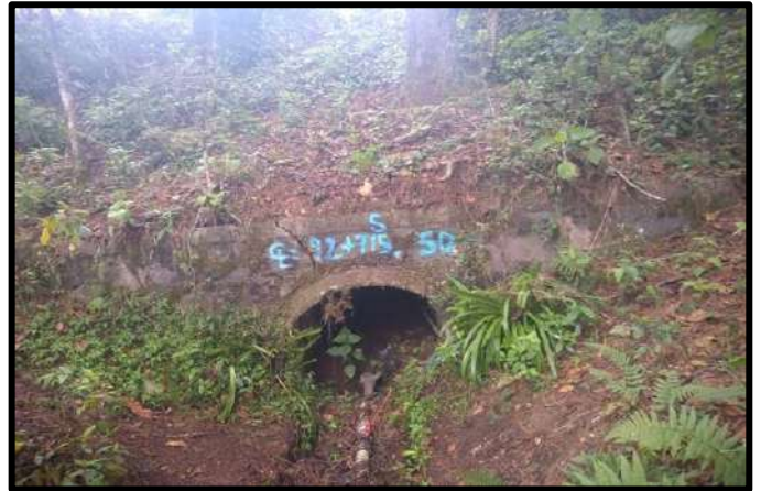
Figura IV.64 Afluente salida (Km 92+715)
