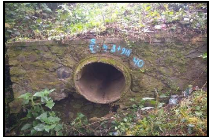
Figura IV.74 Afluente salida (Km 93+918.40).
