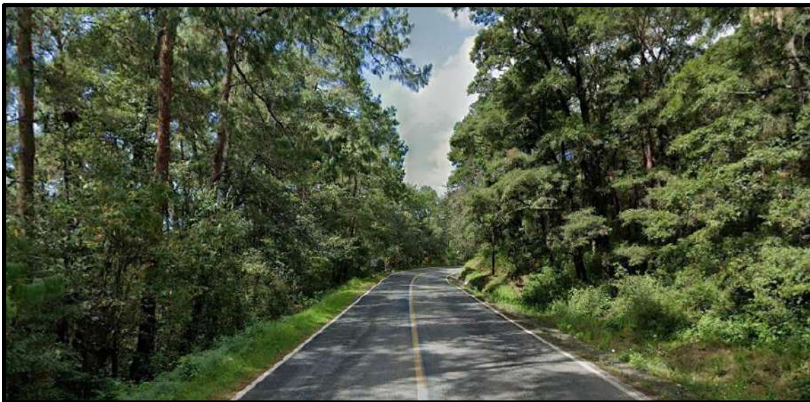
Figura IV.155 Tramo carretero Km 100+020, donde se observa la vegetación secundaria arbustiva de bosque mesófilo de montaña. El área de afectación corresponde al pastizal y pequeños arbustos situados a 2.5 m de la carretera. Se reconocen especies como Alnus acuminata , Pinus patula , Liquidambar styraciflua y varias especies de Quercus .
