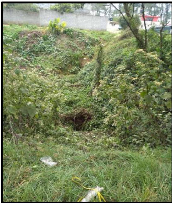
Figura IV.76 Afluente entrada (Km 94+868.40).
