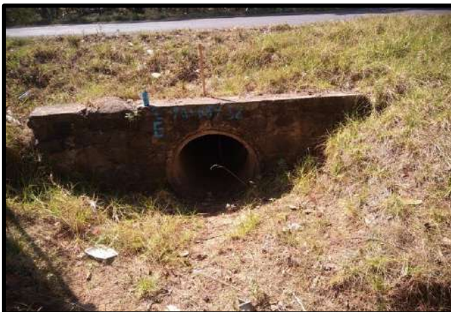
Figura IV.55 Afluente entrada (Km 90+689.32).
