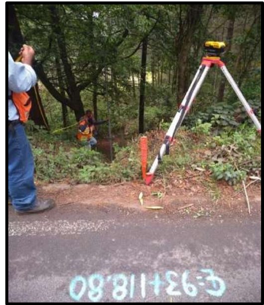
Figura IV.66 Afluente aguas abajo (Km 93+118.80)
