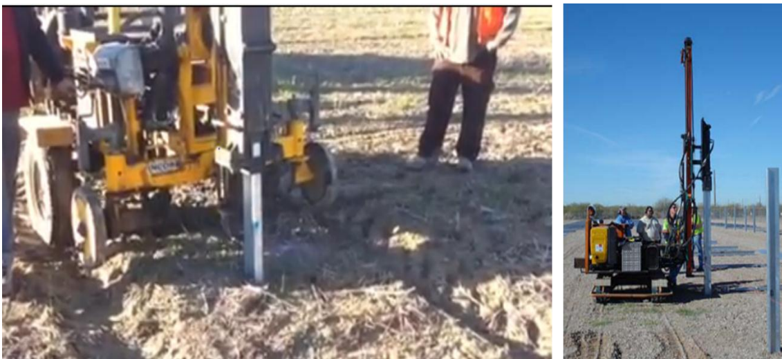
FIGURA FIJADO DE POSTES
