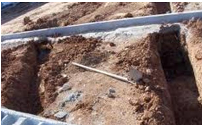
FIGURA II. 7 EXCAVACIÓN DE ZANJAS TIPO PARA LA TUBERIA DE CONEXIÓN
