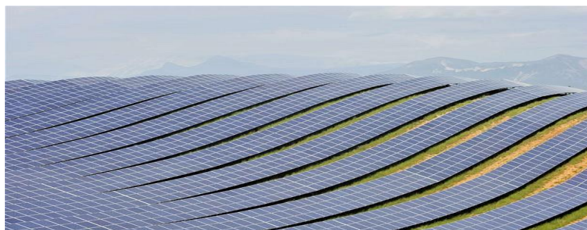
FIGURA: PANELES SOLARES EN LES MEES, FRANCIA, MAYO 2011
