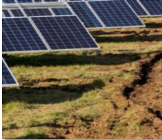
Imagen: Medidas de mitigación aplicadas en la Etapa II (pasto inducido entre los paneles y escurrimientos naturales)
