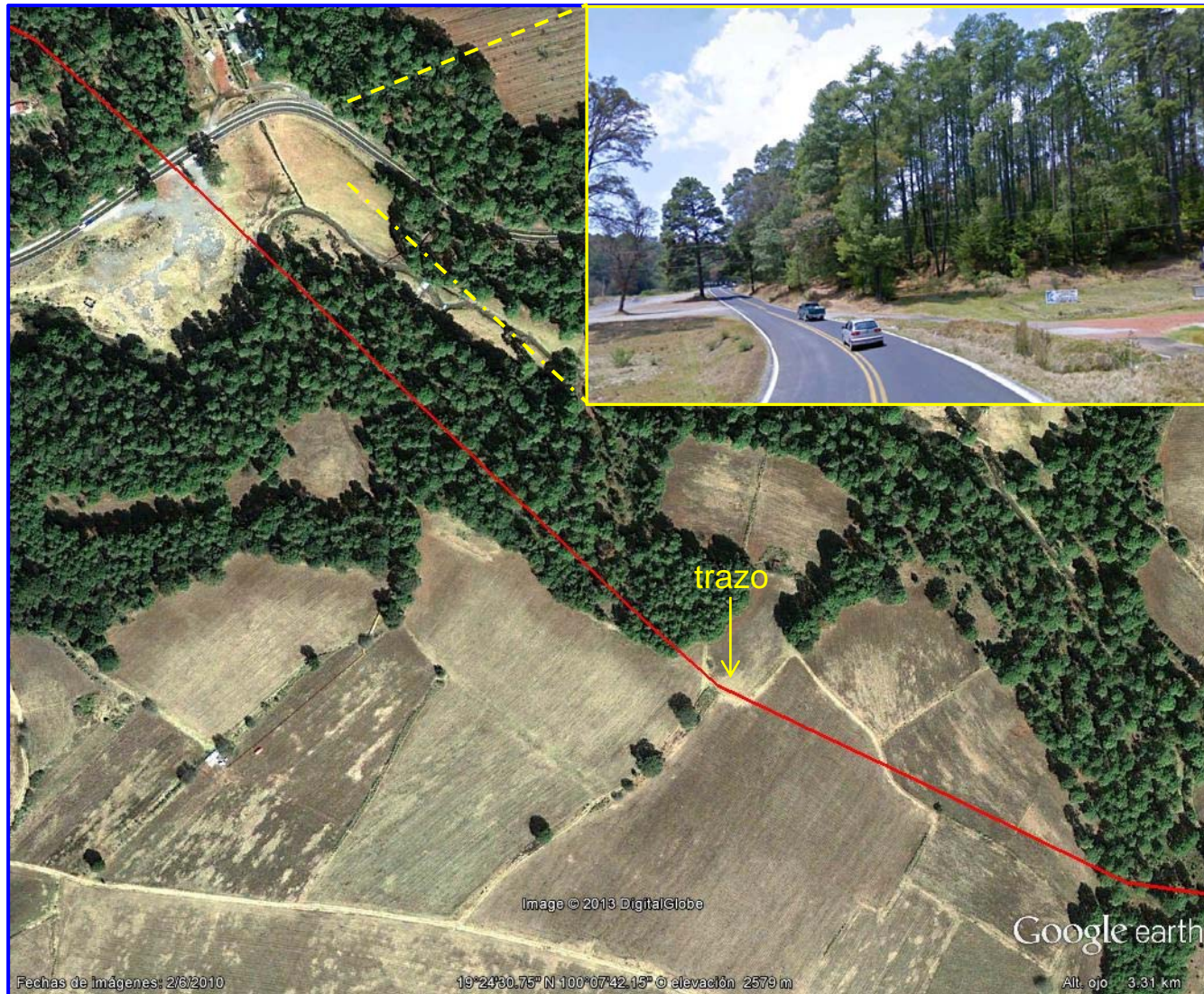
FIGURA IV.2.8.9. ENTRE EL KM 45+989 AL 47+044 SE APRECIA QUE EL TRAMO CRUZA POR UNA ÁREA DE CULTIVO Y CRUZA EN 500 M APROXIMADAMENTE UN MANCHÓN DE VEGETACIÓN
