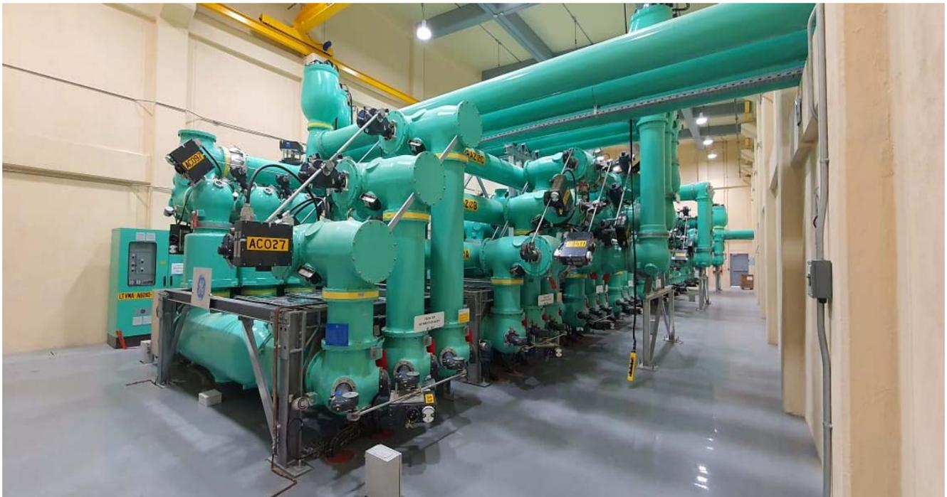
**Imagen VIII.7.** S.E. VMA- Subestación GIS de 400 kV.
