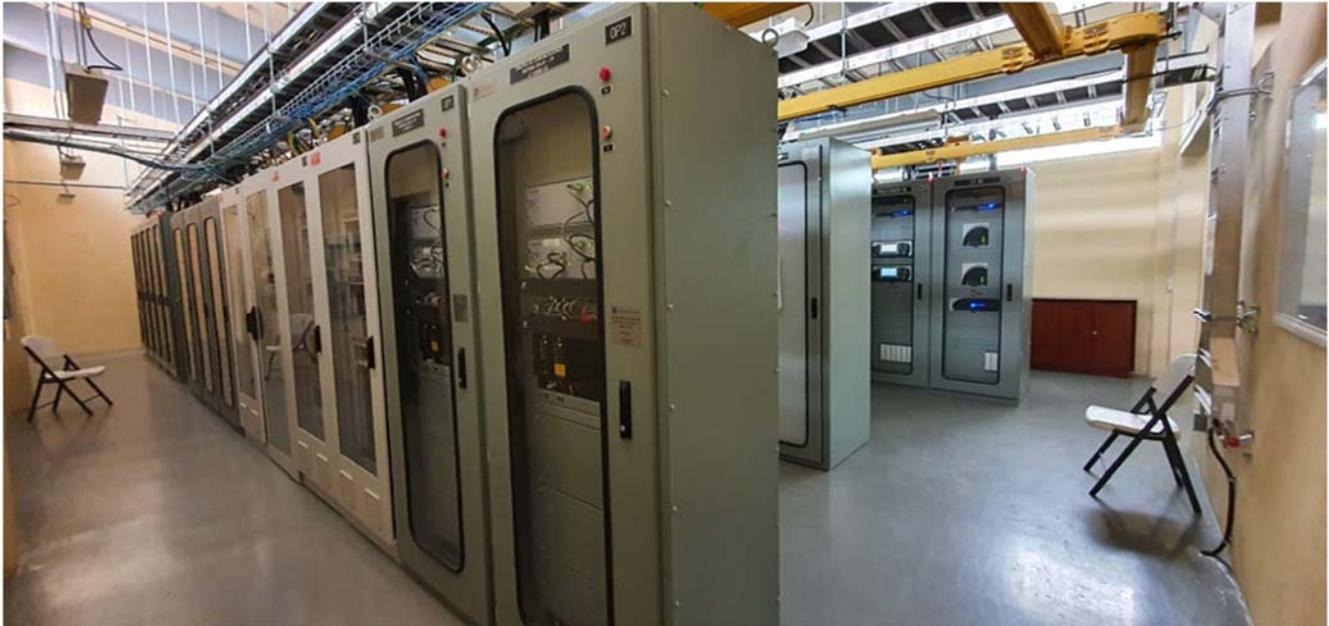
**Imagen VIII.8.** Caseta Principal de Control de S.E. VMA para 230 y 400 kV.
