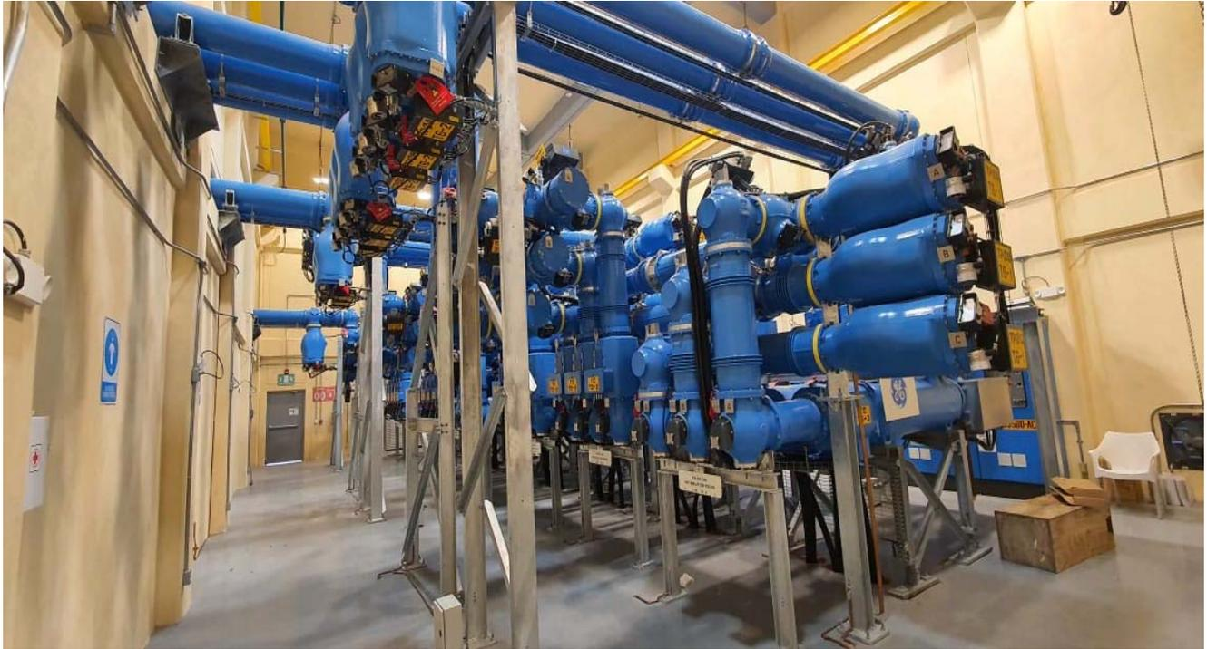
**Imagen VIII.6.** S.E. VMA- Subestación GIS de 230 kV.
