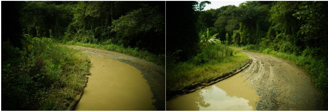
Figura 52. Vista lateral del camino y el cruce de la corriente de agua perenne (2+675.72 km). En ambos lados y direcciones del camino se presenta vegetación secundaria de selva baja caducifolia y encharcamiento temporal, causado por la temporada de lluvias.
