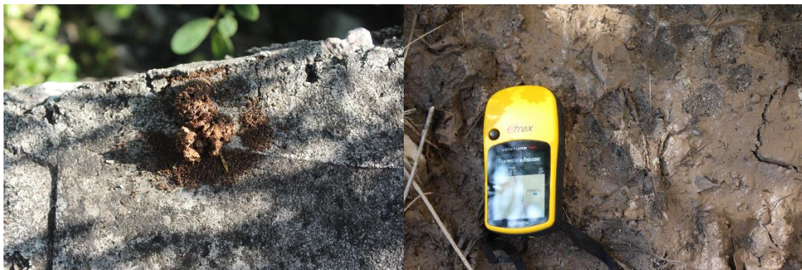
Figura 119. Evidencia de la presencia de fauna silvestre en las cercanías de algunas obras de drenaje.
