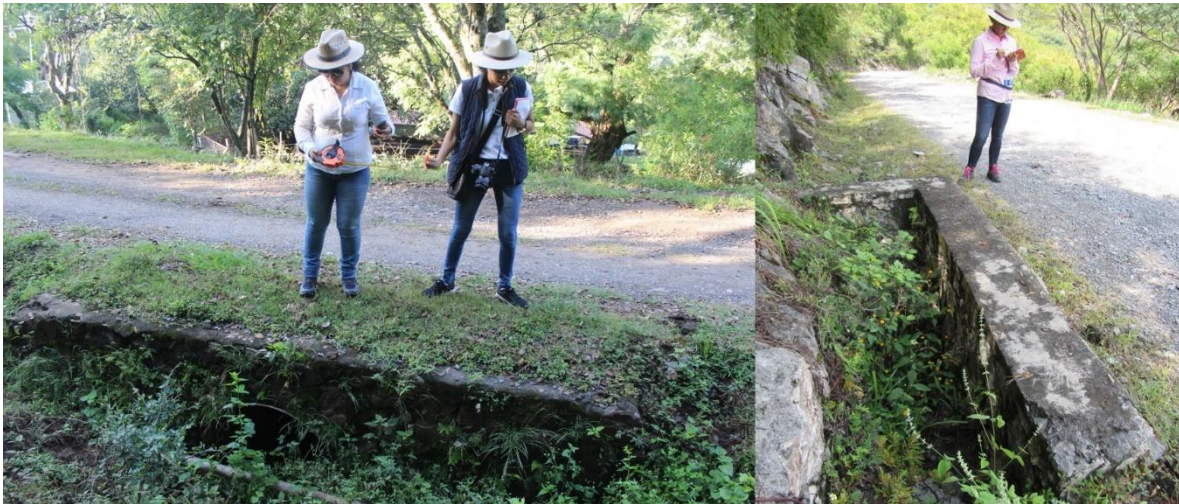
Figura 100. Revisión de obras de drenaje en búsqueda de registros indirectos.
