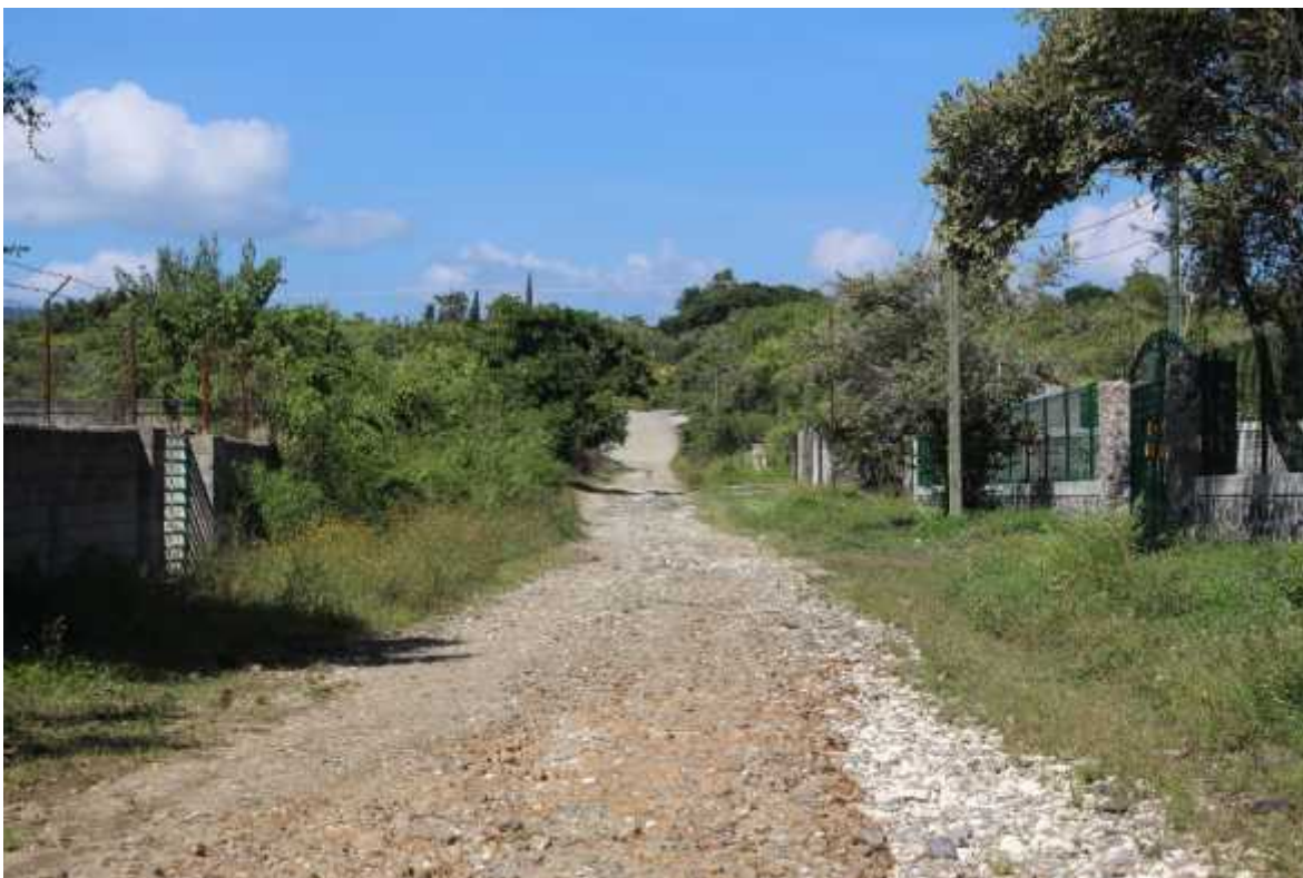
Figura 2. Vista actual del camino proyectado (Km 0+100).
