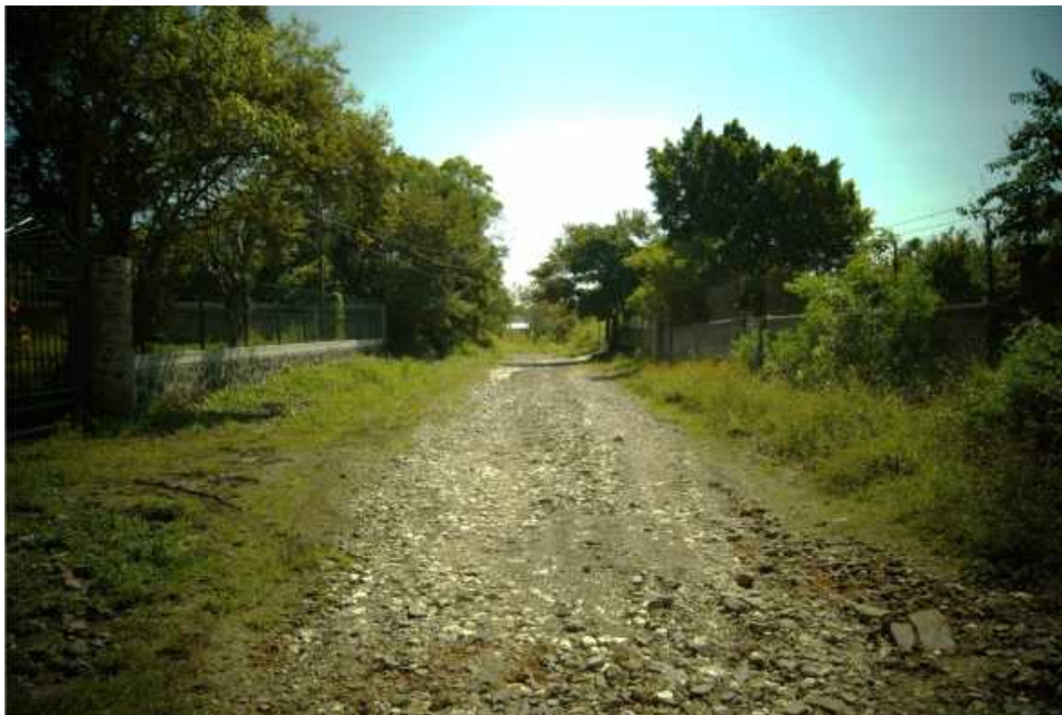
Figura 11. Vista inicio de proyecto km 0+000
