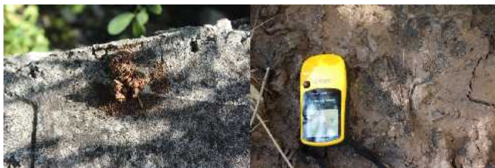
Figura 8. Evidencia de la presencia de fauna silvestre en las cercanías de algunas obras de drenaje.
