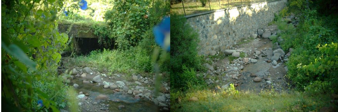
Figura 63. Obra de drenaje y corriente de agua intermitente km 6+200.83
