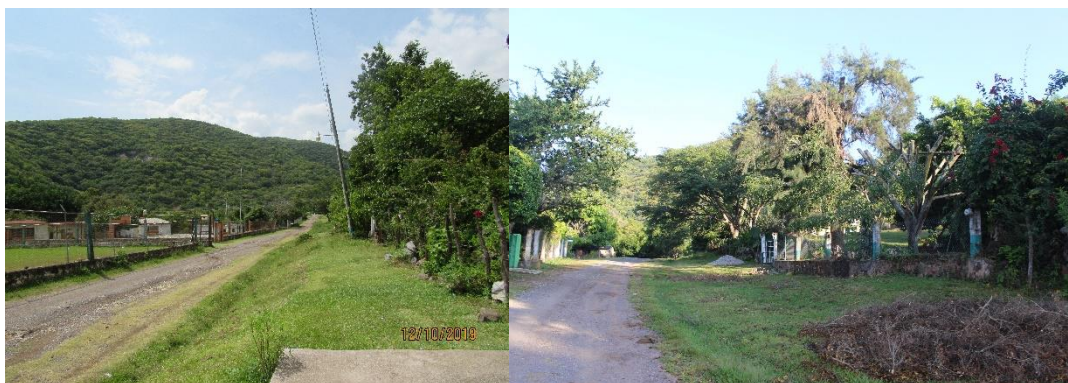
Figura 65. Vista del camino en el km 6+719.05. Lado izquierdo presenta una escuela y lado derecho casas.
