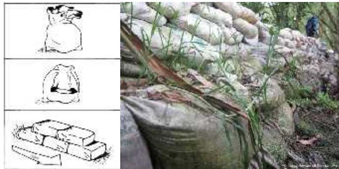
Figura 3. Ejemplo de la colocación de diques con sacos de tierra. Muralla de sacos de arena hechos en Bogotá Colombia para proteger el manglar.
