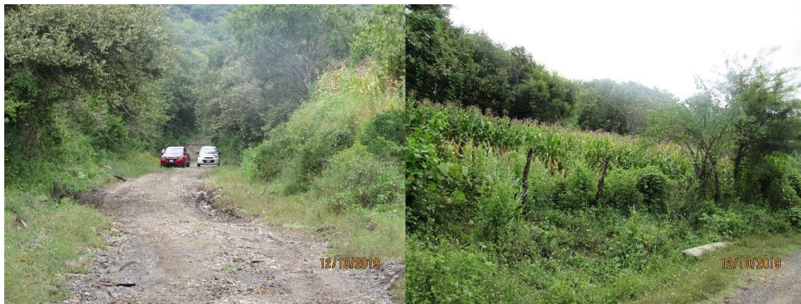
Figura 46. Vista del cruce de la corriente intermitente (lado izquierdo, obra de drenaje (2+318.14) colinando con zonas de cultivo de maíz.
