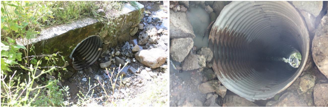
Figura 43. Obras de drenaje en el km 0+0874.35.
