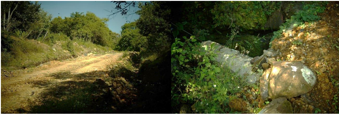
Figura 53. Obra de drenaje (km 3+405.02). Vegetación secundaria de selva baja caducifolia (lado izquierdo) y obra de drenaje (km 3+405.02 – lado derecho).
