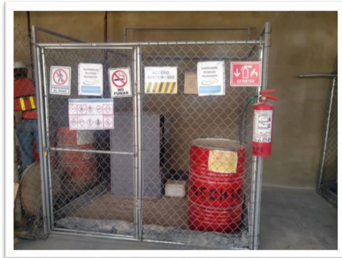
Figura VI. 5 Ejemplo de almacén de residuos peligrosos con medidas de seguridad
