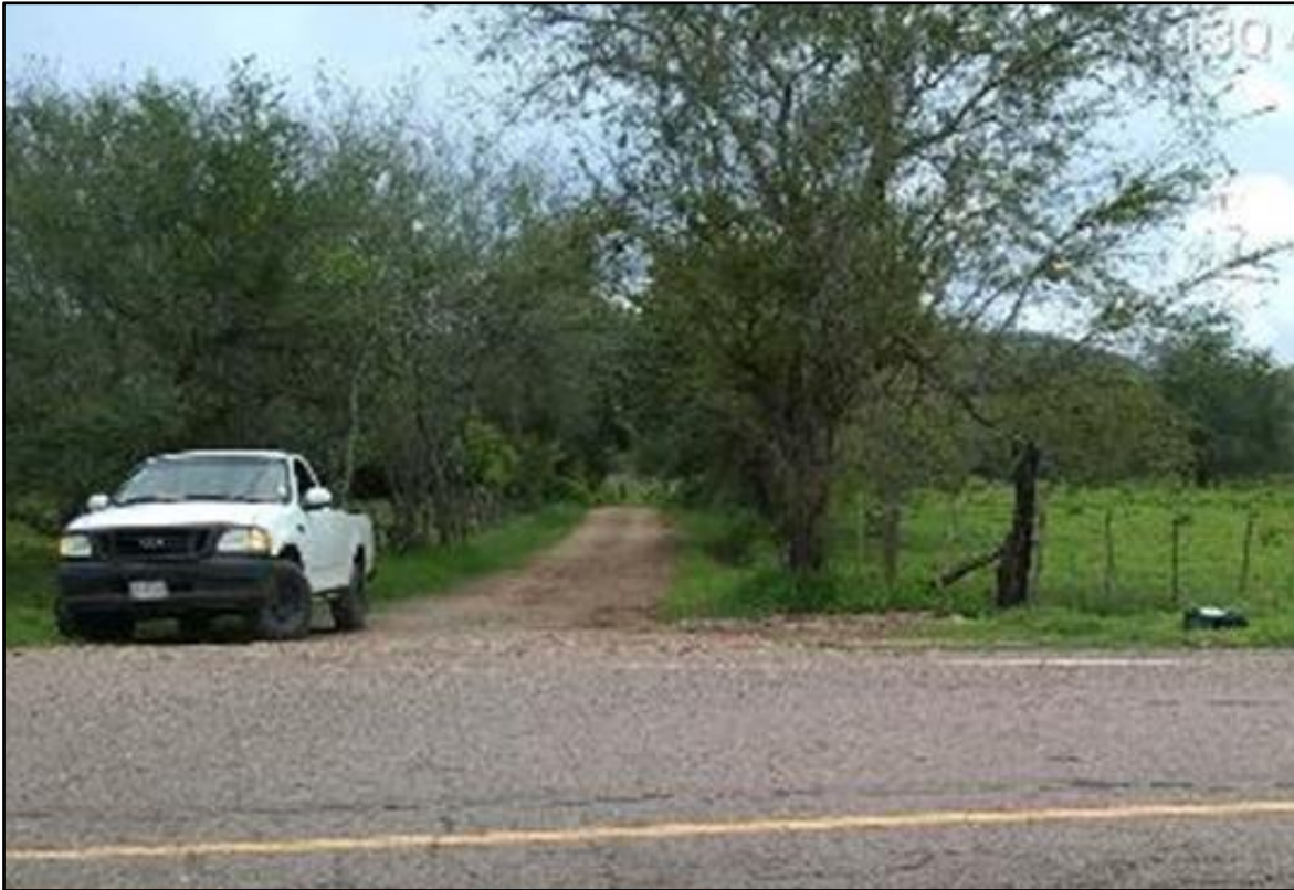
Cadenamiento Km.0+000 en la intersección del camino Agua Aceda-Santa Fe).
