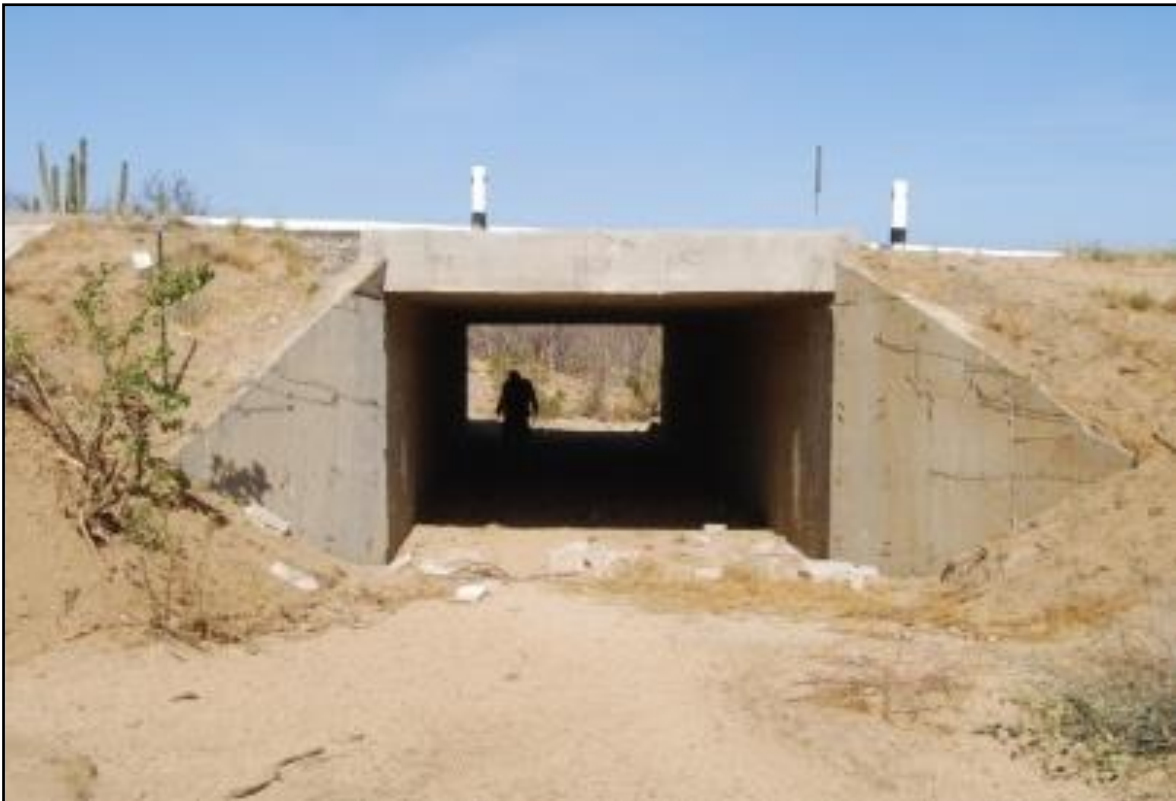
Imagen de Alcantarilla/Losa prototipo (3 x6 m).
