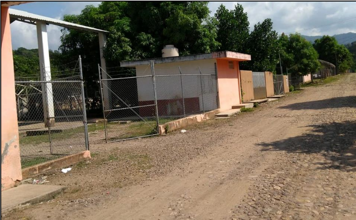
Figura No.11 Población de Mojocuatla, punto final del proyecto carretero.
