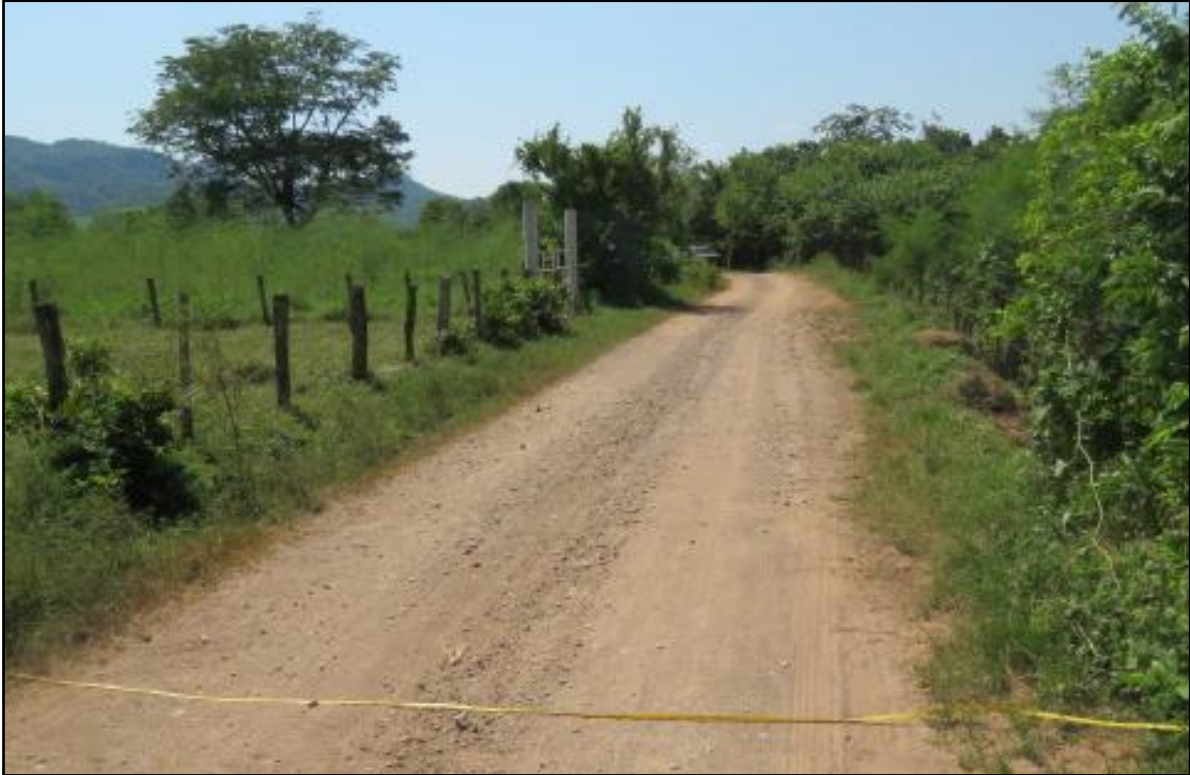
Figura No. 10 Camino actual el cual se pretende modernizar.
