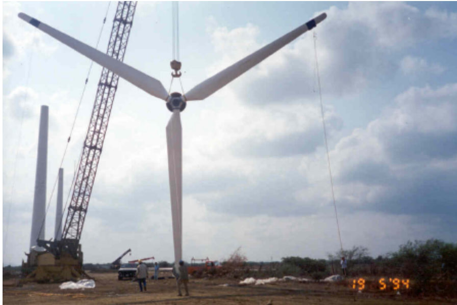
Montaje de los álabes de los aerogeneradores
