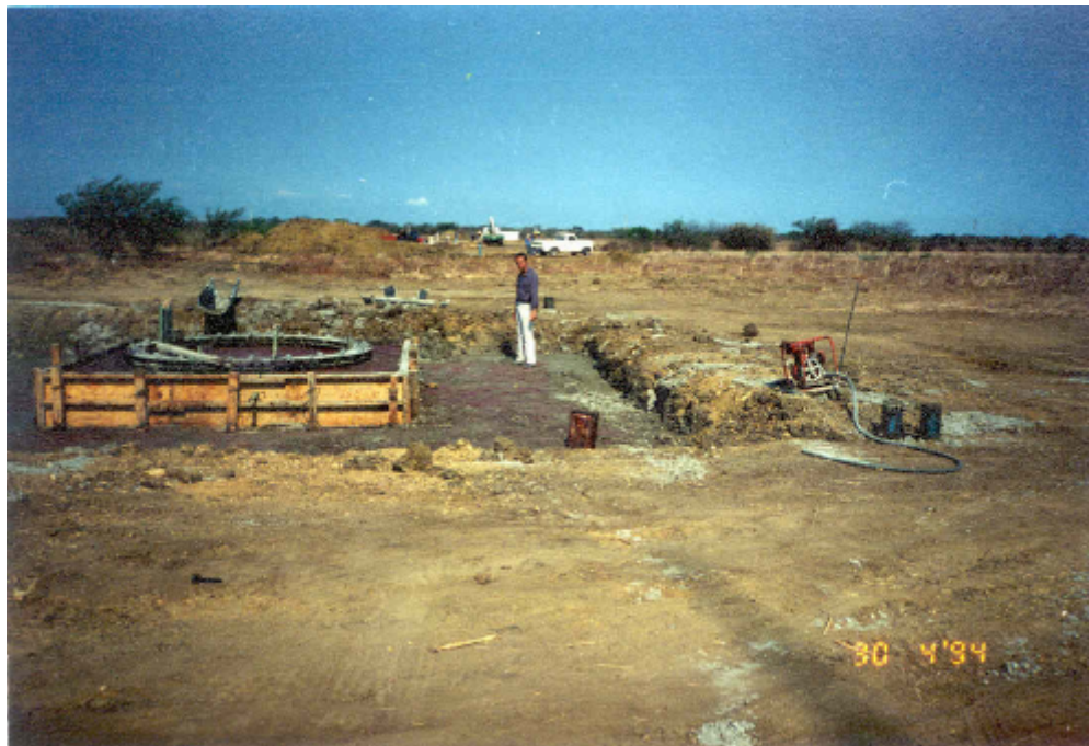
Construcción de la zapata, una vez colocado el concreto
