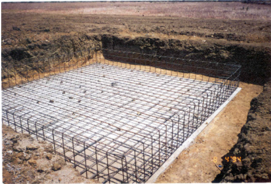
Armado de la zapata
