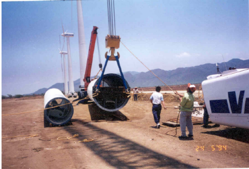
Montaje de las torres tubulares del aerogenerador
