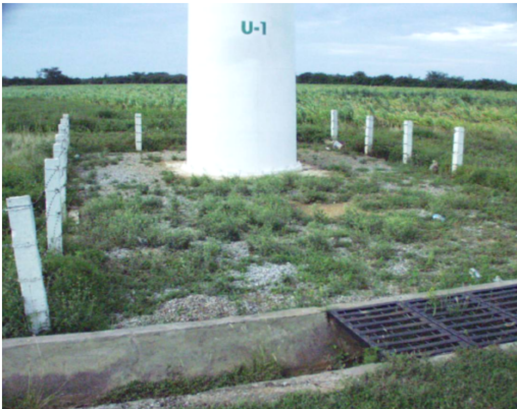
Figura IV.2.1.3-6. Base de uno de los aerogeneradores actualmente instalados del P.E. La Venta I. Obsérvese la compactación del terreno y la obra de drenaje en primer plano.
