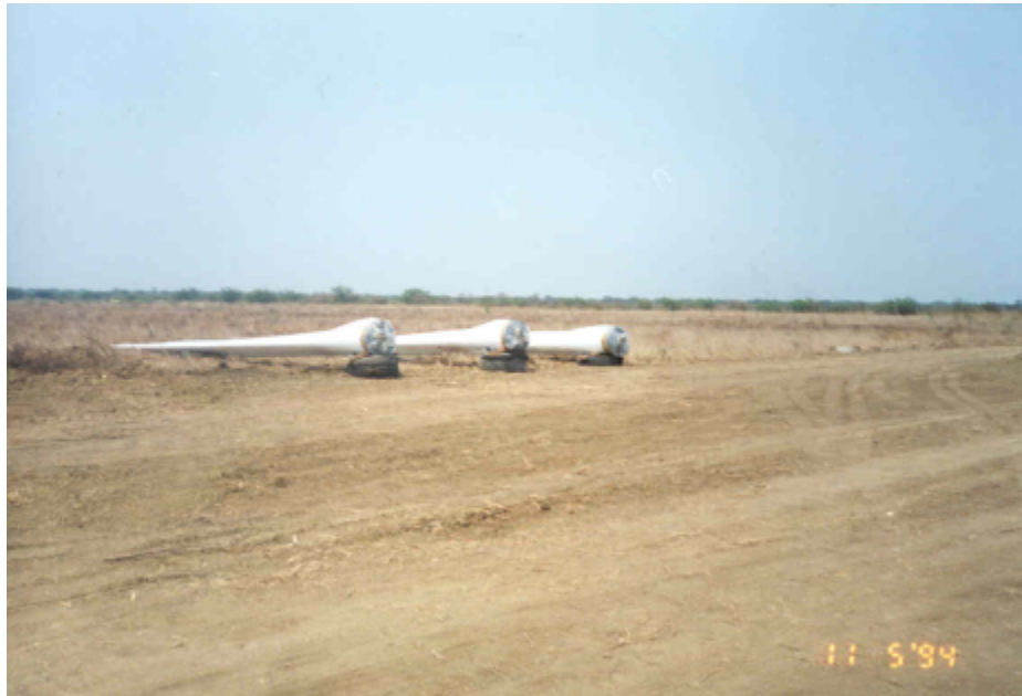
Colocación de los álabes en el campo antes de su instalación
