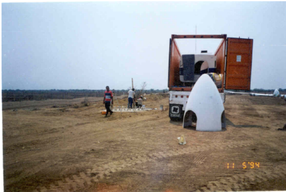
Colocación de cada equipo a un lado de la zapata, se observa que el material de la excavación se utilizó para rellenar el área de la zapata.
