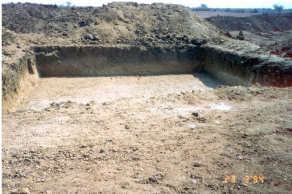
Excavación de la zapata para cada aerogenerador
