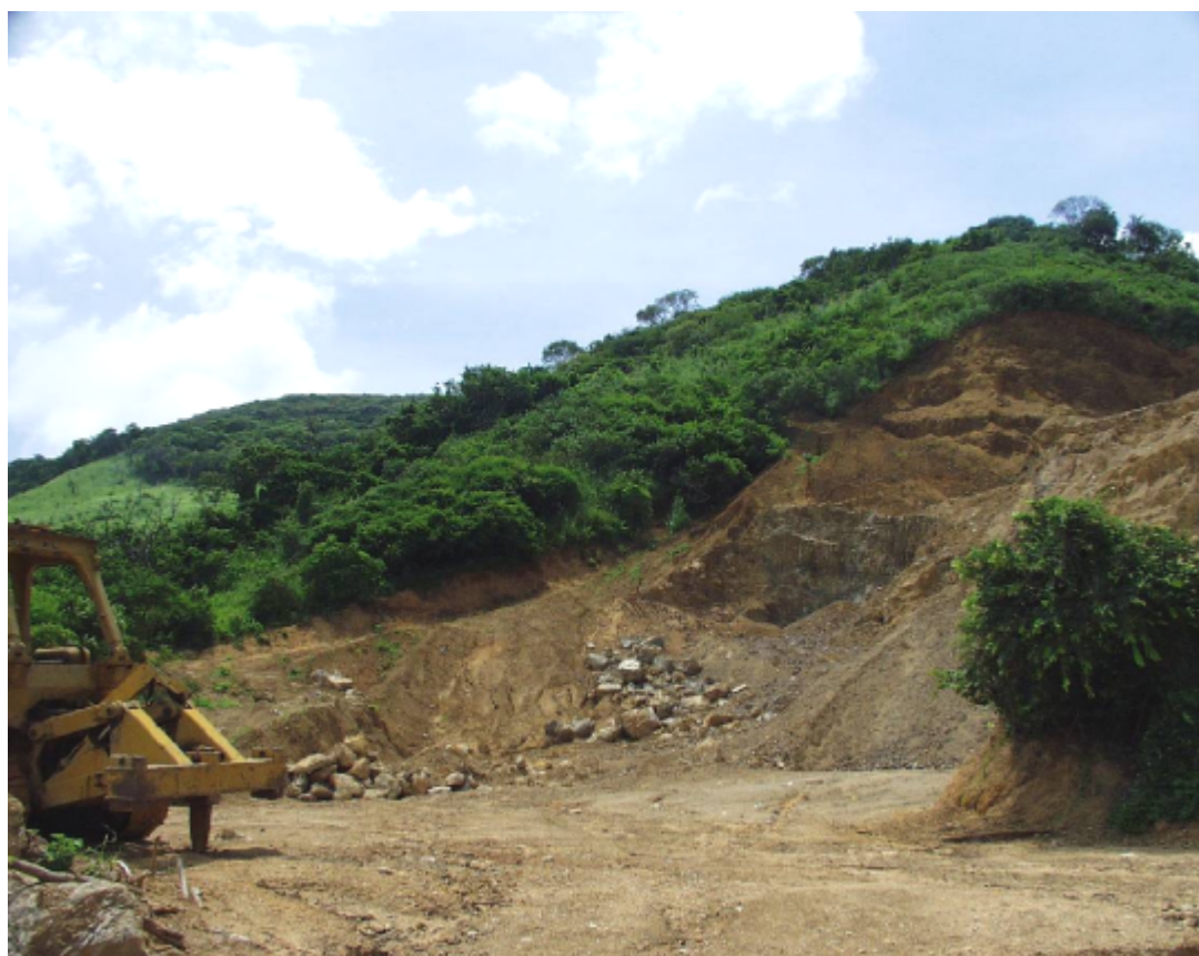
Figura IV.2.1.3-5. Corte en el terreno, correspondiente a un Cambisol Eútrico, ubicado al noreste del predio de la P.E. La Venta II.
