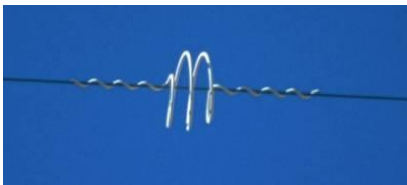
Figura VI-4. Disuasor de vuelo tipo espiral salva pájaros (BFD por sus siglas en inglés).
