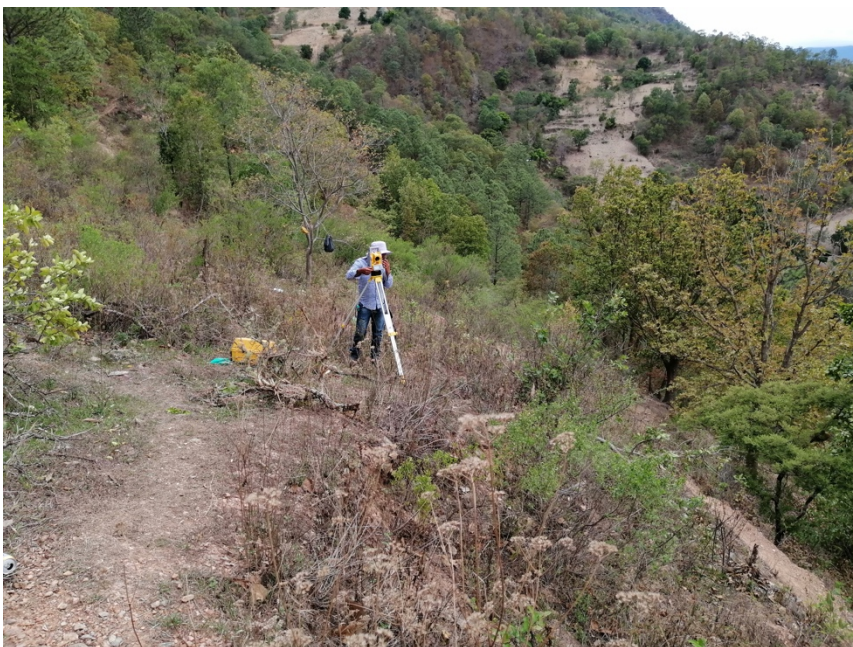
Foto 23.- Trabajos de topografía
