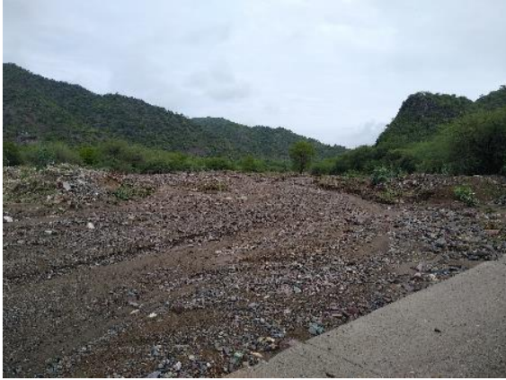
Vista con dirección O del cruce del puente
