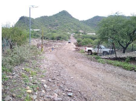
Vista con dirección N del cruce del puente
