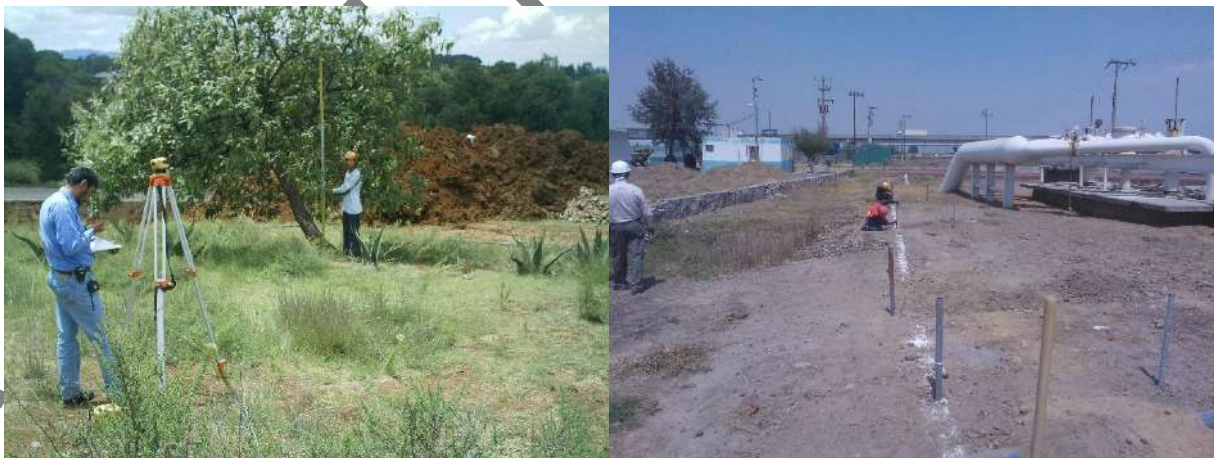
Foto II. 1. Ejemplo de trazo y marcación con cal y colocación de estacado.
