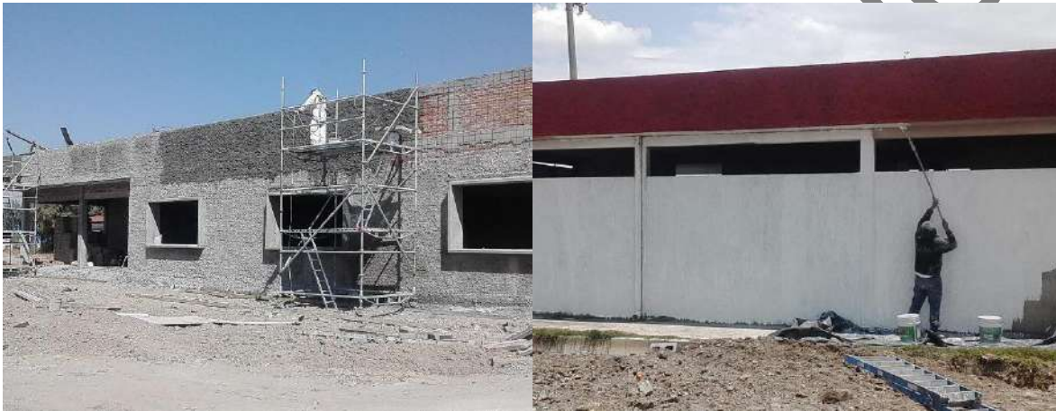
Foto II. 9. Ejemplo de acabados (repellado) y aplicación de pintura en muros de la estructura.
