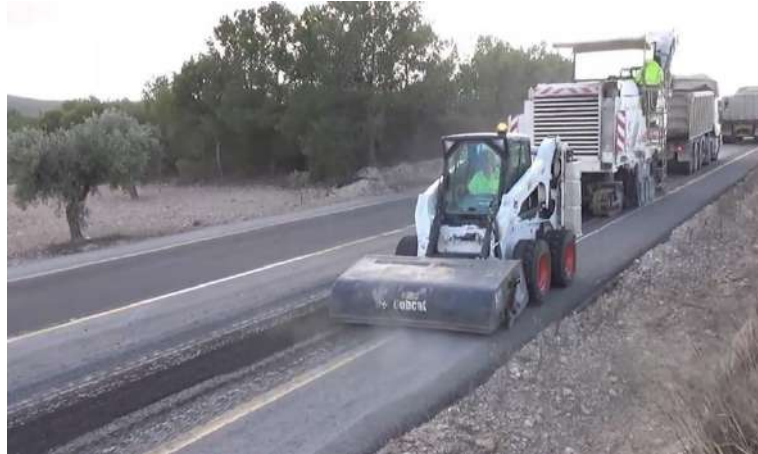
Foto II. 16. Ejemplo de fresado de carpeta asfáltica.
