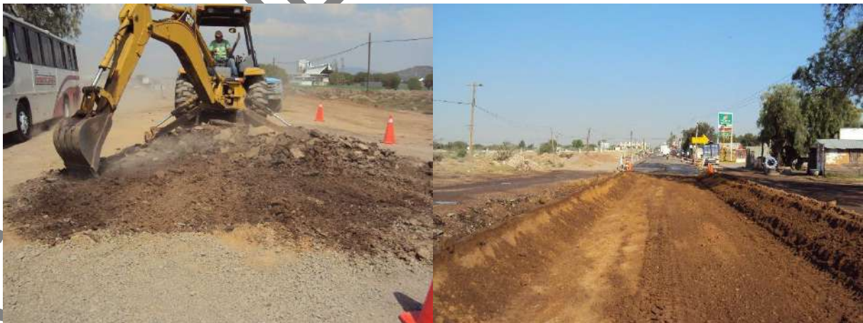
Foto II. 2. Ejemplo de apertura de caja para recepción de terracerías que conforman el cuerpo de terraplén de la plataforma.
