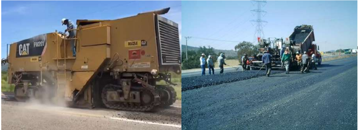
Foto II. 11. Ejemplo de fresado de carpeta asfáltica y colocación de concreto asfáltico.
