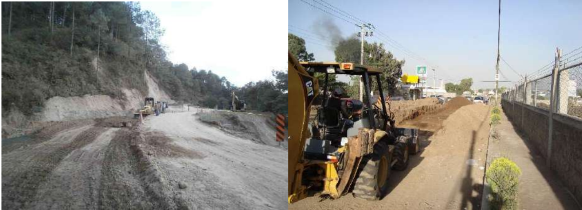
Foto II. 12. Ejemplo de excavación de caja para desplante de terracerías.
