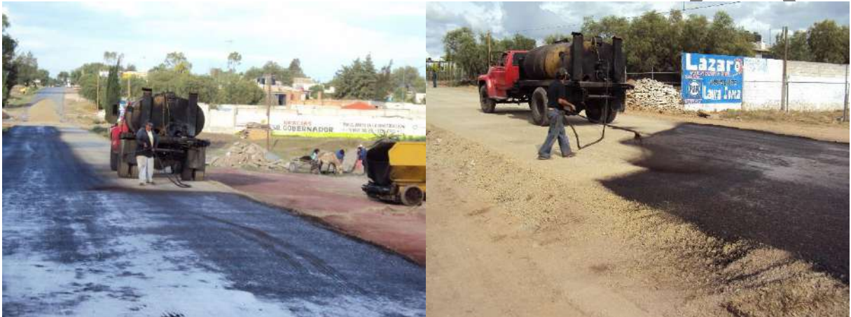
Foto II. 15. Ejemplo de aplicación de riego de emulsión asfáltica.
