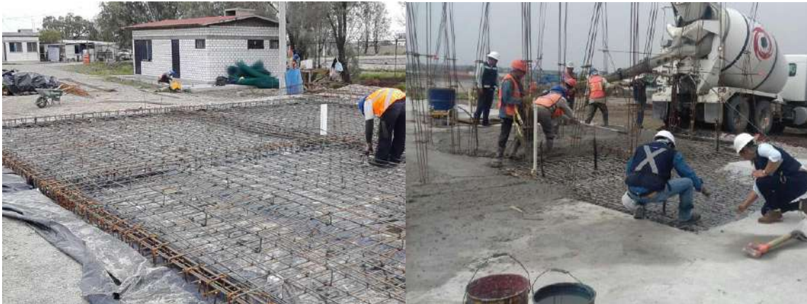
Foto II. 7. Ejemplo de tendido, armado de acero, colocación de cimbra y colado en cimentaciones.
