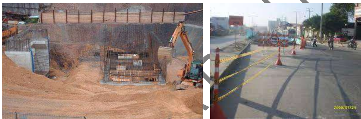
Foto VI. 3. Ejemplos de delimitación de áreas de trabajo en obras constructivas.
