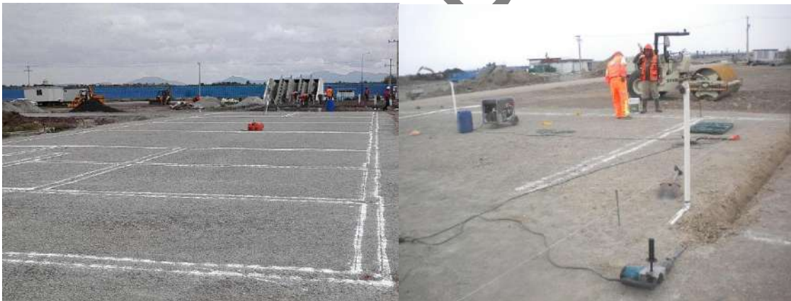
Foto II. 6. Ejemplo de trazo, excavación de zanjas para zapata y colocación de servicios sanitarios e hidráulicos.
