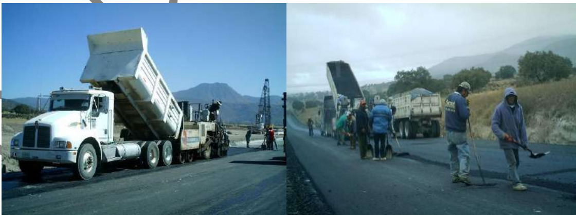
Foto II. 17. Ejemplo de tendido de carpeta asfáltica.
