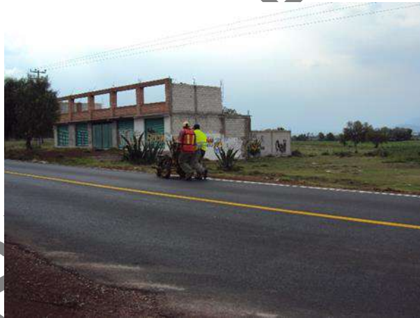
Foto II. 18. Ejemplo de Colocación de señalamiento horizontal.
