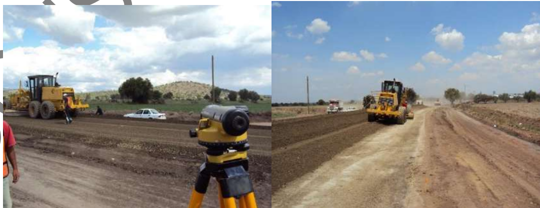
Foto II. 13. Ejemplo de suministro y tendido de capas de terracerías.
