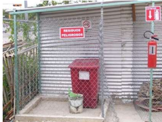
Foto VI. 9. Ejemplo de un Almacén de acopio temporal de residuos peligrosos, en donde se indica el tipo de material resguardado en el área y extintor señalado adecuadamente.
