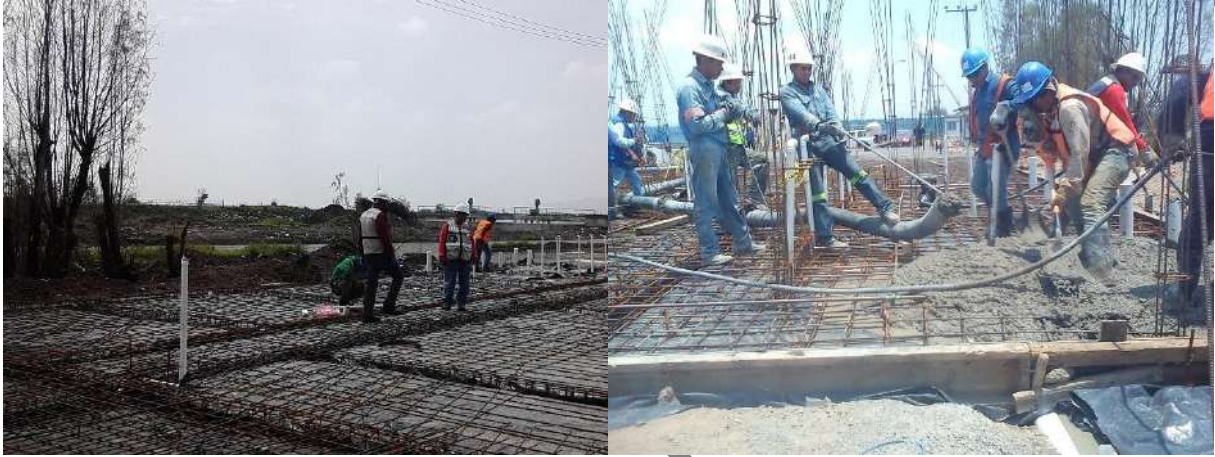
Foto II. 4. Ejemplo de tendido, armado de acero, colocación de cimbra y colado en cimentaciones.
