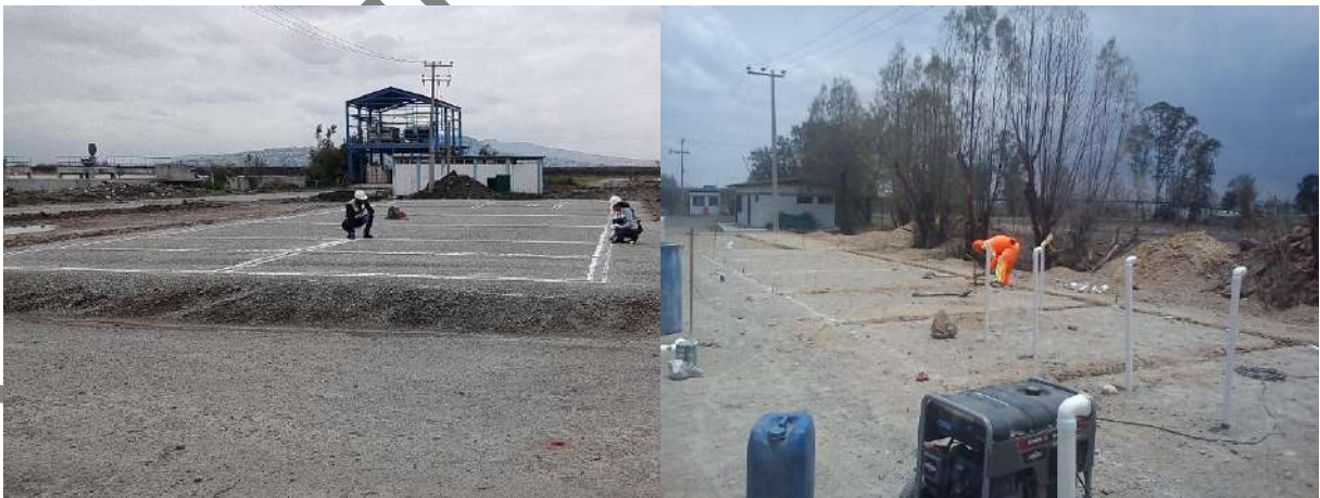
Foto II. 3. Ejemplo de trazo, excavación de zanjas para zapata y colocación de servicios sanitarios e hidráulicos.
