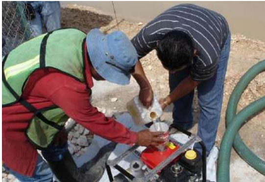
Foto VI. 2. Ejemplo de carga de combustible in situ . A) Llenado de gasolina de una bomba para extraer el agua, debajo lado izquierdo se puede observar el uso de una lona para prevenir posibles derrames de combustibles sobre el suelo; B) Carga de diésel a un vibro compactador usando una lona sobre el suelo natural para evitar posibles derrames de combustible y el uso de equipo de protección personal adecuado
