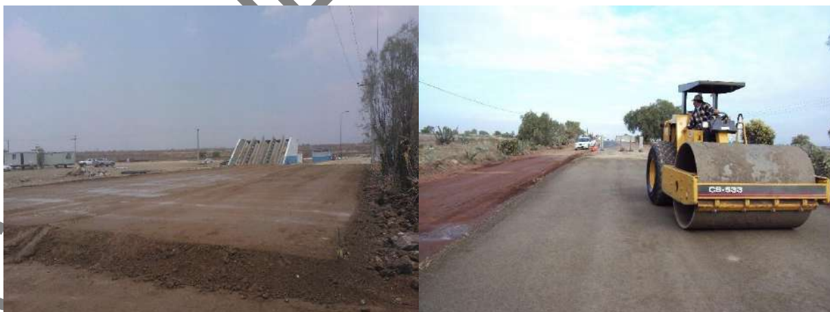
Foto II. 14. Ejemplo de conformación y compactación de capa de material base hidráulica.
