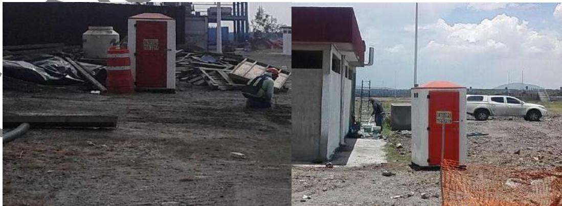
Foto II. 20. Ejemplo de Instalación de Sanitarios Portátiles.
