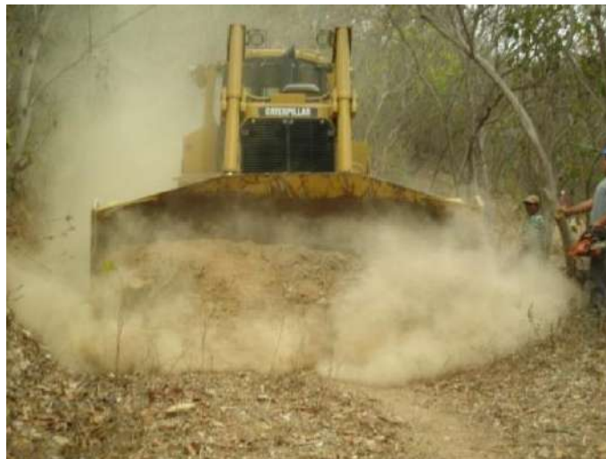
Foto V. 1. Ejemplo de dispersión de polvo y gases generados por la operación de maquinaria durante los trabajos de despálme.
