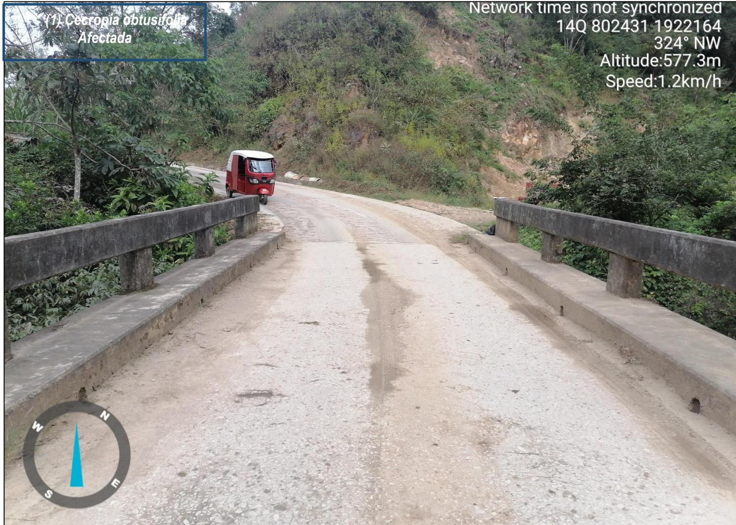
Figura IV.25. Puente existente, nótese que por sus dimensiones no cumple con las características que requiere el tránsito diario que requiere el proyecto.
