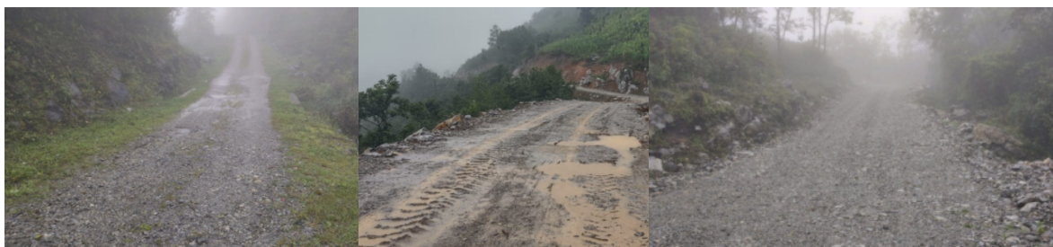
Figura 5.1. Fotografías de la brecha actual, así como de los taludes de corte existentes en el mismo.
