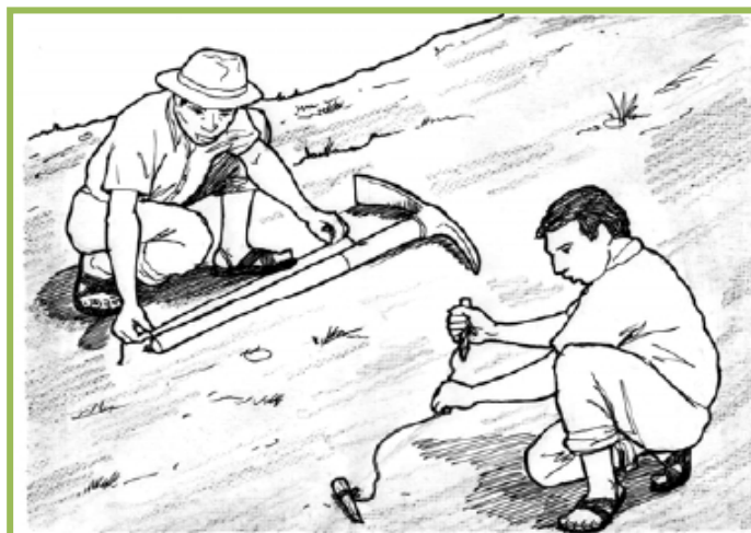
Figura 6.20. Trazado de terrazas individuales.
