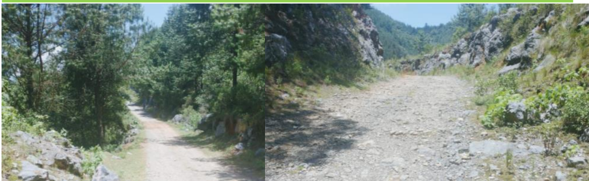
Figura 5.1. Fotografías del camino actual, así como de los taludes de corte existentes en el mismo.
