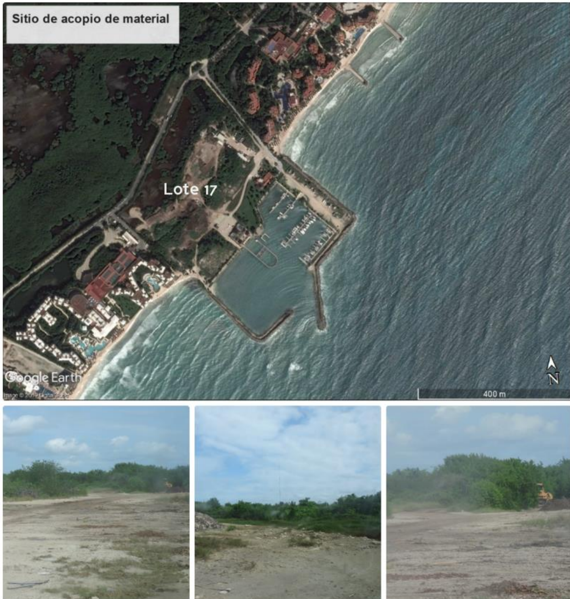
Figura 23. Arriba: vista aérea del lote 17 que será el sitio de acopio de material resultante del retiro de las piezas que conforman las estructuras permeables; abajo: vista terrestre del lote 17.
