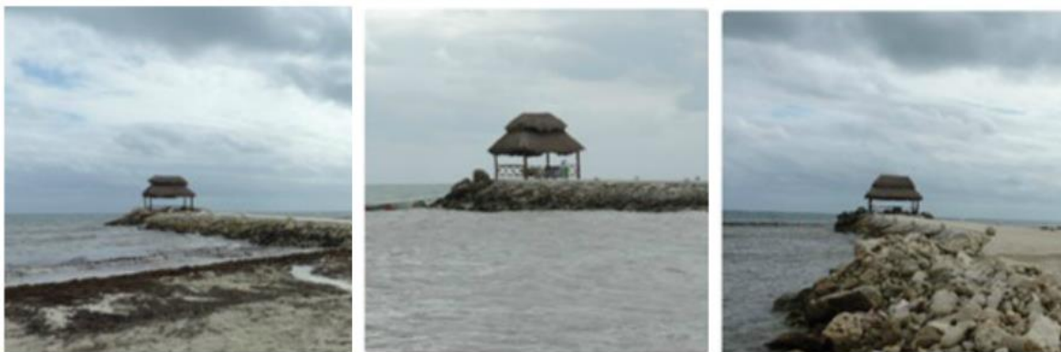
Figura 21. Arriba: estructuras impermeables (espigones) que se proponen retirar y sustituir por andadores piloteados; abajo: islotes existentes que se proponen mantener.
