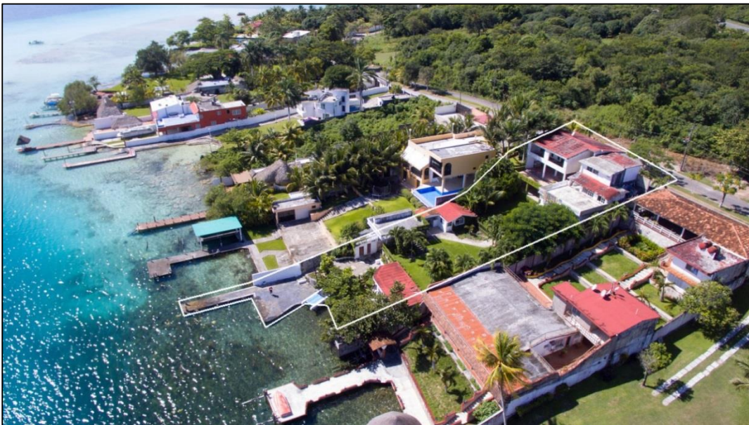
Vista aérea de la casa que será demolida (delimitada por un polígono blanco), para realizar el proyecto de hospedaje Hotel Color Bacalar, sobre el Boulevard Costero de Bacalar Sur, en el Municipio de Bacalar y en colindancia con la laguna de Bacalar, al sur del estado de Quintana Roo.
