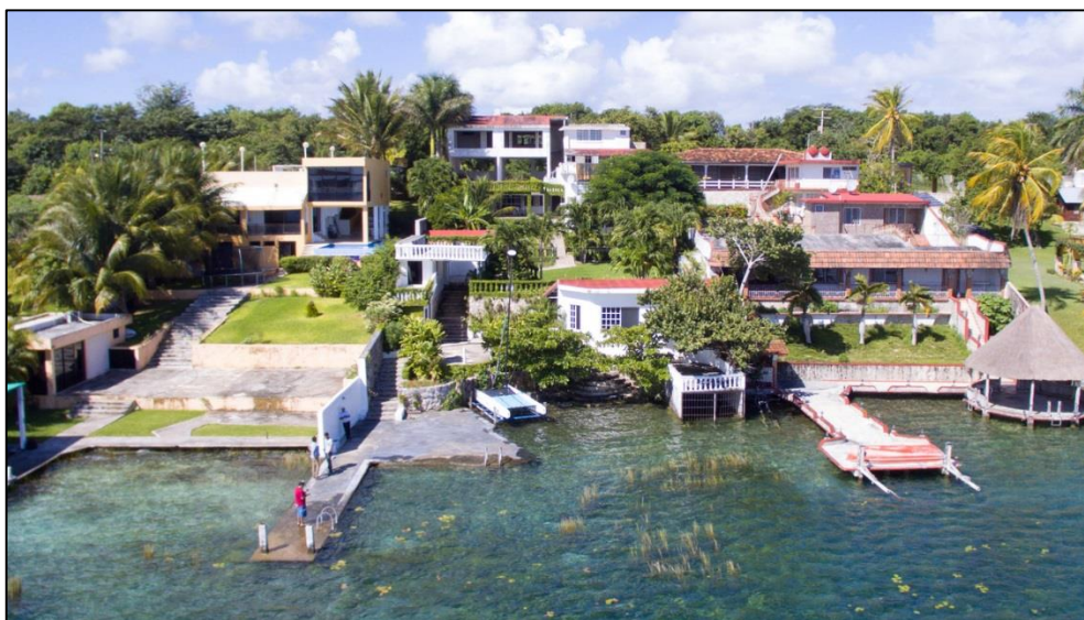
Vista actual del predio con la construcción de una casa, misma que se remodelará, en su entorno natural a la orilla de la laguna Bacalar.
