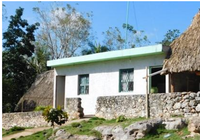
Figura IV. 36 Viviendas de block y techo de concreto
