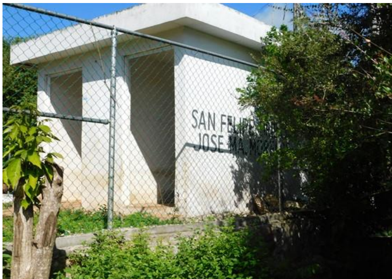
Figura IV. 38 Servicio de distribución de agua entubada y clorada.
