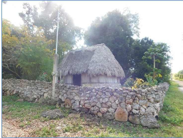
Figura IV. 35 Vivienda tradicional de madera y techumbre de palma
