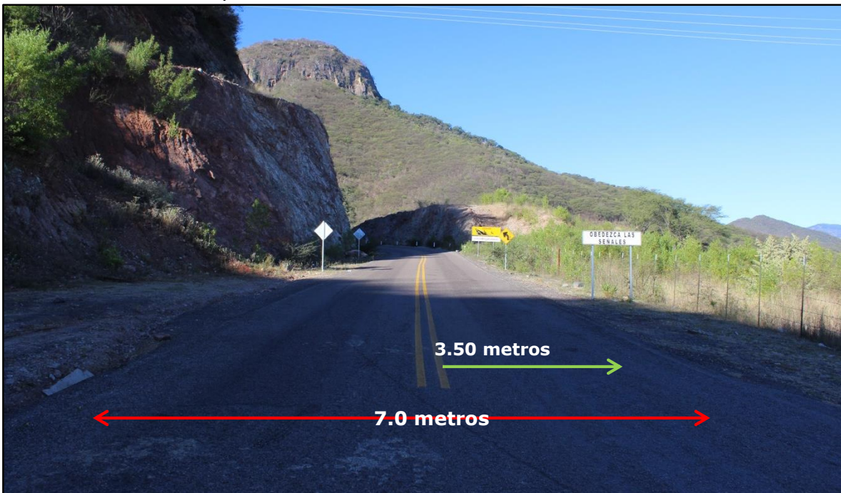
Fotografía No.8 El tramo que se pretende construir tendrá este tipo de sección, mismo que se localiza en Carretera federal México-24 a la altura del cruce de Soyatita, Badiraguato, Sinaloa.
