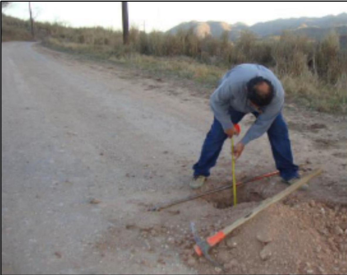
Fotografía No.10 El camino que se pretende habilitar cuenta con accesos en los puntos extremos (0+000 y 40+346).
