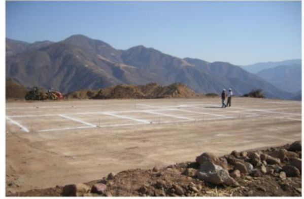
Figura II-39. Desmonte en zona de plataforma (izquierda); Trazo y nivelación para ubicar las referencias del edificio (derecha).
