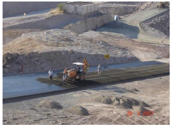
Figura II-71. Riego de impregnación sobre base hidráulica (izquierda); Riego de impregnación y poreo con arena (derecha).
