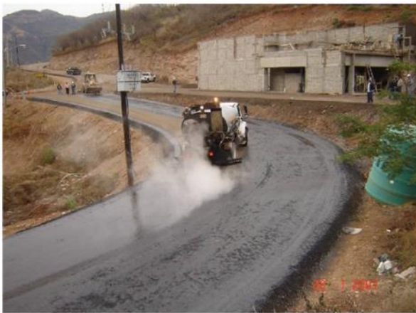
Figura II-71. Riego de impregnación sobre base hidráulica (izquierda); Riego de impregnación y poreo con arena (derecha).
