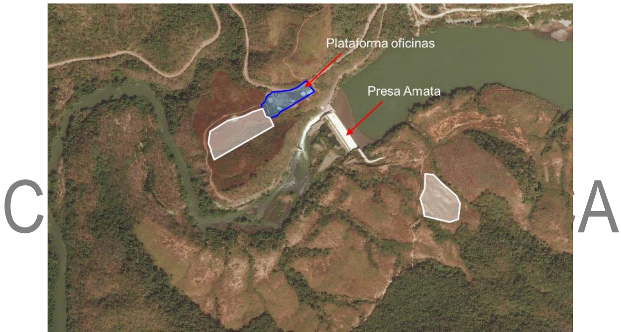
Figura II-38. Vista de la plataforma de oficinas.
