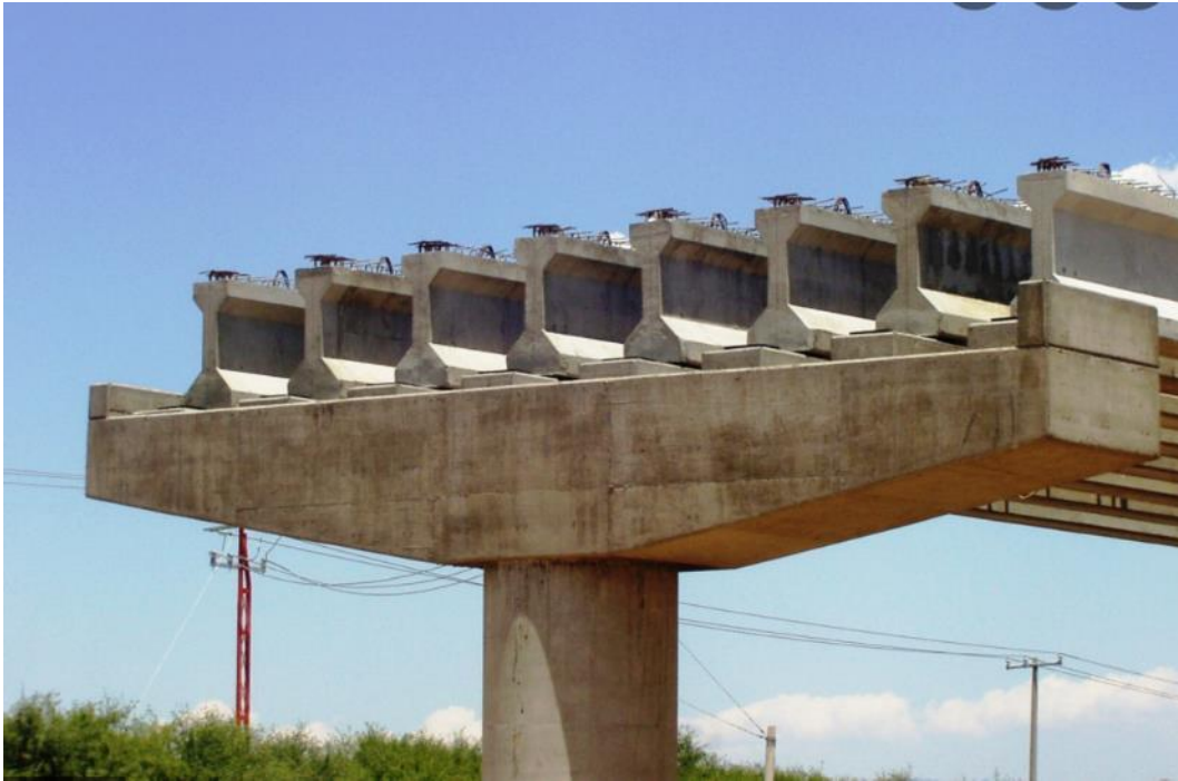
Figura II-85. Dovelas de apoyo para las trabes.
