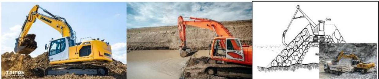
Figura II-56. Esquema del proceso constructivo en la formación de la ataguía.
