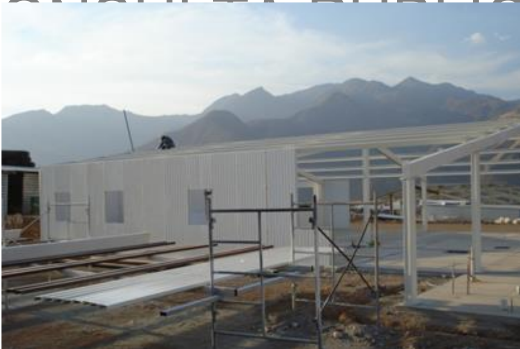
Figura II-44. Montaje de estructura ligera y muro multipanel.
