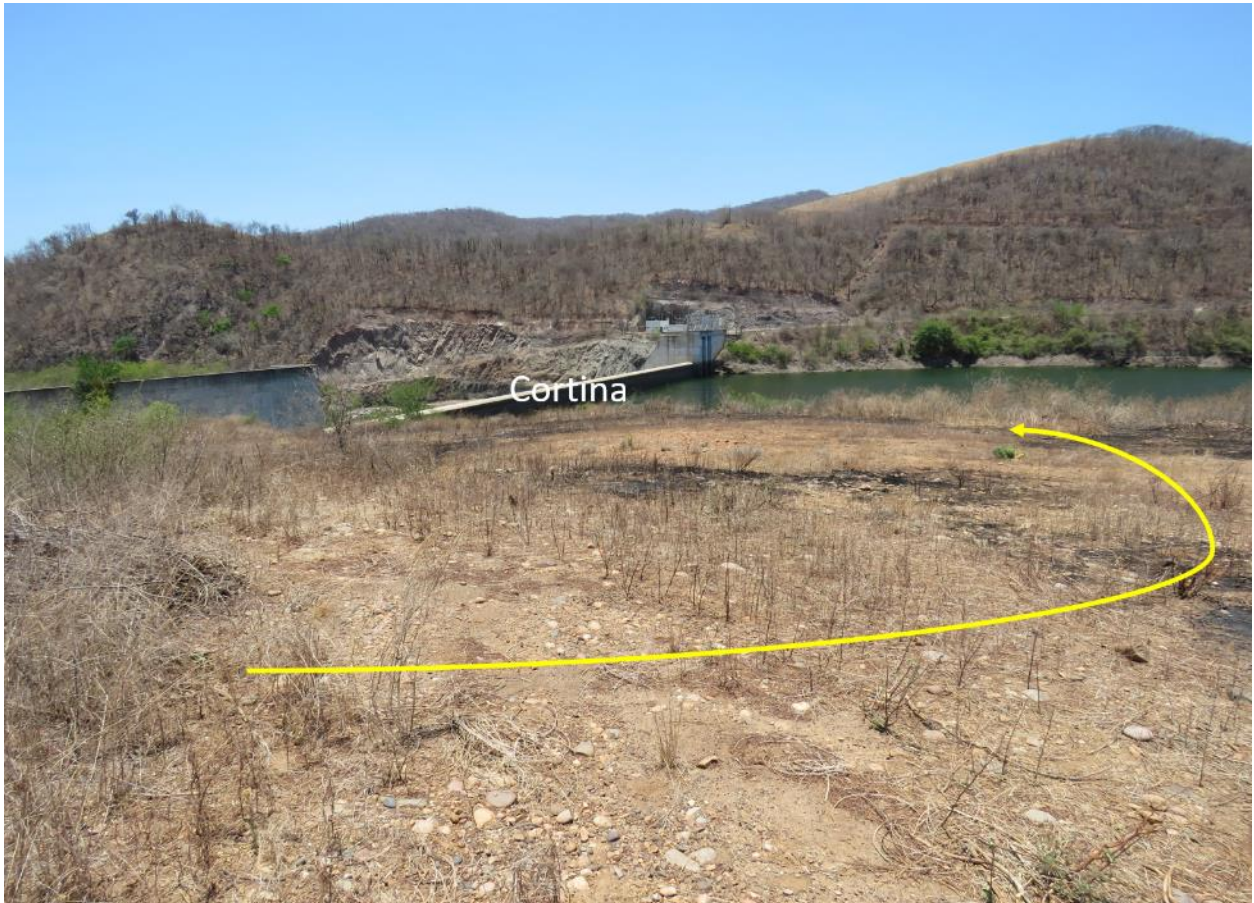
Figura II-96. (Foto 6) Segmento del camino, que se dirige hacia la obra de toma y hacia la ataguía, observando uso de suelo agrícola con herbáceas y arbustivas.
