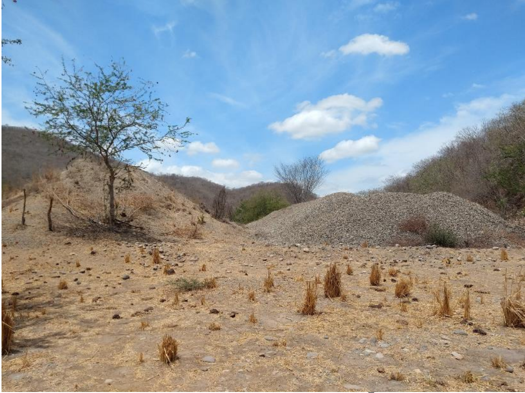
Figura II-53. Banco de materiales empleado durante la construcción de la presa Amata (2005).
