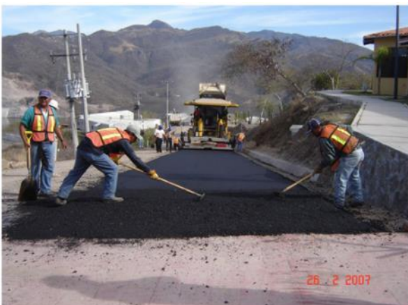
Figura II-72. Colocación de carpeta de concreto asfáltico (izquierda); Riego de sello P.U.O.T (derecha).
