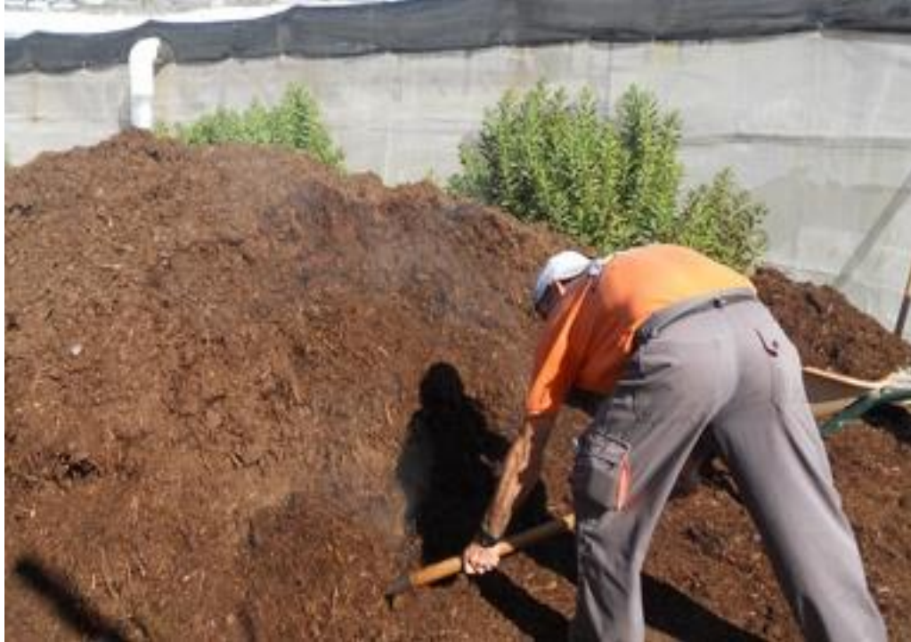
Figura VII-24. Utilización de suelo orgánico obtenido de los trabajos de despalme.
