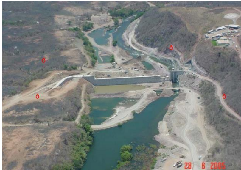
Figura II-5. Superficie e infraestructura de la presa reguladora contemplada por el esquema del PEH.
