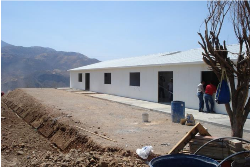
Figura II-45. Montaje de cubierta a base de de multipanel.
