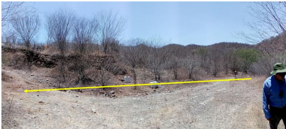
Figura II-92. Foto 2) Segmento del camino con trazo hacia casa de máquinas, observándose vegetación tipo achual (secundaria) y áreas desprovistas de forma aparente de vegetación.
