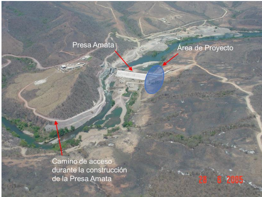
Figura II-68. Camino de acceso durante la construcción de la presa Amata (2005).
