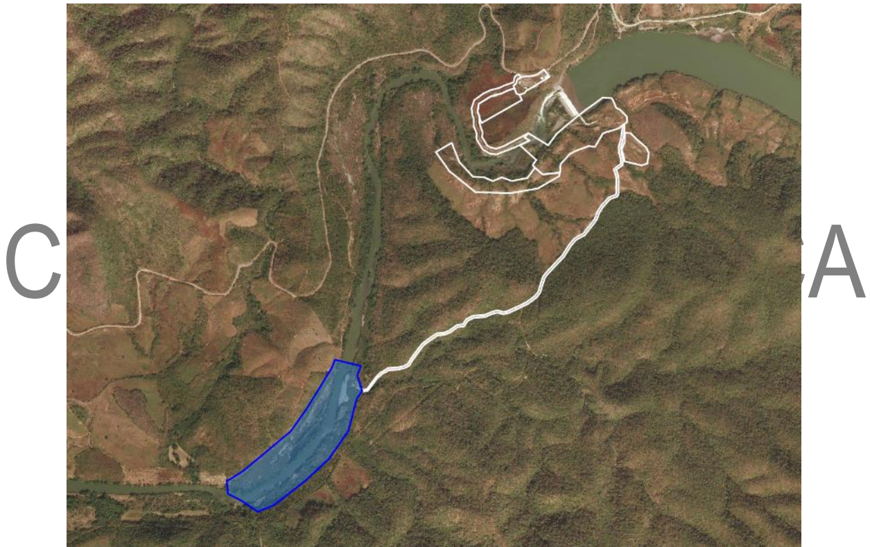
Figura II-18. Ubicación del banco de materiales y vado
