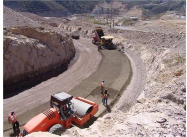
Figura II-70. Colocación subrasante (izquierda); colocación de base hidráulica (derecha).
