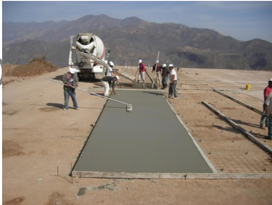
Figura II-40. Colado de losa de cimentación, con concreto hidráulico.
