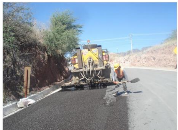
Figura II-72. Colocación de carpeta de concreto asfáltico (izquierda); Riego de sello P.U.O.T (derecha).
