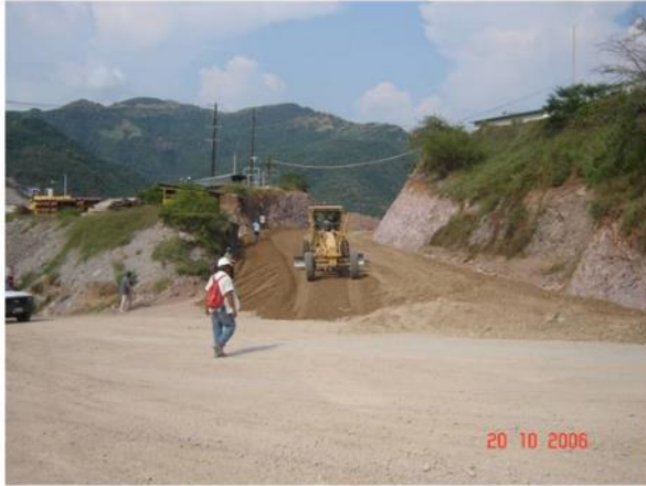
Figura II-70. Colocación subrasante (izquierda); colocación de base hidráulica (derecha).
