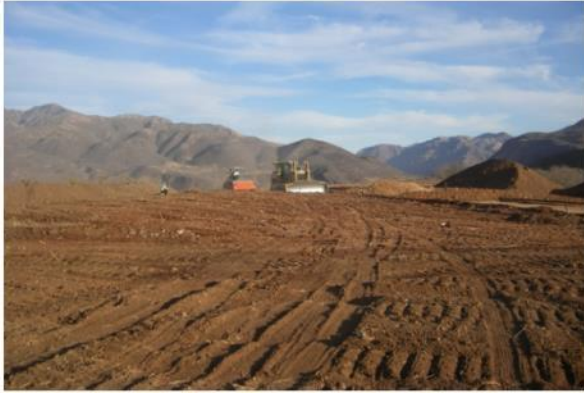
Figura II-39. Desmonte en zona de plataforma (izquierda); Trazo y nivelación para ubicar las referencias del edificio (derecha).
