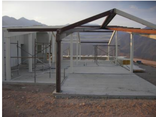
Figura II-43. Esqueleto del edificio con perfiles ligeros (MON-TEN) y muro multipanel
