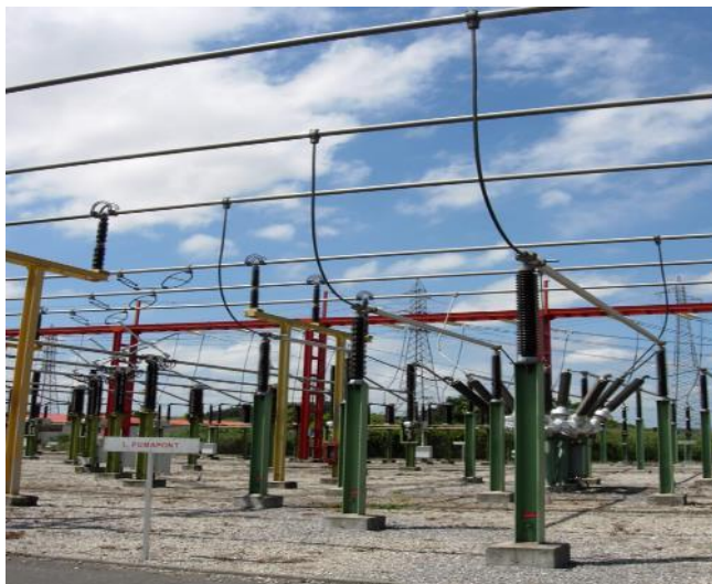
Figura II-63 Barras de transferencia
