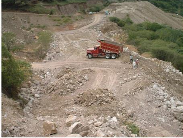
Figura II-80. Construcción de terraplén.
