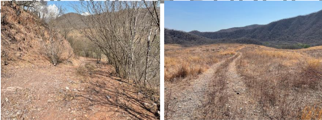
Figura II-69. Condiciones actuales del camino de Margen Derecha.
