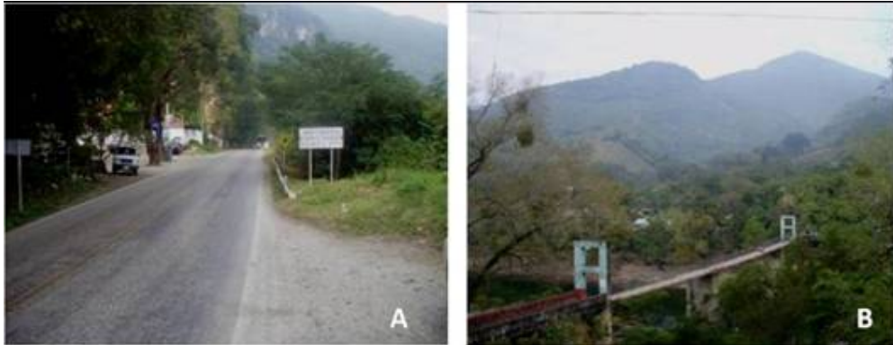
Figura 0.26. A) Ubicación del trazo del libramiento por la margen izquierda del río Moctezuma, al norte del poblado de Mizquetla. B) Puente peatonal (colgante), en un sitio próximo al puente vehicular que se proyecta como parte del libramiento poniente para a travesar el río Moctezuma
