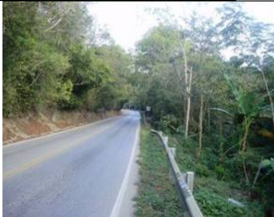
Figura IV.29. Carretera Federal No, 85, con dirección a ciudad valles, en la zona donde entronca el libramiento a Tamazunchale, a la altura de la localidad de Palictla.
