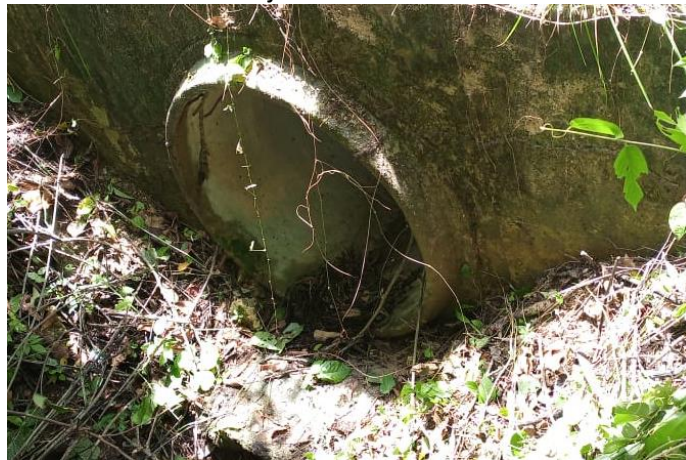
Obra de drenaje ubicada en Km 7+722.934
