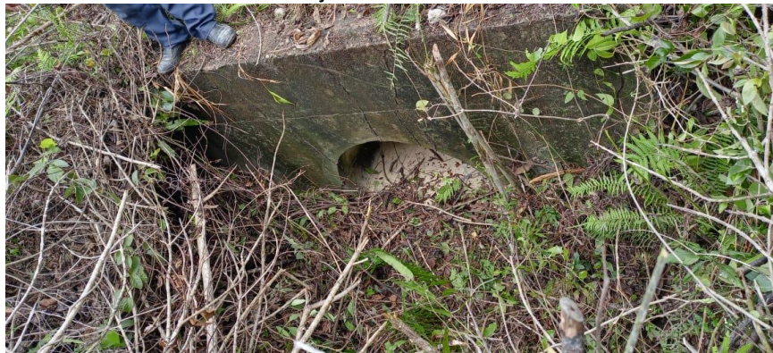
Obra de drenaje ubicada en Km 5+783.236
