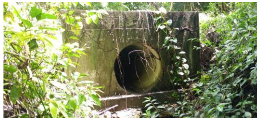
Obra de drenaje ubicada en Km 4+451.688 lado izquierdo del camino, construida a base de tubería de concreto de 91 cm, la cual no presenta obstrucción en su área hidráulica.
