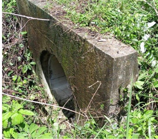
Obra de drenaje ubicada en Km 7+970.403
