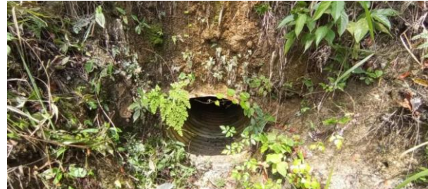
Obra de drenaje ubicada en Km 6+781.968 lado izquierdo del camino, construida a base de tubería de acero de 91 cm, la cual no presenta obstrucción en su área hidráulica.
