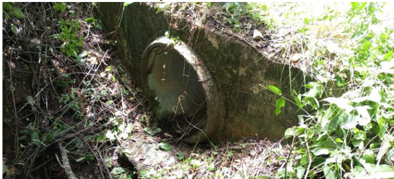
Obra de drenaje ubicada en Km 4+600
