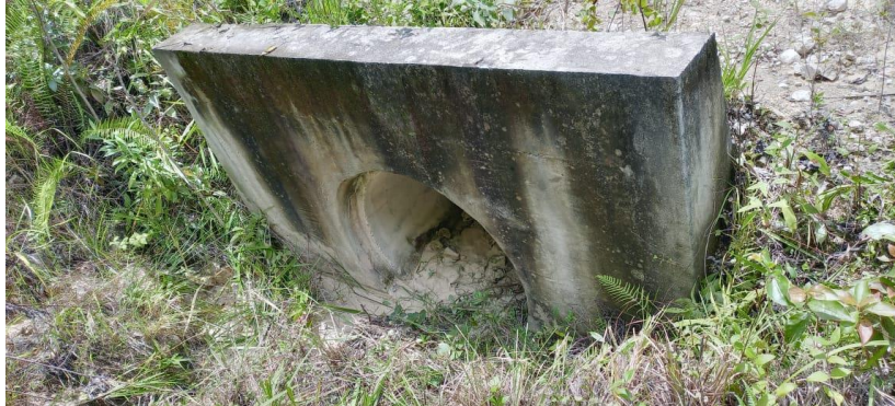
Obra de drenaje ubicada en Km 5+737.026
