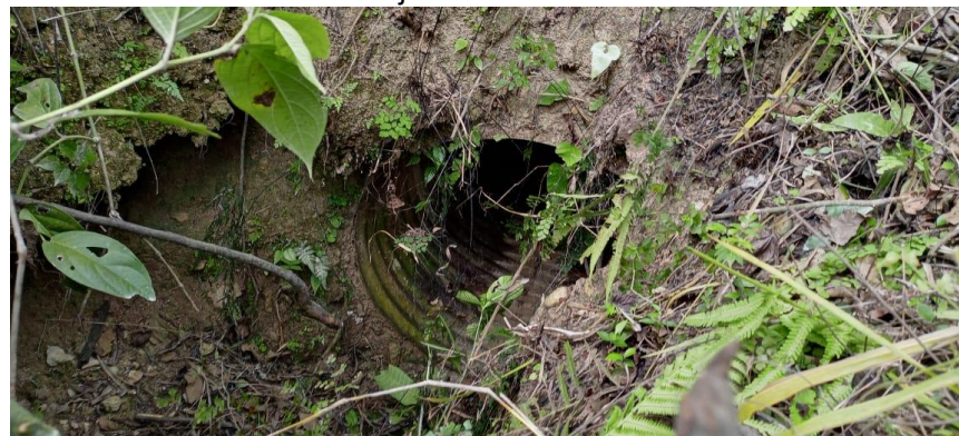
Obra de drenaje ubicada en Km 6+010.508
