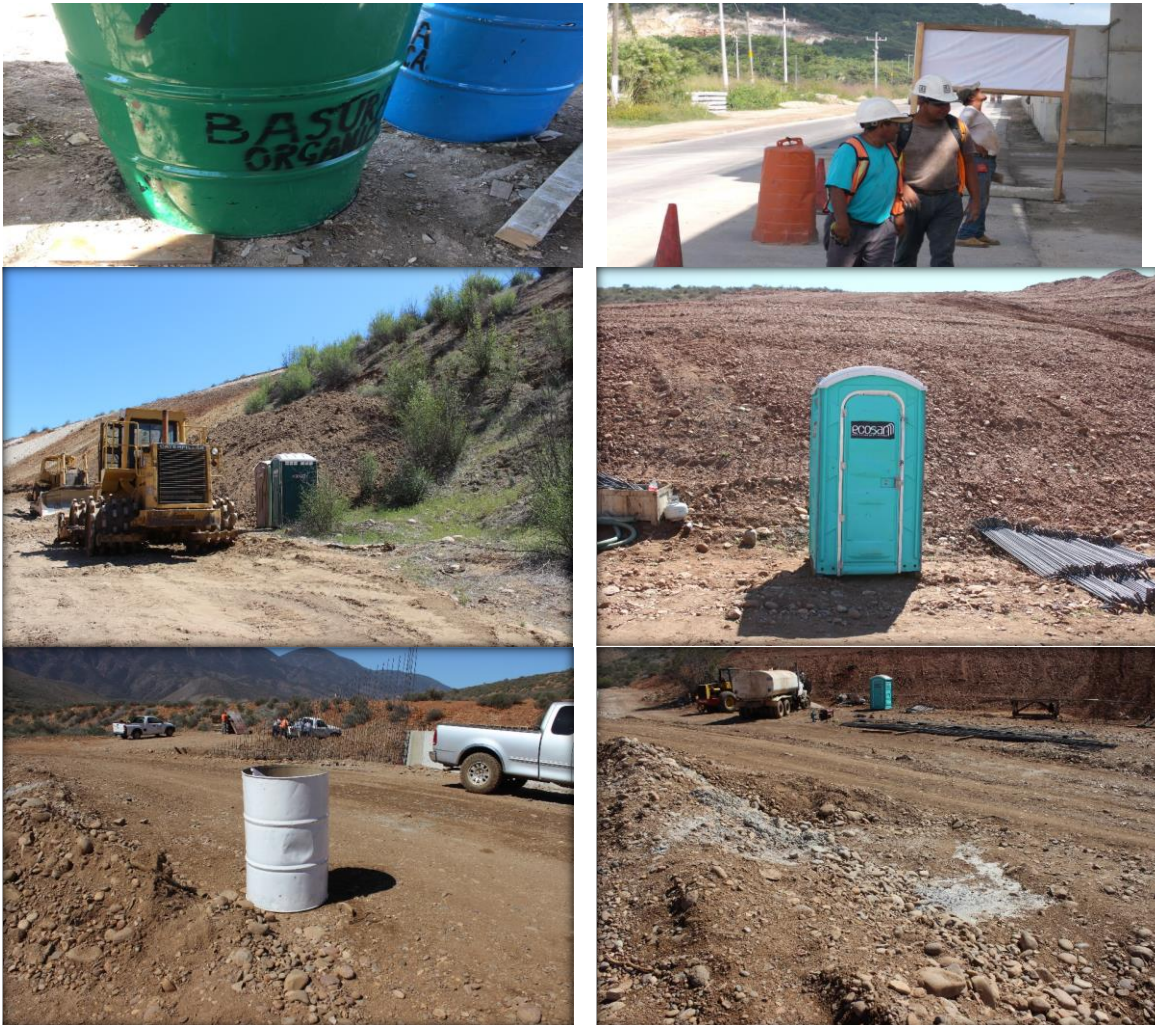
FIGURA II-13 EJEMPLO DE FRENTES DE OBRA EN PROYECTOS CARRETEROS
