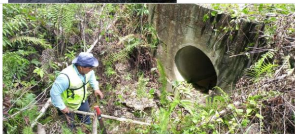
Obra de drenaje ubicada en Km 5+737.026 lado derecho del camino, construida a base de tubería de concreto de 91 cm, la cual no presenta obstrucción en su área hidráulica
