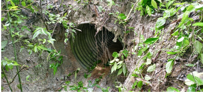
Obra de drenaje ubicada en Km 6+660
