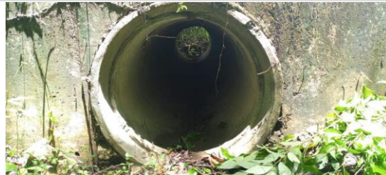
Obra de drenaje ubicada en Km 7+722.934 lado izquierdo del camino, construida a base de tubería de concreto de 91 cm, la cual no presenta obstrucción en su área hidráulica.
