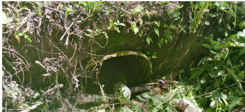
Obra de drenaje ubicada en Km 2+144.83
