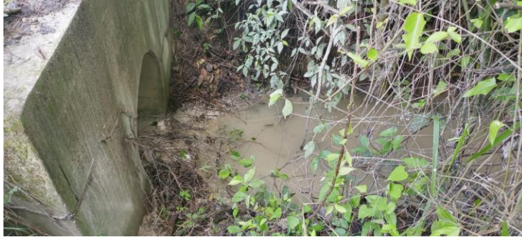
Obra de drenaje ubicada en Km 1+005.414
