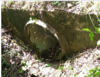
Obra de drenaje ubicada en Km 7+722.934 lado derecho del camino, construida a base de tubería de concreto de 91 cm, la cual no presenta obstrucción en su área hidráulica.
