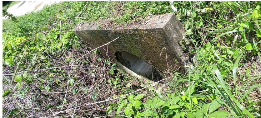
Obra de drenaje en Km 2+845.216
