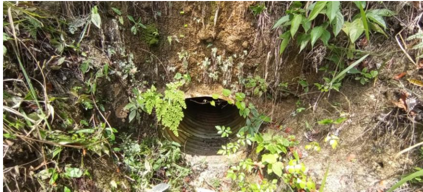
Obra de drenaje ubicada en Km 6+781.968
