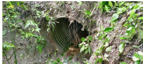
Obra de drenaje ubicada en Km 6+660 lado izquierdo del camino, construida a base de tubería de concreto de 91 cm, la cual no presenta una obstrucción en su área hidráulica
