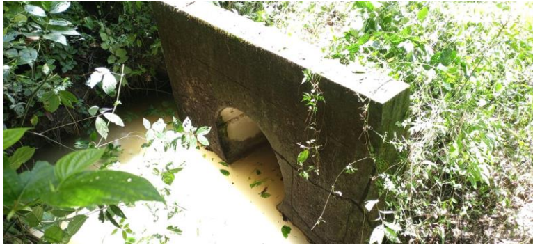
Obra de drenaje ubicada en Km 4+451.688
