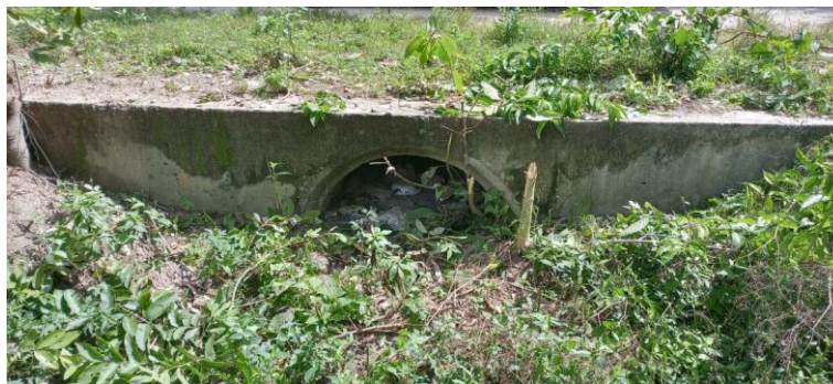
Obra de drenaje ubicada en Km 0+293.626
