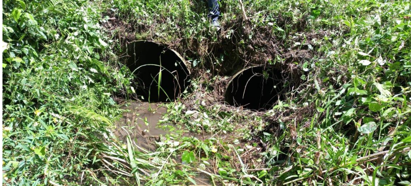
Obra de drenaje ubicada en Km 3+878.789
