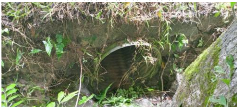
Obra de drenaje ubicada en Km 6+660 lado derecho del camino, construida a base de tubería de acero de 91 cm, la cual no presenta obstrucción en su área hidráulica
