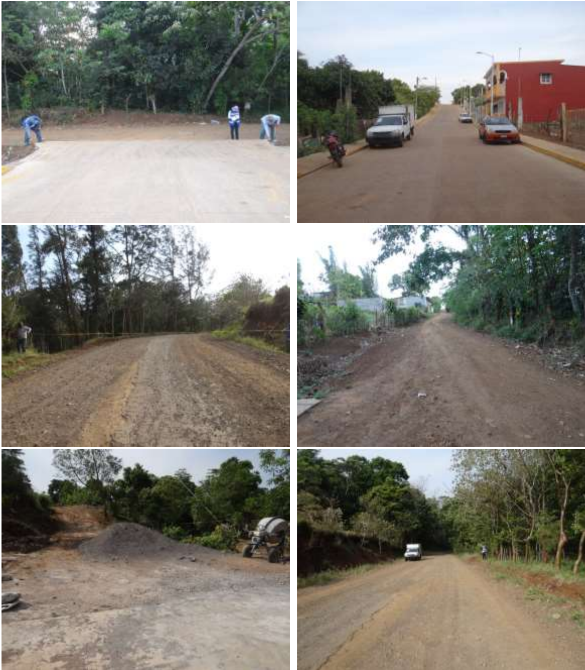
Figura 9. Condiciones de sitios en los que se pudiera estacionar o resguardar maquinaria
