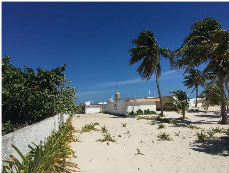
Fotografía 1 Vista frontal y fachada principal de la casa existente.
