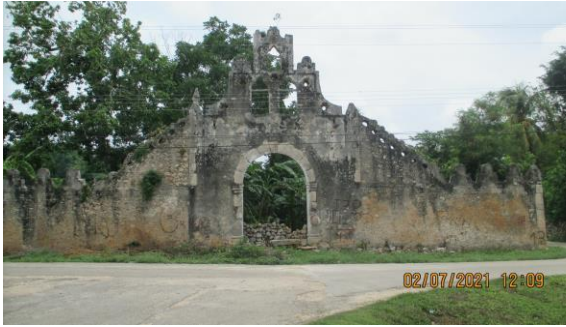
Fachada del Templo de San Juan Bautista que se localiza a 100 de distancia del Km 00+200
