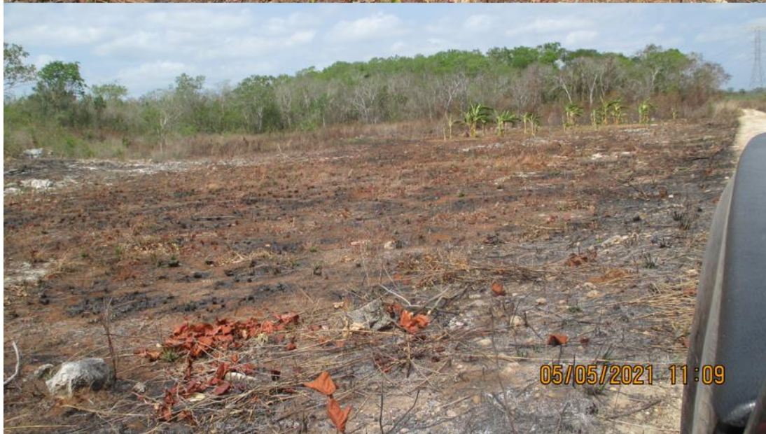
FIGURA II-20 SITIO PARA PATIO DE MANIOBRAS DE LA SEGUNDA ETAPA CORRESPONDIENTE AL TRAMO DEL KM 002+040 AL KM 004+080
