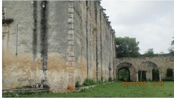
Estructura del Convento de San Juan Bautista
