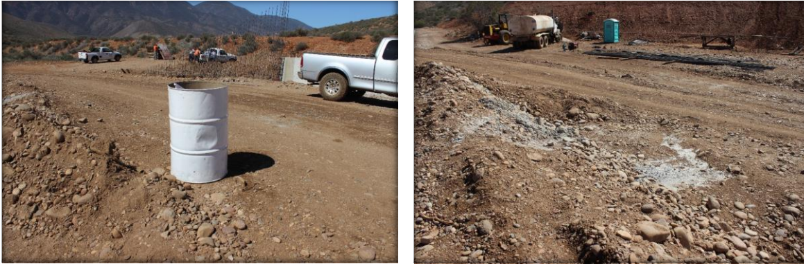
FIGURA II-17 EJEMPLO DE FRENTES DE OBRA EN PROYECTOS CARRETEROS
