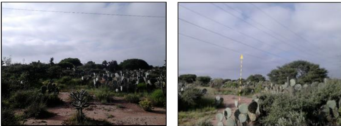
Figura II. 7. Identificación de infraestructura eléctrica en operación (punto de conexión del proyecto).
