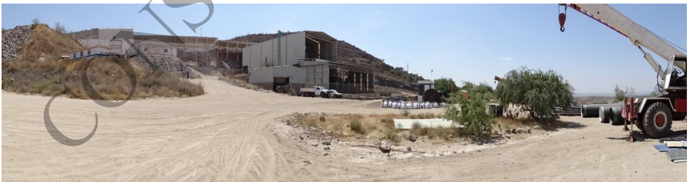
Figura 2. 7. Estado Actual de la Infraestructura Existente (Zona Industrial)
