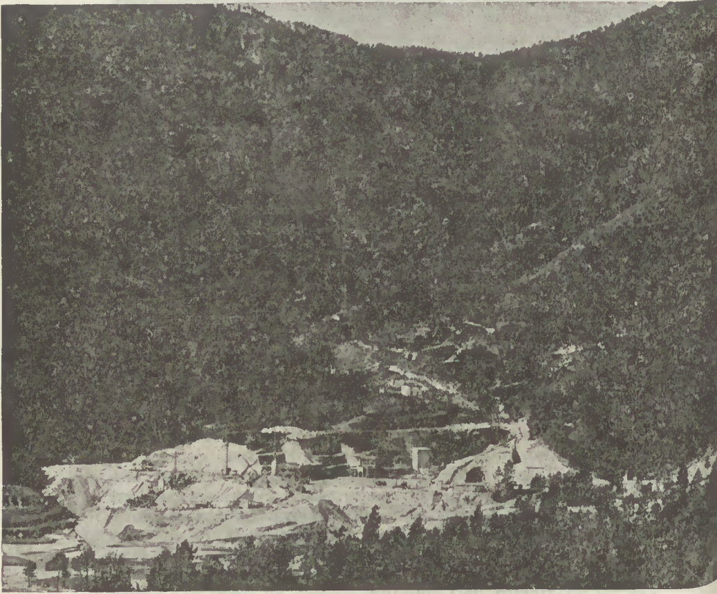
Local de construção da central de Vilarinho da Furna
