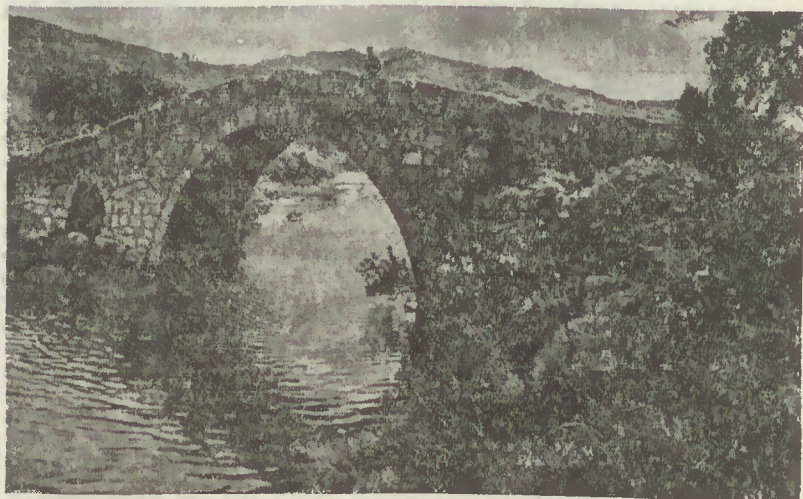
Ponte em Vilarinho da Furna que as águas agora vão cobrir para originar a barragem de Vilarinho. Intenções do Município de Terras de Bouro de a levar para o Museu, a instituir em Campo
