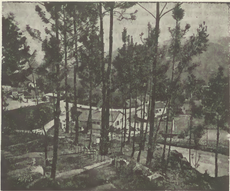
Sítio saudável entre pinheiros, a montanha, o vale e a água foi construído o «Bairro do Pessoal», em serviço nas barragens, com casas muito caiadas de branco, higiénicas e confortáveis, vendo-se também a pousada
