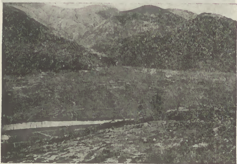
Como a fénix que renasce das cinzas eis um aspecto da barragem sem água
