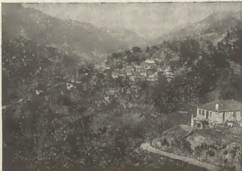
Vilar da Veiga anterior ao novo perfil motivado pela barragem da Caniçada. Repare-se na linha longitudinal directa à Portela, perdendo-se no esfumado da terra galega
