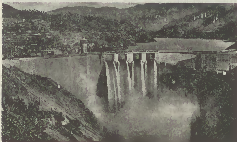
Aproveitamento hidroeléctrico da Caniçada
