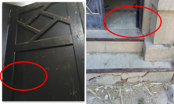
(صورة ١٨-أ) الجزء العلوي لباب خشبي ذي ضلفتين في مدخل القبة وتنتضح عليه أحد العناصر الاسلامية (المفروكة) ويظهر تكسير وتلف الباب الخشبي. (صورة ١٨-ب) توضح السلالم أسفل الباب وهي تعاني من الكسور والشروخ © تصوير الباحث.
