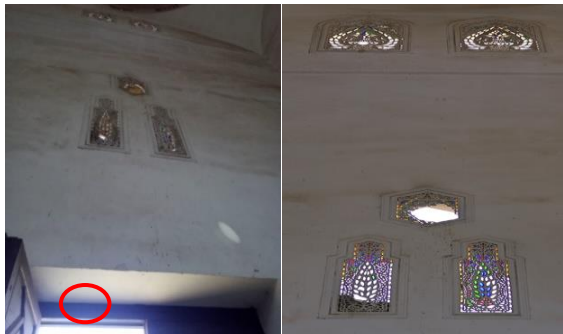
(صورة ١٠-أ) توضح القنديلية البسيطة أعلى الباب. وتراكم الأثرية لسنوات والتصاقها بالجدران والشبائيك. (صورة ١٠-ب) الشبائيك الجصية تعلوها قبة نصف دائرية. فقد نهائي لأجزاء من الجص والزجاج في الفتحة العلوية.
