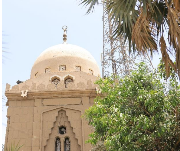
(صورة ٢٢) توضح الأشجار الكثيفة وأبراج الكهرياء العالية الملاصقة للقبة © تصوير الباحثة.
