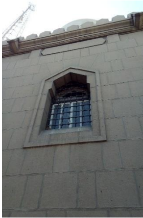
(صورة ٨-أ) توضح الشكل الخارجي للمقبرة من الجانب الأيسر من أعلى والمزاريب لتصريف المياه. (صورة ٨-ب) الجانب الأيمن والشباك الزجاجي مكسور منه أجزاء بما يسمح بدخول الأتربة والطيور إلى الداخل.
