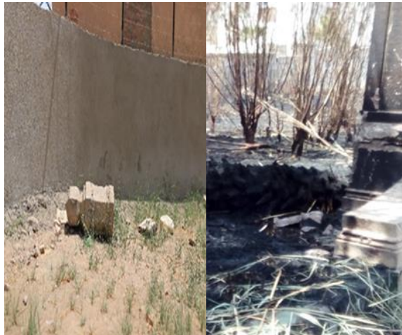
(صورة ٢٤) حرق الحشائش حول القبة مما يسبب الأضرار للقبة وتراكم السناج على عناصرها المعمارية والزخرفية .
