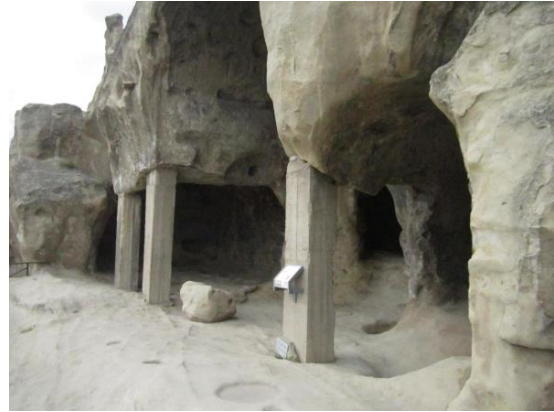
Versterking met betonnen palen (MR)
