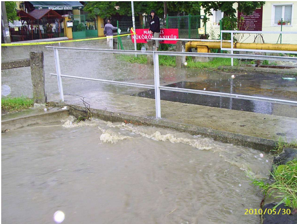
Az Orsovai utcai híd feltelt szelvénye (forrás: FCSM ZRt.)
