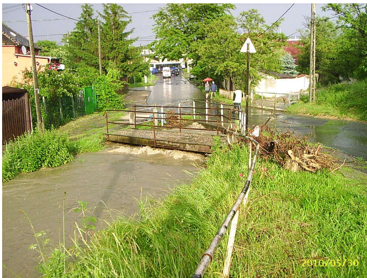
49. ábra: Az Ady Endre út alatti áteresz visszaduzzasztása (forrás: FCSM ZRt.)
