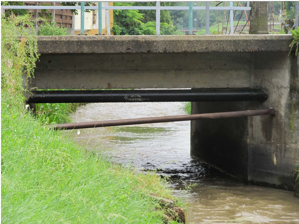
15. ábra: Orosvai utcai hídnnyílás
