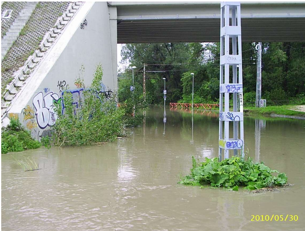
A átereszt megkerülő víz a Balatoni úti felüljáró alatti elöntötte a villamospályát (forrás: FCSM ZRt.)
