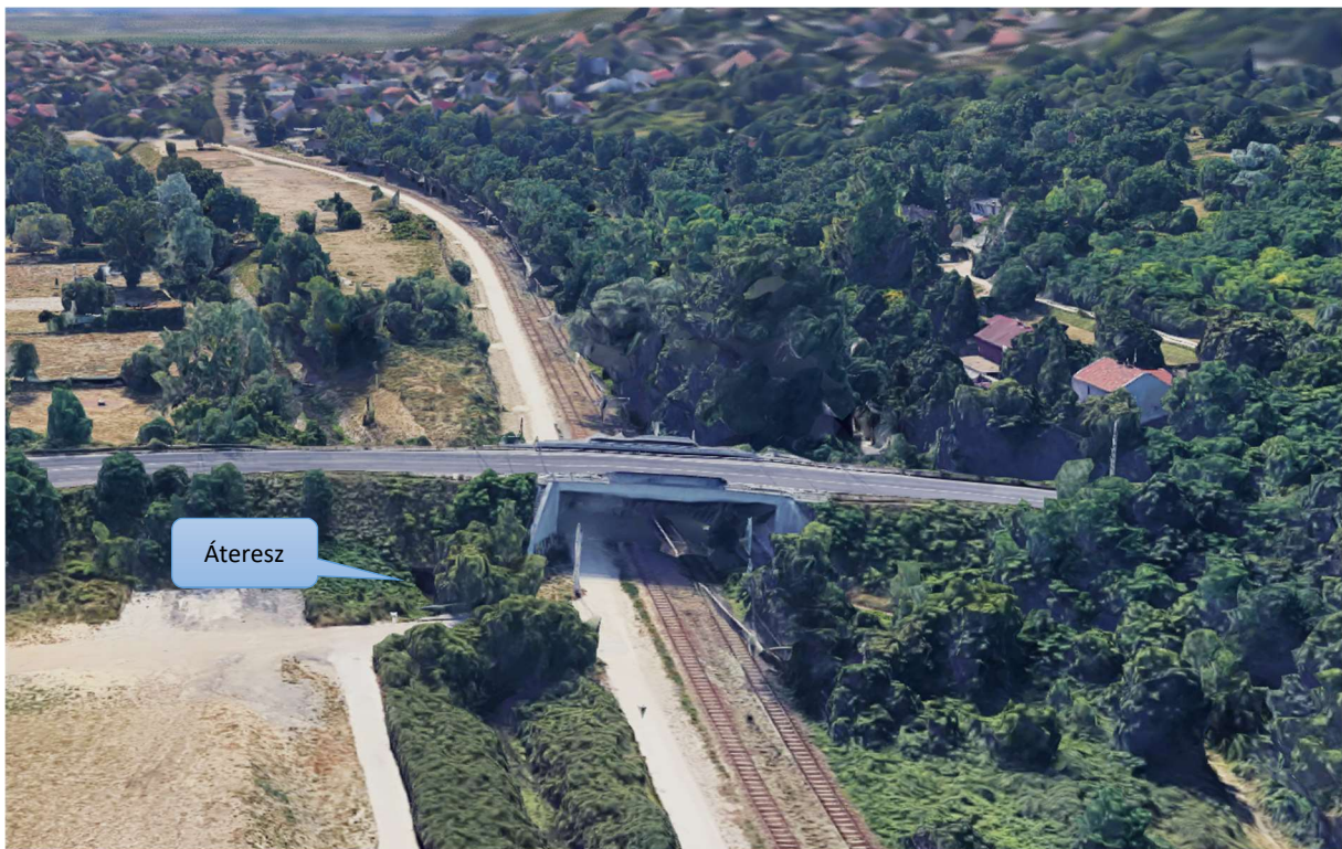
40. ábra: A Hosszúréti-patak áteresze a Balatoni út alatt (forrás: Google Maps)
