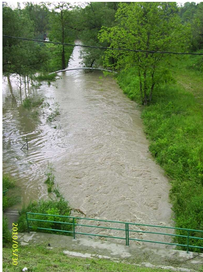
A Balatoni úti felüljáró alvízi oldala, a korlát alatt található az áteresz nyílása (forrás: FCSM ZRt.)
