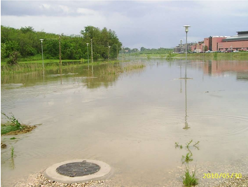
Kána-tó és a Tópark épületei a Balatoni út felől, balra az elöntött villamospálya (forrás: FCSM ZRt.)
