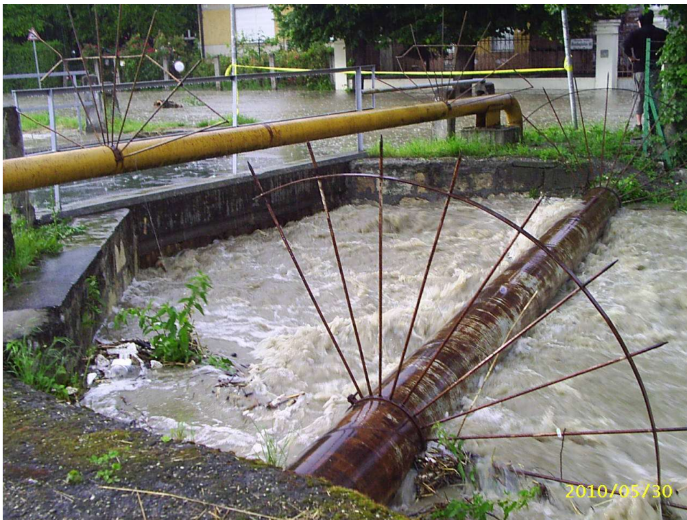
Az Orsovai utcai híd feltelt szelvénye az alvíz felől (forrás: FCSM ZRt.)
