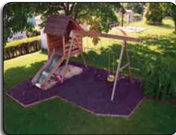
Figura 3-3. Instalación de relleno suelto de hule molido Foto cortesía de American Rubber Technologies, Jacksonville, Florida
