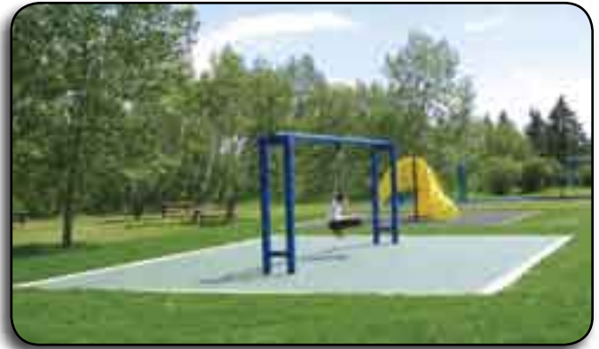
Figura 3-5. Instalación de baldosas entrelazadas Foto cortesía de Calgary, Canada Parks and Recreation
