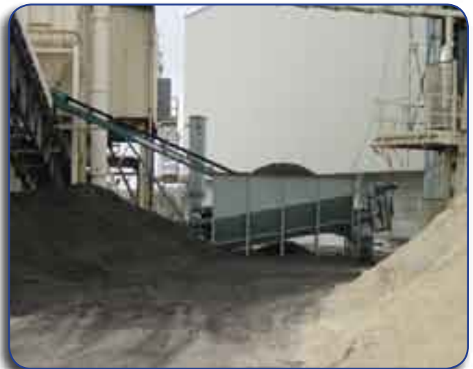
Sistema de medición para introducir CDL a la mezcla de madera antes del procesamiento Foto cortesía de Terry Gray, TAG
