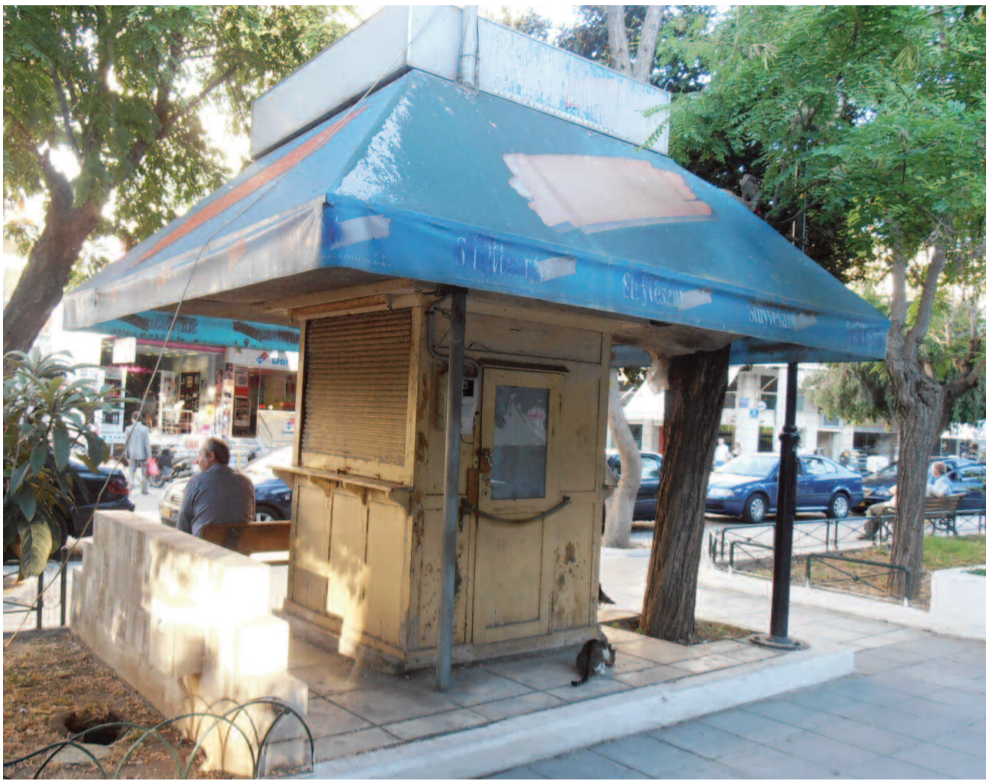
Τη μετατροπή ενός από τα κλειστά περίπτερα σε κέντρο τουριστικής προβολής ζητά η Ένωση Τουριστικών Καταλυμάτων, ενώ γι' αυτό που διατηρείται στην αρχική του μορφή από τη δεκαετία 1950 - 1960, με τα κυματιστά ρολά και την ξύλινη κατασκευή του, προτείνει να χαρακτηριστεί διατηρητέο και να συντηρηθεί κατάλληλα.
