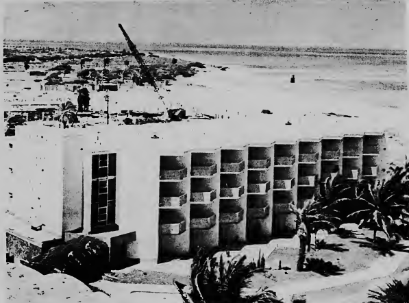
Diasabra atardi ultimo e parti nobo di Aruba Caribbean Hotel Casino a keda Inaugura oficialmente pa gobernador di Antillas, senor Mr. N. Debrot. E parti nobo aki tin ochenta kamber. El a worde construi pa e firma di Petrona & Croes.
