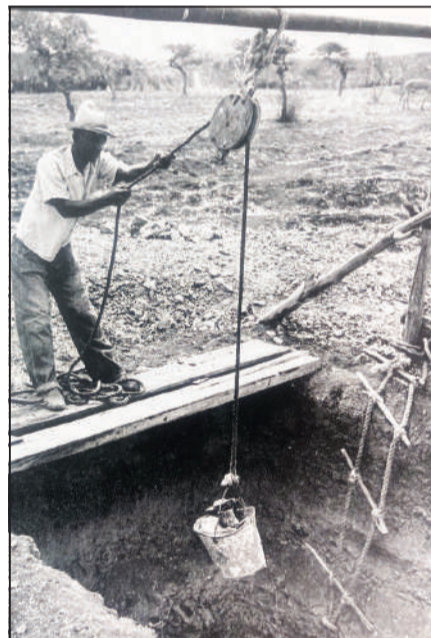
Kobamentu di pos. Normalmente dos persona tabata hasi e trabou. Un persona ta koba i otro ta hala e tera òf piedra trese ariba.
